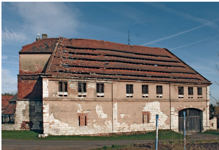
3.4 Sušicí půda s pásovými vikýři a polopatro s žaluziovými okenicemi větracích otvorů, hvozdová sušárna v obci Dobříčany na p. č. 20, foto: Roman Švec 2016.
