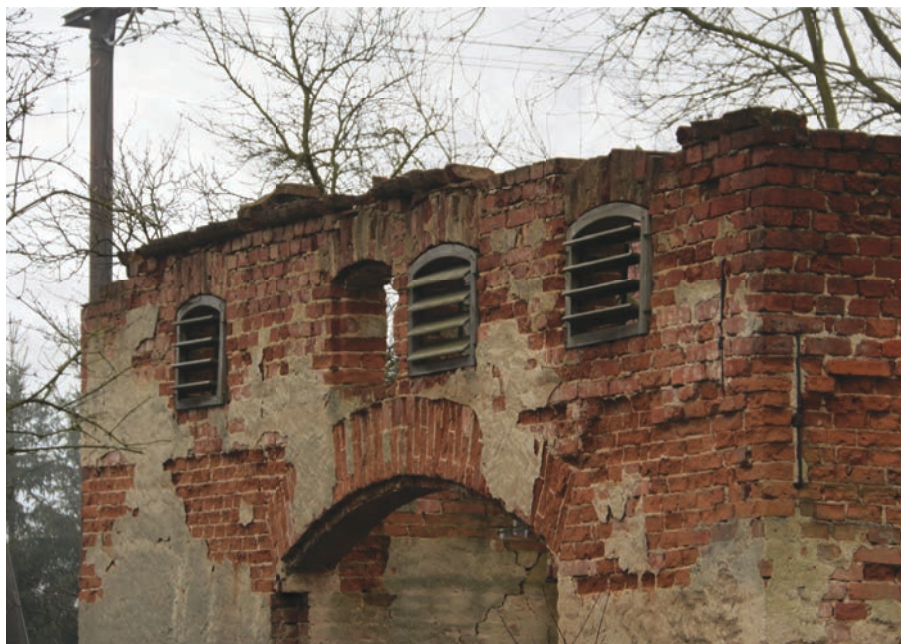
3.12 Pohled na žaluziové výplně, pasivní sušárna chmele v obci Habřina u Úštěku, p. č. 16, foto: Roman Švec 2018.
