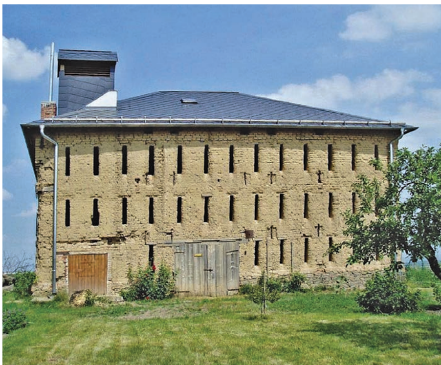
7.4 Komorová sušárna chmele v obci Odrlice u č. p. 4 sušila původně tzv. studenou cestou, na hvozdovou sušárnu byla přestavěna až v roce 1928, foto: Jiří Kaláb 2018.
