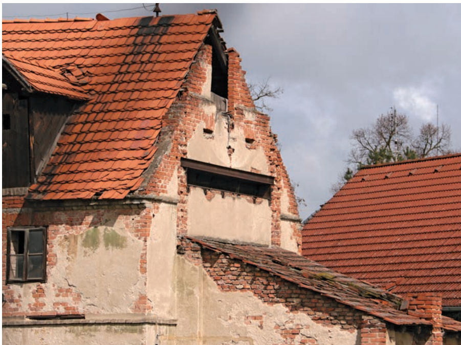
2.3 Sušárna chmele v obci Hořesedly, p. č. 86, s již částečně odbouraným věžovým hvozdem. Zanikla dvě podlaží se sušící komorou, žaluziemi a hřebenovým větrákem. Štitový tahový komín je dochován v reliktu, foto: Roman Švec 2017.
