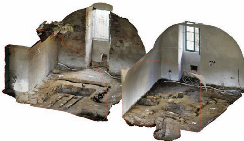
4.5 Řez 3D modelem z průsekové fotogrammetrie, Lobeč, č. p. 34 – pivovarský valach, autoři: Jan Horák, David Skalický 2017.
