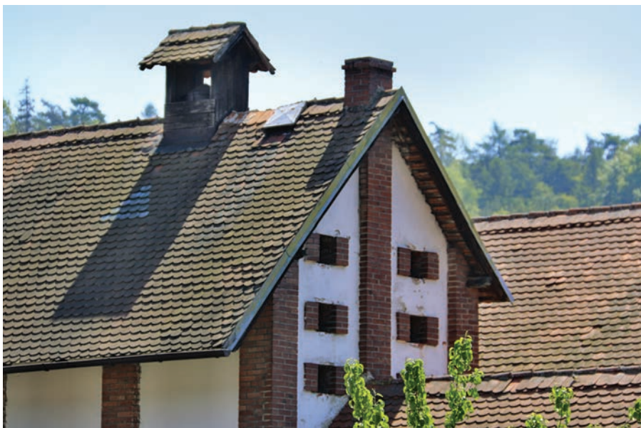
3.6 Pohled na bedněný hřebenový větrák / výparník, sušárna chmele v obci Úlovice, p. č. 30, foto: Roman Švec 2017.
