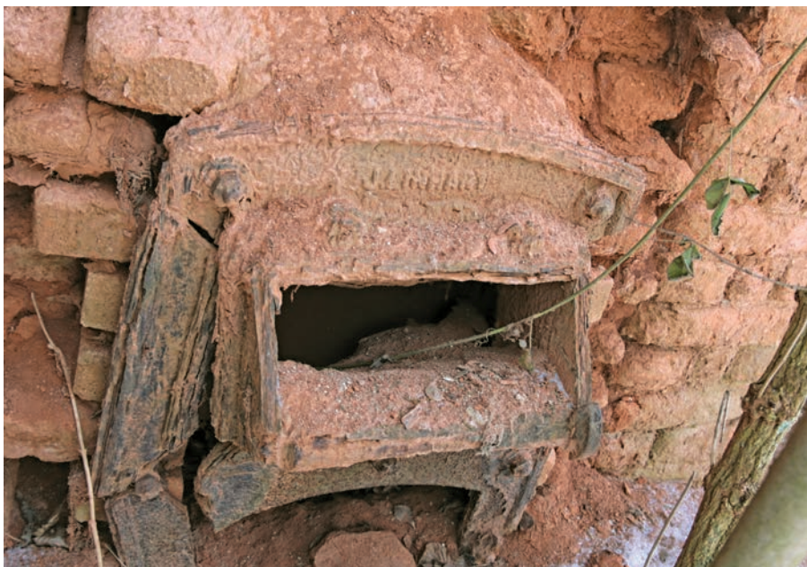
3.16 Litinové hrdlo topeniště patentu Linhart, dům se sušárnou chmele v obci Nová Ves u Kolečovic, p. č. 86, foto: Roman Švec 2017.
