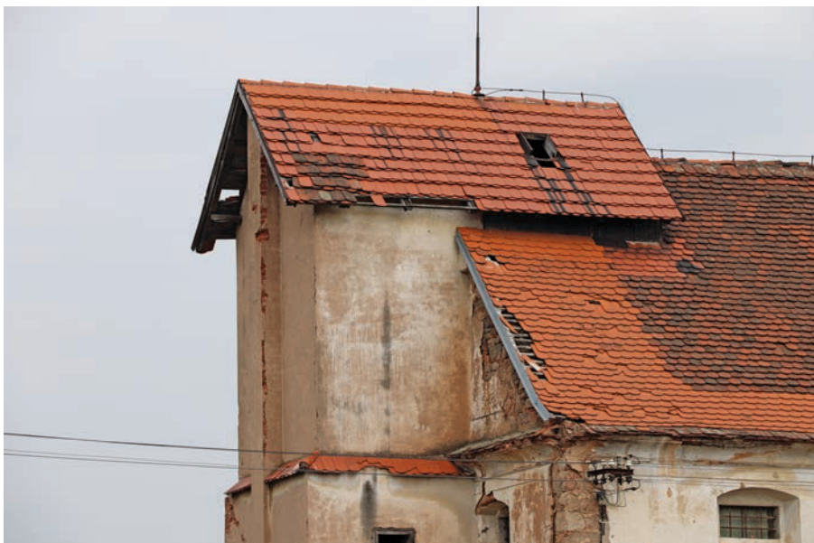
2.2 Sušárna chmele v obci Krty, p. č. 5/1, dva markantní znaky střešní krajiny věžového hvozdu – komín a hřebenový větrák – byly při položení nové krytiny odstraněny, foto: Roman Švec 2019.
