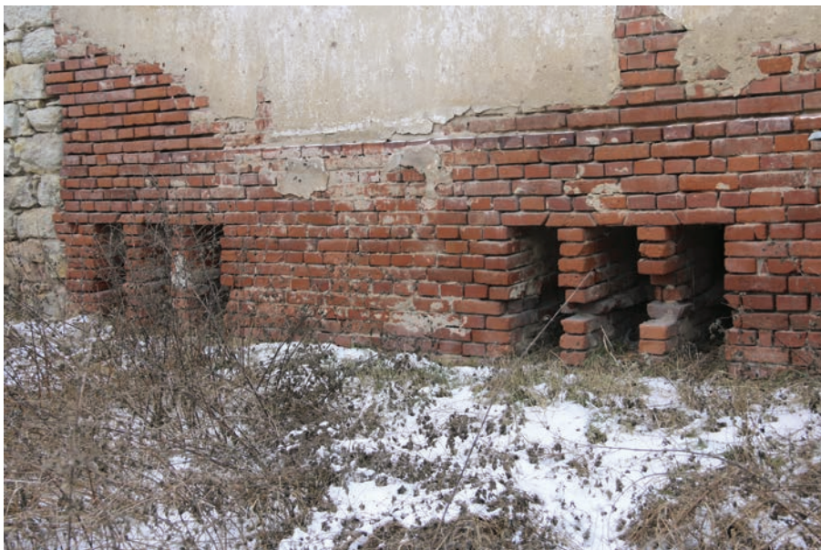
3.11 Detail přísávacích otvorů hvozdu, sušárna chmele v obci Mory, p. č. 384, foto: Roman Švec 2017.
