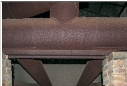
010 – Pohled na teplovzdušný rozvod
