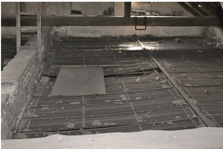
3.17 Pohled do sušící komory na ocelové žaluzie, hvozďová sušárna v obci Hořesedly, p. č. 15-13, foto: Roman Švec 2017.
