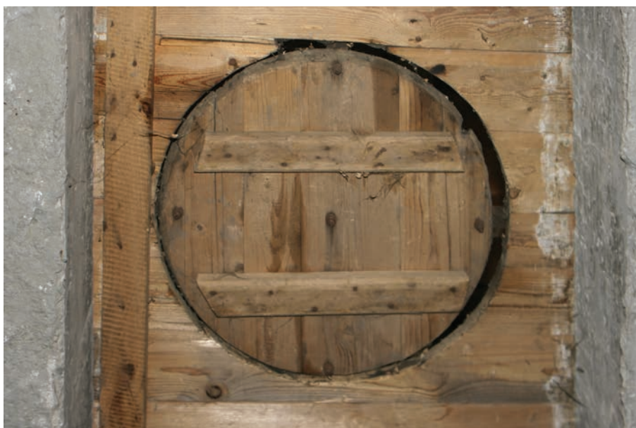
3.19 Detail žokovacího otvoru, sušárna chmele v obci Kněževy, p. č. 792-1, foto: Monika Stará 2017.
