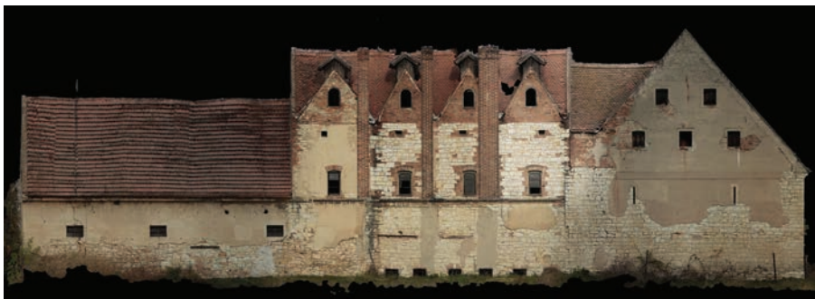
4.1 Ortofotomosaika jižního průčelí čtyřhvozdové sušárny chmele v Trnovanech u Žatce, č. p. 9, autoři: Jan Horák, David Skalický 2017.
