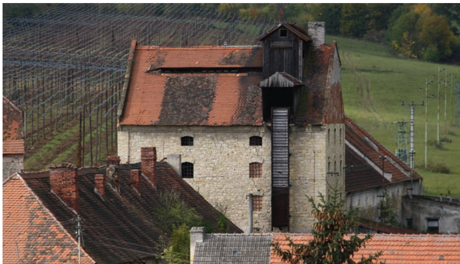
2.9 Sušárna chmele v kontextu chmelařské obce Nečernice, p. č. 1/1, foto: Jaroslav Skopec 2017.
