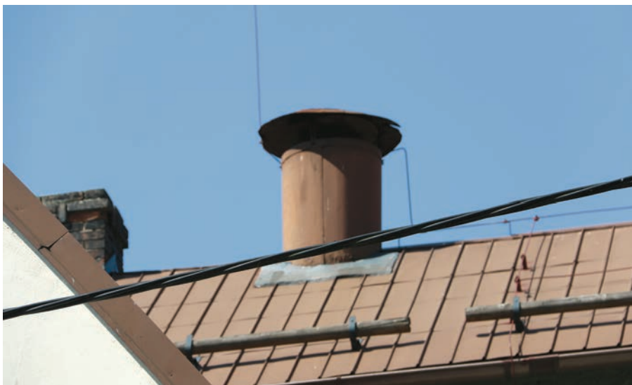
3.7 Detail plechového hřebenového větráku / výparníku, sušárna chmele v obci Úlovice, p. č. 25-1, foto: Roman Švec 2017.
