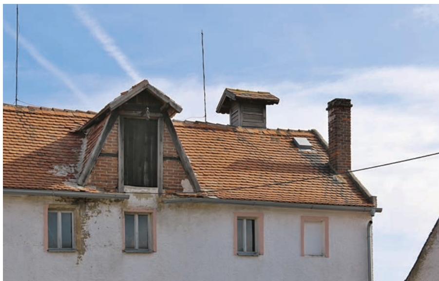
3.10 Pohled na hrázděný manipulační vikýř, sušárna chmele v obci Radíčeves, p. č. 21-4, foto: Roman Švec 2017.
