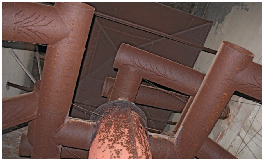
2.6 Detail konstrukce vytápění hvozdu, sušárna chmele v obci Kněževes, p. č. 127, foto: Roman Švec 2017.
