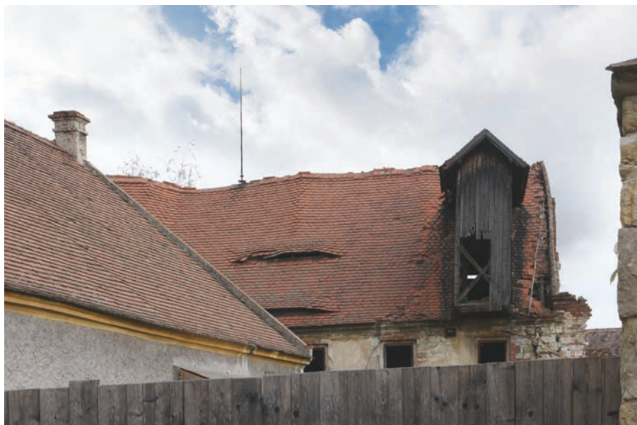
3.9 Pohled na bedněný manipulační vikýř, sušárna v obci Líčkov, p. č. 31-1, foto: Roman Švec 2018.
