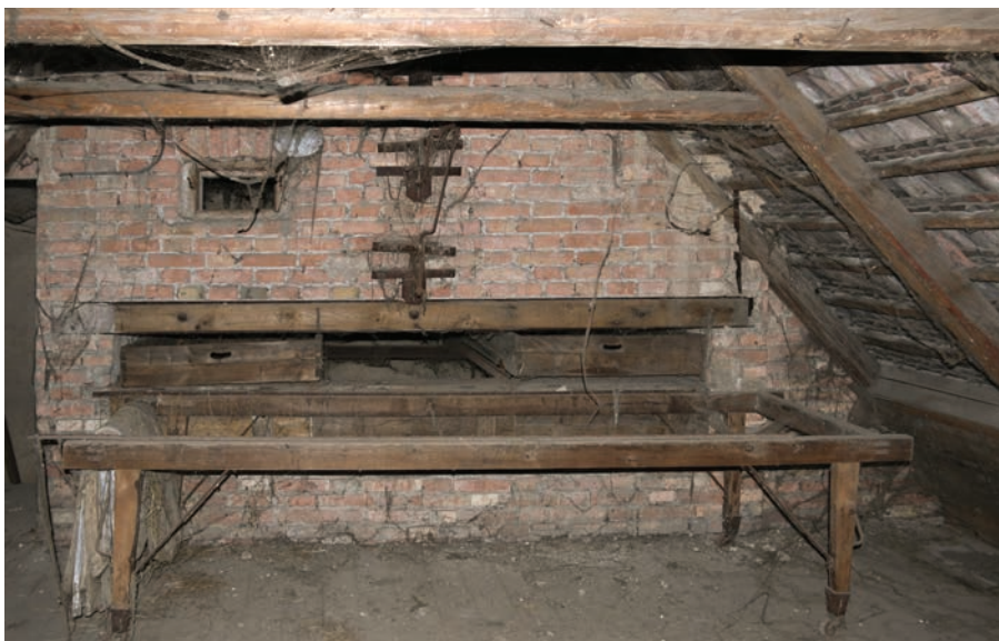
3.18 Manipulační prostor hvozdu s lísami a vozíkem, sušárna chmele v obci Zahořany, p. č. 35-1, foto: Roman Švec 2017.
