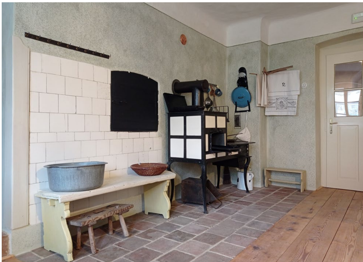
Obr. 5. Plzeň-Bolevec, selský statek U Matoušů čp. 1. Dvířka sázecího otvoru chlebové pece v kuchyni. Stav před obnovou viz obr. 6 u příspěvku L. Foster a F. Kasla „Rok na vsi“: Archeologický výzkum selského dvora. (Foto M. Kolovský, 2021)
