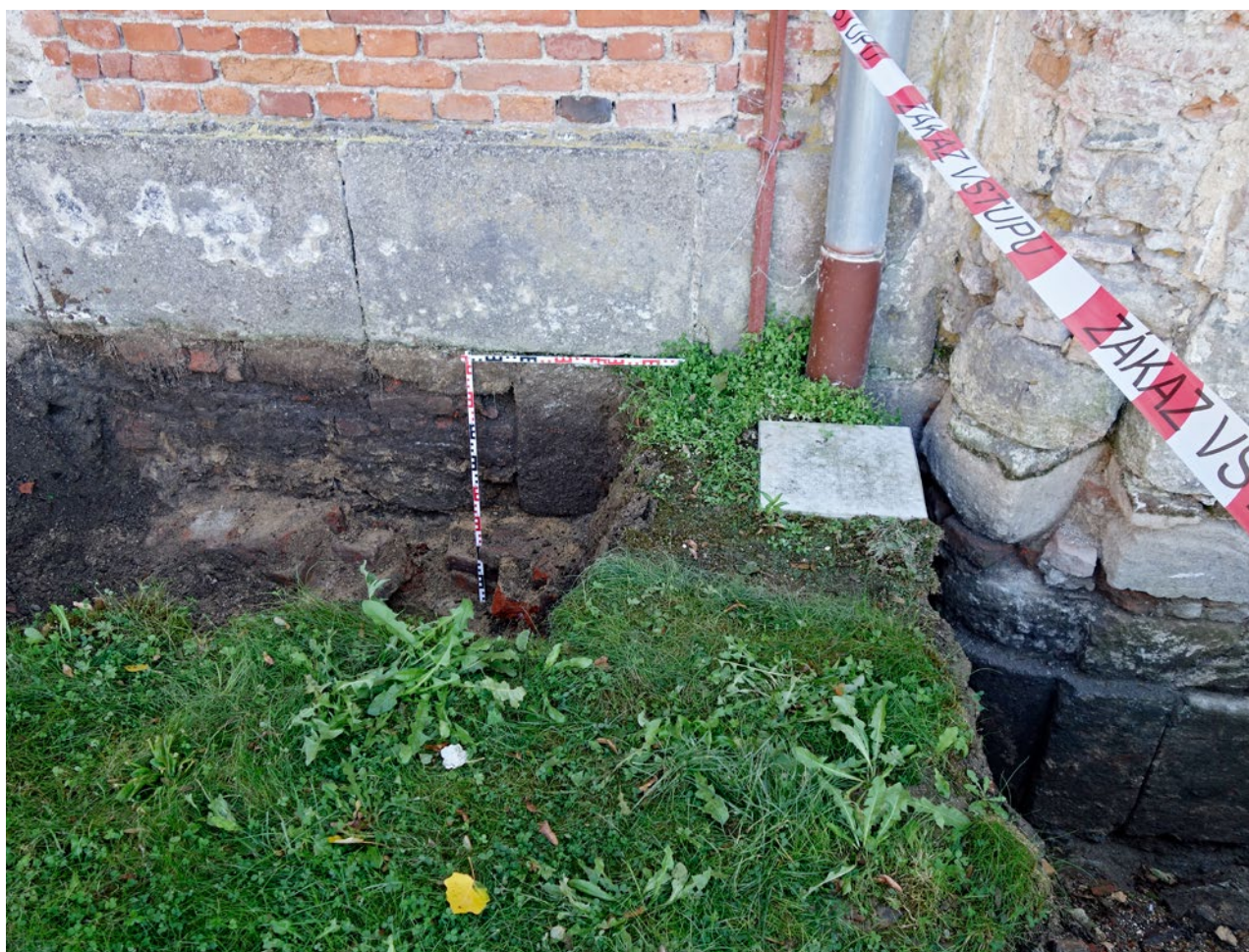
Obr. 4. Kladruby, klášter. Sonda v místě napojení nárožního rizalitu se salou terrenou (vpravo) na stěnu nového konventu (vlevo). Spodní úroveň soklů svědčí o snížení terénu před salou terrenou o 1,2 m oproti předchozí výškové úrovni již v období baroka. Pohled od severu. (Foto L. Foster, 2018)
