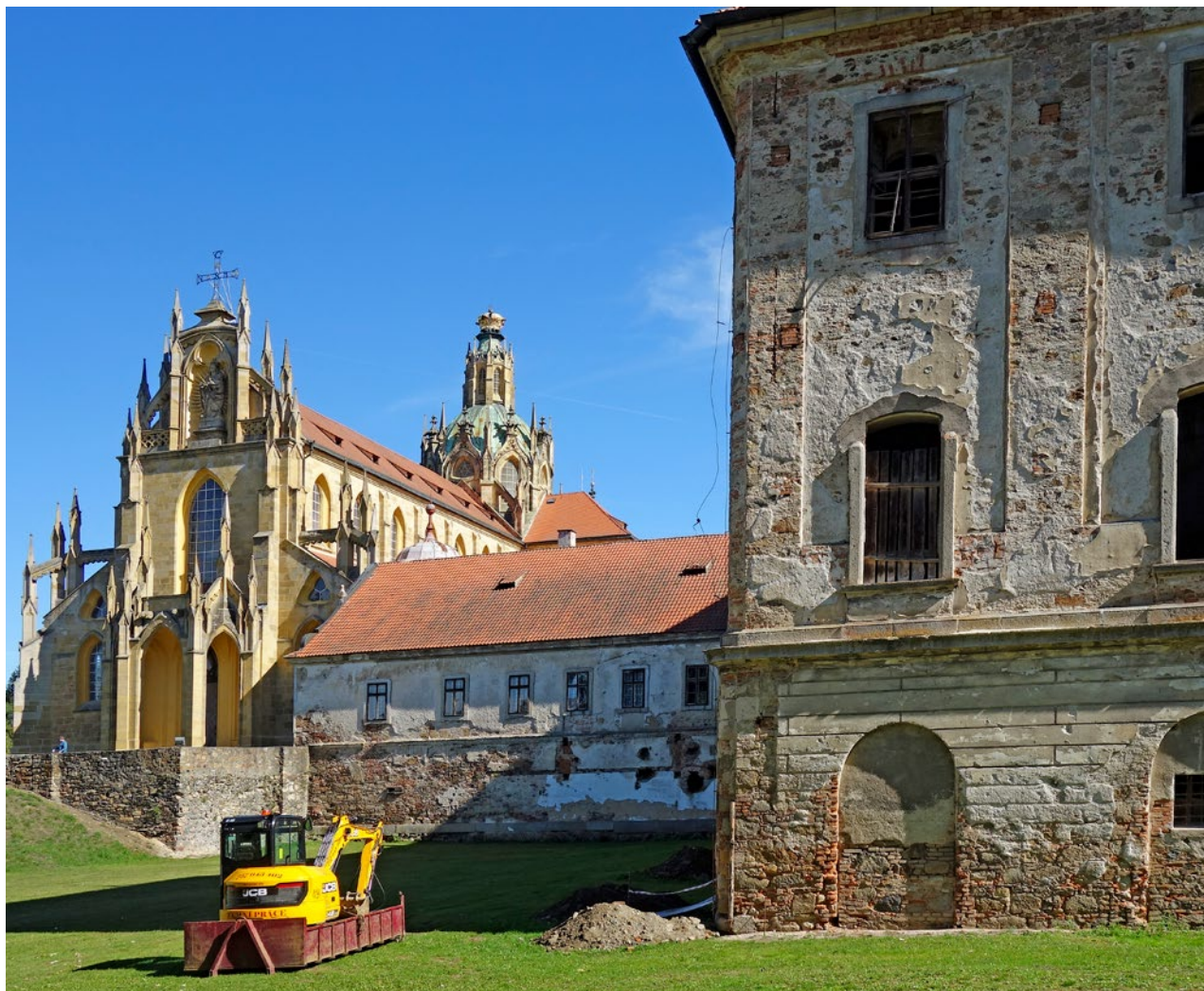
Obr. 1. Kladruby (okr. Tachov), klášter. Vpravo nárožní rizalit nového konventu se salou terrenou, pohled od západu. (Foto L. Foster, 2018)
