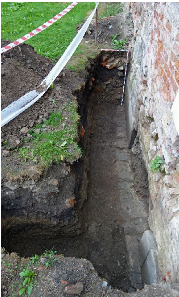
Obr. 2. Kladruby, klášter. Sonda u severní fasády sály tereny. Barokní povrch terénu odpovídal spodní úrovni žulového soklu, pod ním na dně sondy rozšířený základ. Pohled od západu. (Foto L. Foster, 2018)
