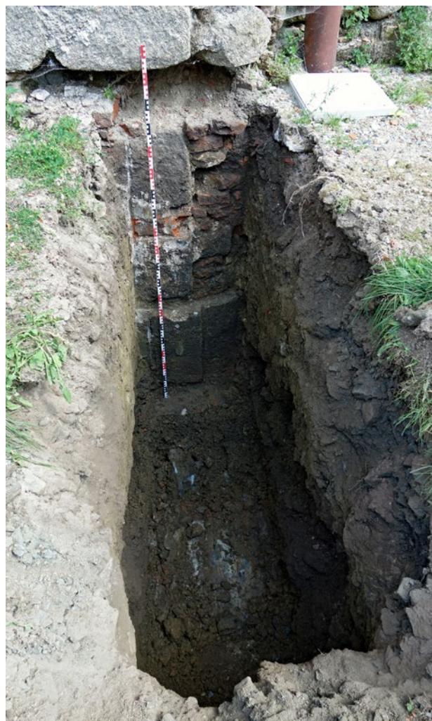
Obr. 3. Kladruby, klášter. Sonda u jihozápadního nároží sály tereny. Na dně odhalen rozšířený základ stěny a profilovaný žulový sokl. Při spodní úrovni soklu byl barokní povrch terénu. Pohled od západu. (Foto L. Foster, 2018)
