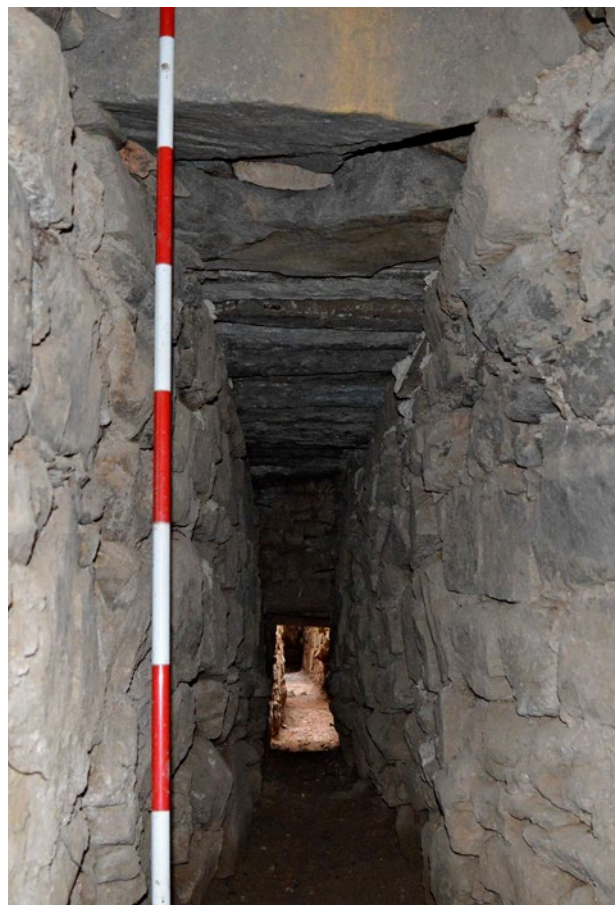
Obr. 7. Plasy, klášter, štolka Q. Počáteční úsek kanálu – první dva překlady jsou dochovány in situ, zbývající byly doplněny v roce 2018. V zadní části snímku patrné čelo konstrukce se sníženou výškou stropu. (Foto M. Waldmannová, 2019)
