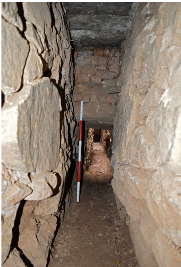
Obr. 8. Plasy, klášter, štola Q. Pohled na severní čelo konstrukce se sníženou výškou stropu. (Foto M. Waldmannová, 2019)
