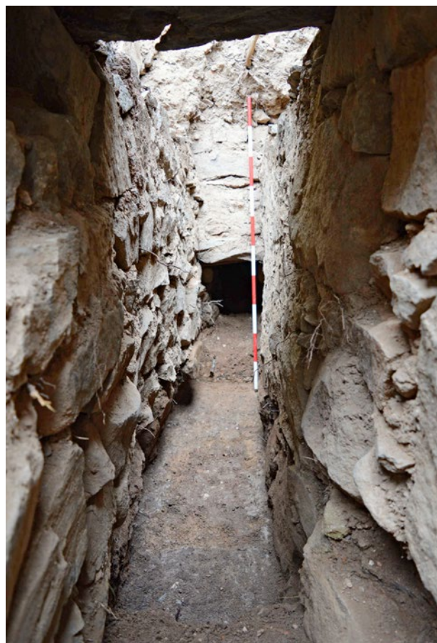
Obr. 9. Plasy, klášter, štola Q. Pohled na jižní čelo konstrukce se sníženou výškou stropu. Dno kanálu – zásyp je vytěžen na základovou spáru bočních zdí kanálu, na dně nebyly dokumentovány žádné stopy po dláždění či jiné úpravě. (Foto M. Waldmannová, 2019)
