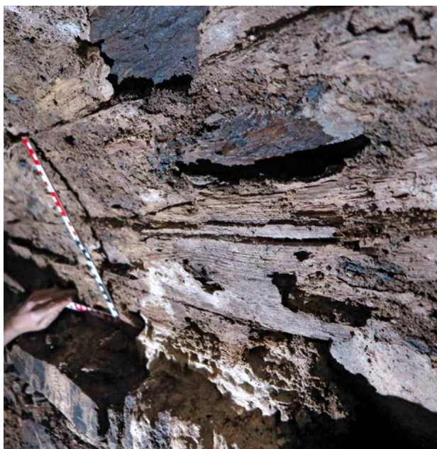
Obr. 27. Plasy, klášter, štola Q. Klenba chodby mezi šachtami Š2 a Š3 s dochovanými otisky po dřevěném šalování. (Foto M. Kohnáš, 2018)
