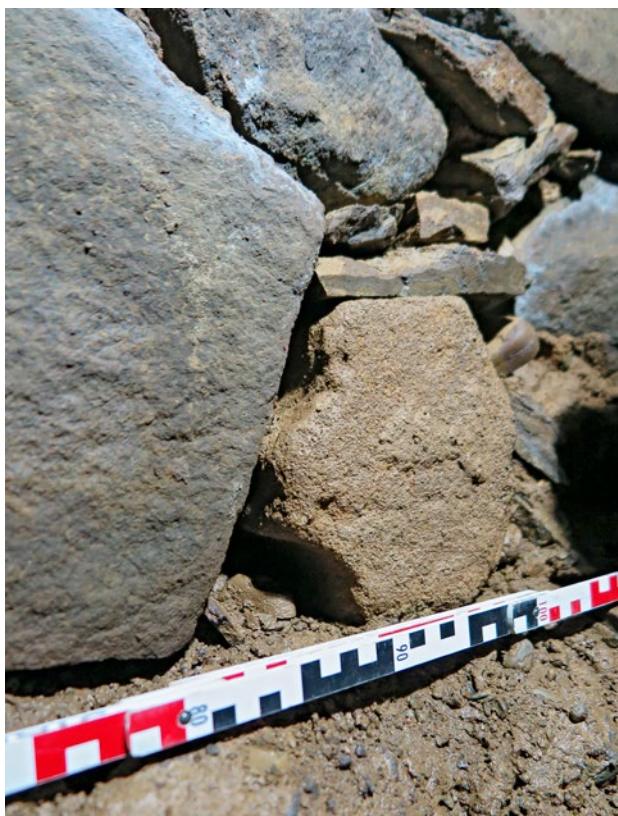
Obr. 29. Plasy, klášter, štola Q. Užití architektonických článků – detail gotického žebra ve zdivu první části boční štoly Q2. (Foto T. Karel, 2018)
