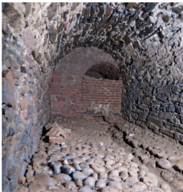
Obr. 16. Plasy, klášter, štola Q. Q2 – sklep. Celkový pohled od jihozápadu. Vzadu patrná zadržívka, která byla později odstraněna (obr. 17). (Foto T. Karel, 2018)
