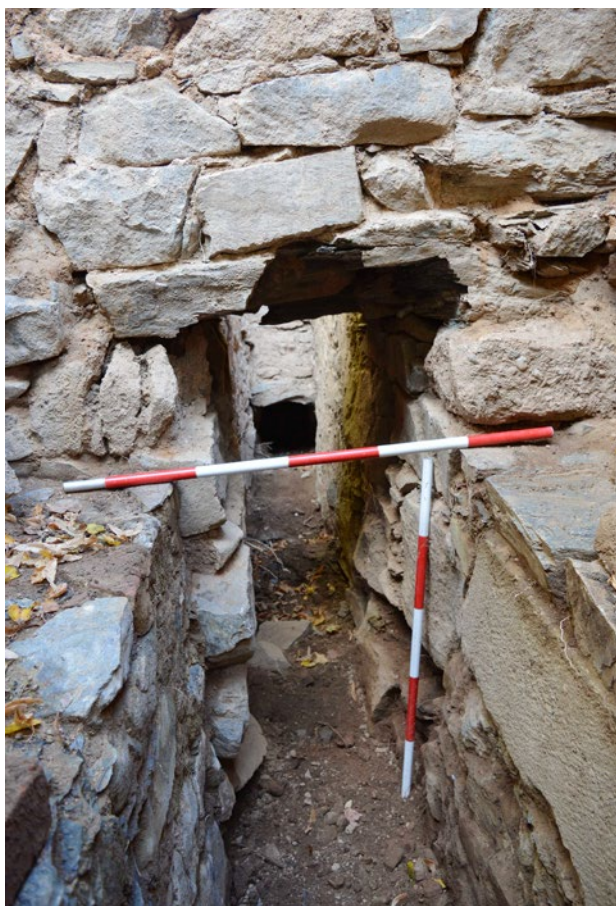
Obr. 10. Plasy, klášter, štola Q. Kolmo přes kanál přechází pozůstatek zdiva zaniklého objektu, skrz zdivo zjištěna dutina (obr. 11). Na snímku vlevo patrné dodatečné napojení boční zdi kanálu – pravděpodobně přezdivíváno v rámci oprav v blíže neurčené době. Pohled od jihu. (Foto M. Waldmannová, 2019)
