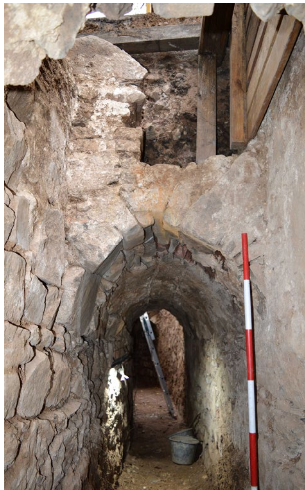
Obr. 24. Plasy, klášter, štola Q. Šachta Š3, žlabovitý útvar na koruně zdíva severní stěny šachty (vpravo nahoře), pohled od jihu. (Foto M. Waldmannová, 2019)
