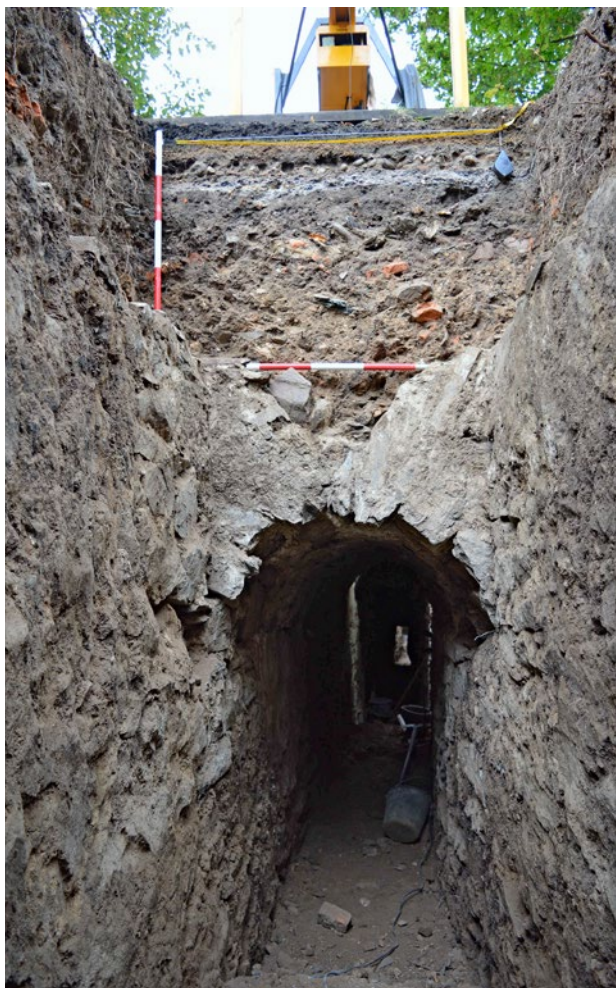
Obr. 23. Plasy, klášter, štola Q. Šachta Š2, žlabovitý útvar na koruně zdíva jižní stěny šachty, pohled od severu. (Foto M. Waldmannová, 2019)
