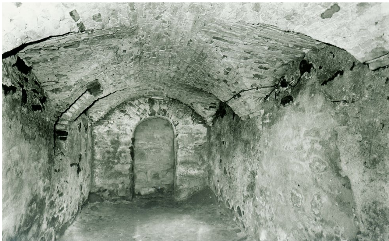
Obr. 3. Plasy, klášter, štola Q. Suterén patrové Královské kaple, pohled na zazděný otvor v západní stěně. (Fotodokumentace pro stavebně historický průzkum, SÚRPMO, 1980)
