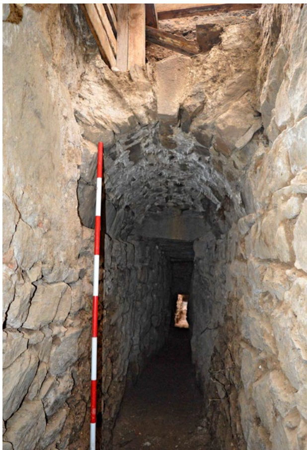
Obr. 6. Plasy, klášter, štolka Q, šachta Š3. Pohled od severu – v průhledu patrná změna zastropení z klenby v rovný překlád. Nahoře patrná úprava koruny zdíva – žlabovitý útvar nad klenbou. (Foto M. Waldmannová, 2019)
