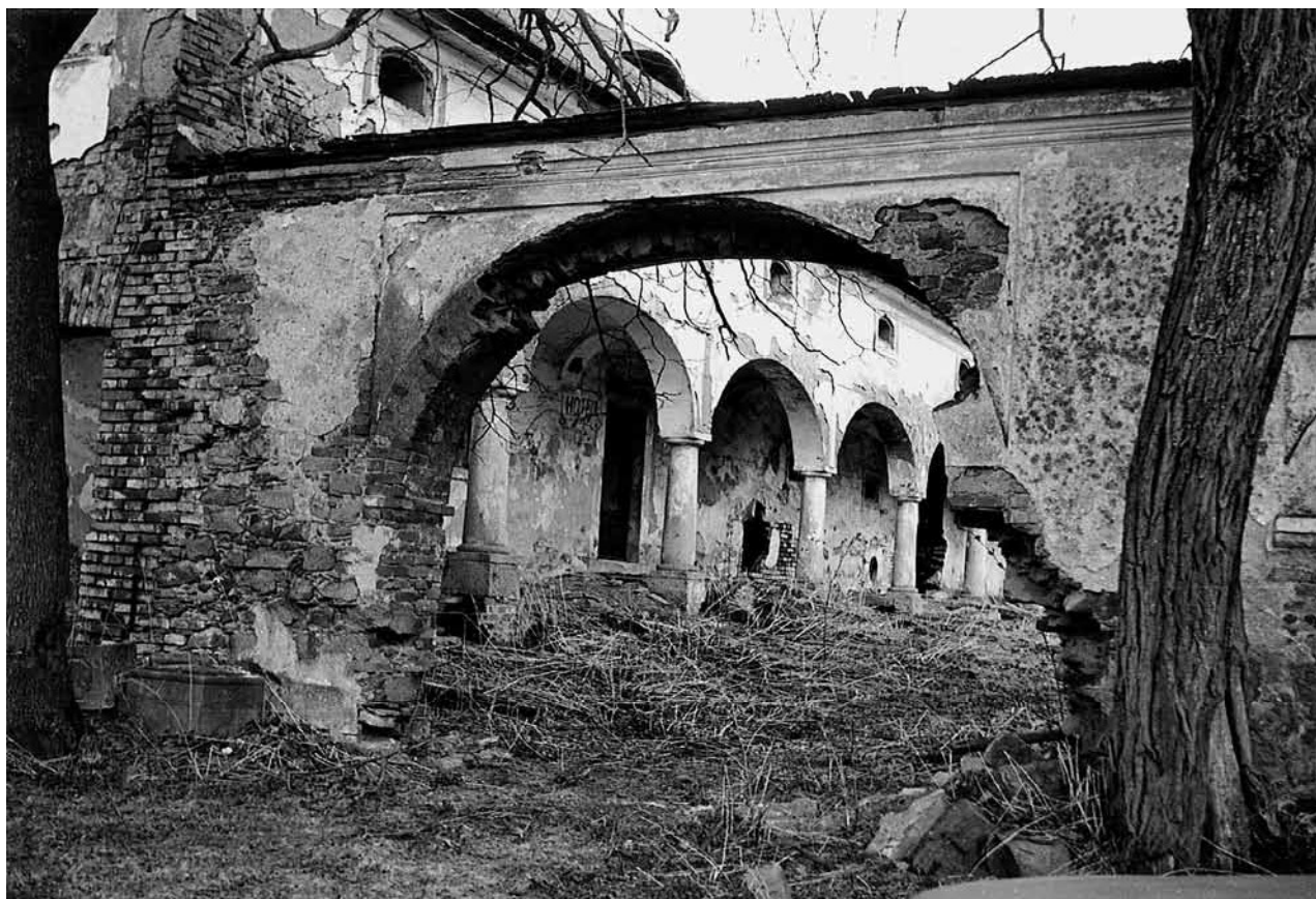
Obr. 10. Vysočany u Ovesných Kladrub, usedlost čp. 7. Průhled bránou do dvora na hlavní dům s arkádovým zápražím. Vzadu v pátém oblouku arkády vestavěný psí kotec. (Muzeum Cheb, foto P. Šebesta, 1978)
