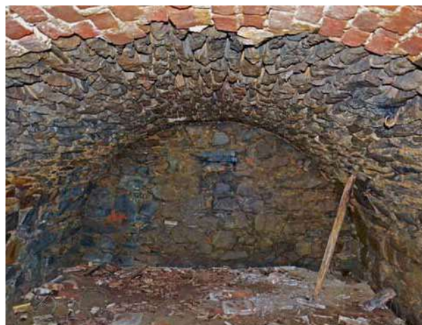
Obr. 24. Vysočany u Ovesných Kladrub, usedlost čp. 7. Starší sklep pod chlévem výměnku, pohled na jižní stěnu. V popředí novější cihelná klenba při vstupní šíji. (Foto K. Knotová, 2013–2014)
