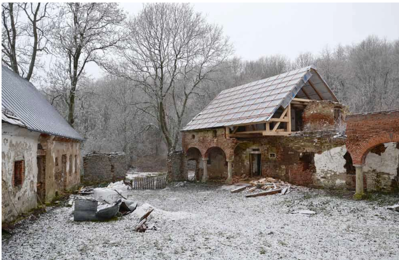
Obr. 18. Vysočany u Ovesných Kladrub, usedlost čp. 7. Západní část dvora. Dvě arkády zápraží směrem k ohradní zdi jsou původní, zadaní dvě nově vyzděny. (Foto K. Knotová, 2013–2014)
