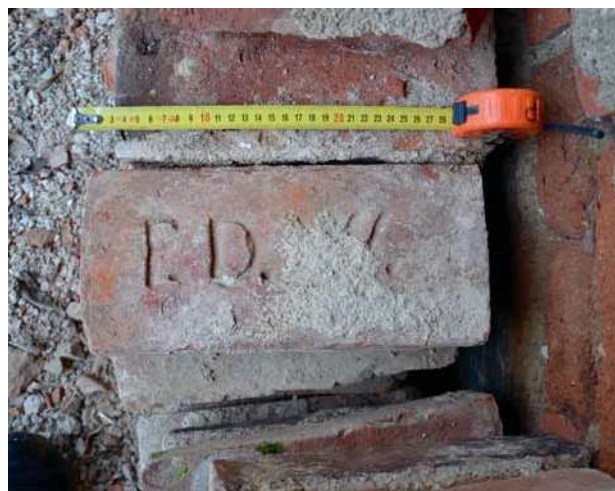
Obr. 22. Vysočany u Ovesných Kladrub, usedlost čp. 7. Cihla s kollem F. D. W. pocházející z vlastní cihlářské pece hospodáře a stavebníka Franze Denka. (Foto K. Knotová, 2013–2014)
