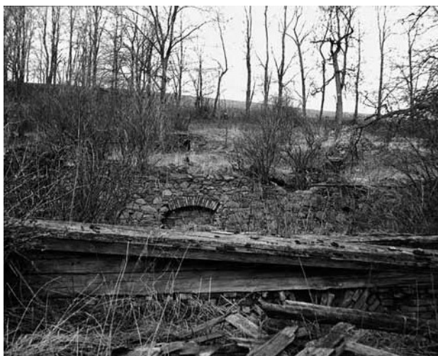
Obr. 13. Vysočany u Ovesných Kladrub, usedlost čp. 7. Zbytky hospodářských budov v zadní části dvora. (Muzeum Cheb, foto P. Šebesta, 1978).
