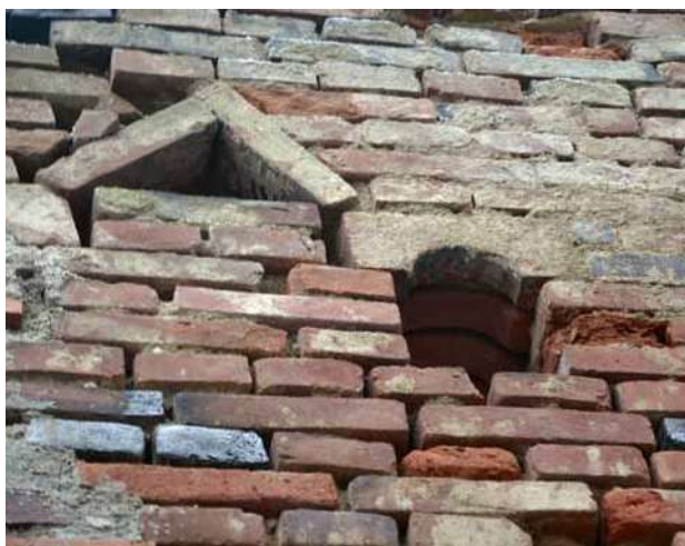
Obr. 21. Vysočany u Ovesných Kladrub, usedlost čp. 7. Východní (zadní) štítové průčelí hlavního domu - detaily otvorů zřejmě do holubníku v půdním prostoru nad arkádovým zápražím. (Foto K. Knotová, 2013–2014)
