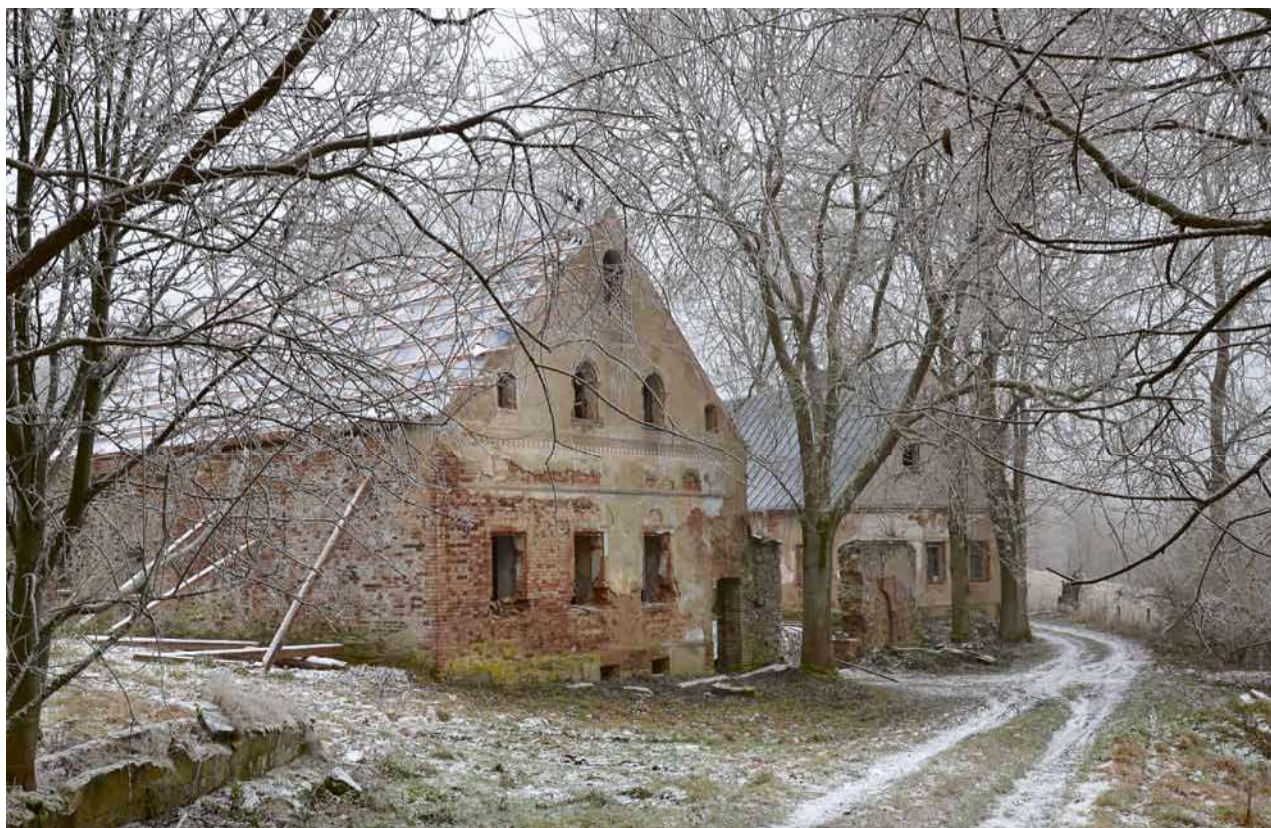
Obr. 17. Vysočany u Ovesných Kladrub, usedlost čp. 7. Pohled od severozápadu. (Foto K. Knotová, 2013–2014)
