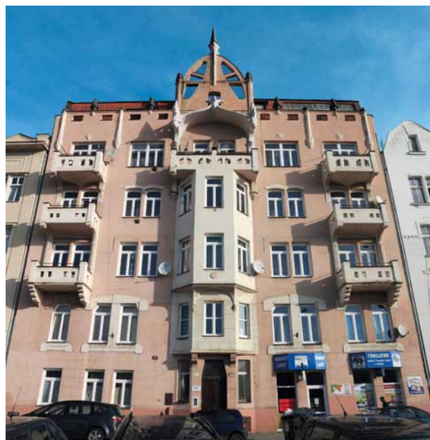
Obr. 10. Plzeň – Jižní Předměstí. Hálkova ulice. Dům čp. 1228. Uliční průčelí. (Foto K. Kuča, 2013)
