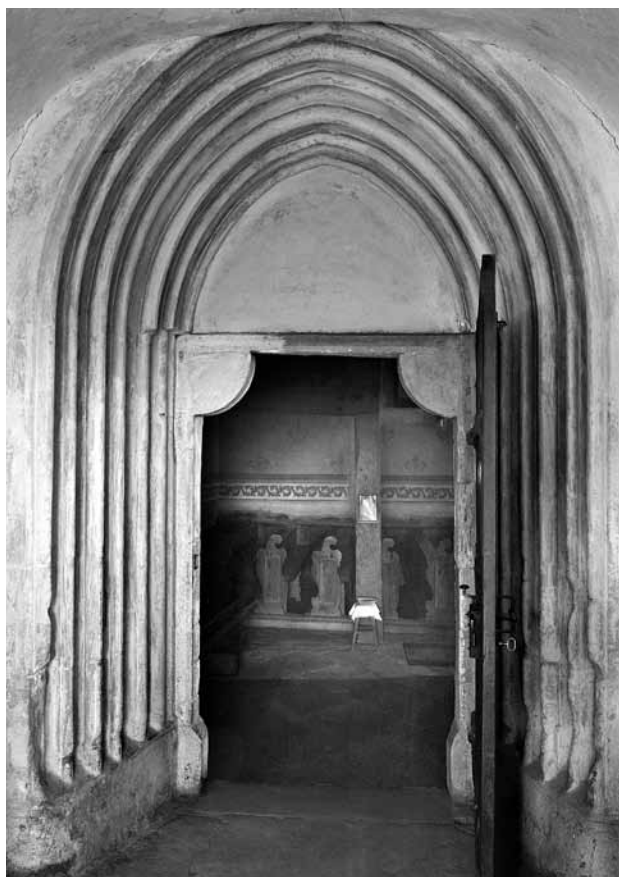
Obr. 20. Bukovec, kostel Nanebevzetí Panny Marie. Jižní portál do lodi. (Fotoarchiv Národního památkového ústavu, generální ředitelství, foto Č. Šíla, 1975)
