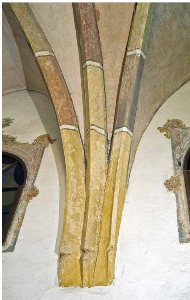
Obr. 16. Blížejov, kostel sv. Martina. Pohled do severozápadní části kleneb v presbyteriu s potrojným výběhem klenebních žebér na rozhraní křížové klenby a klenby paprčité. (Foto R. Kodera, 2011)
