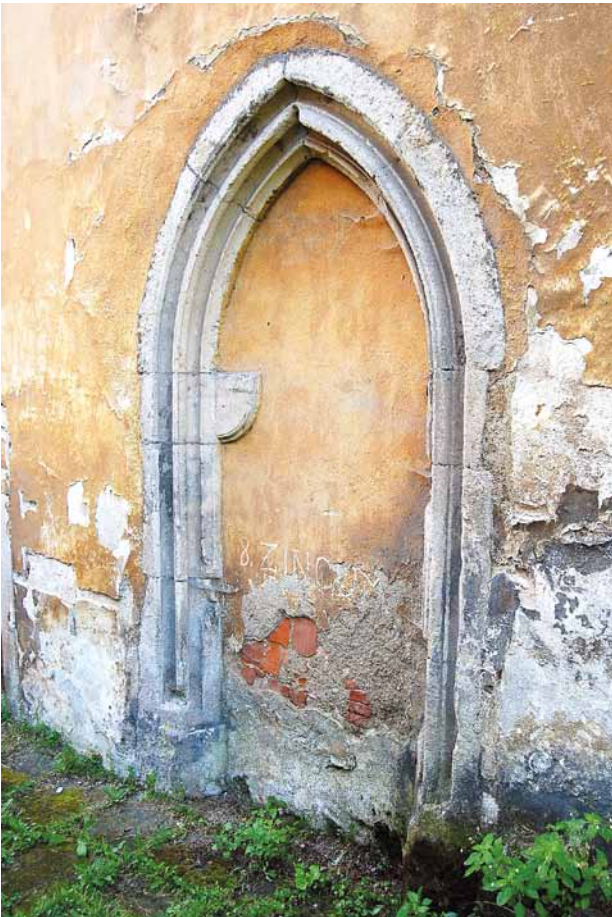
Obr. 25. Plasy (okr. Plzeň-sever), bývalý cisterciácký klášterní kostel Nanebevzetí Panny Marie. Zazděný portál v severním průčelí transeptu. (Foto P. Duchoň, 2007)
