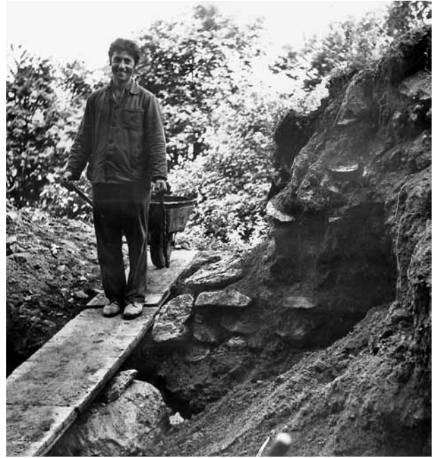
Obr. 5. Přimda, zřícenina hradu. Výkop při severní straně donjonu s odkrytou obvodovou hradbou. (Fotoarchiv Národního památkového ústavu, ú. o. p. v Plzni, foto J. Kočandrle, 1971)
