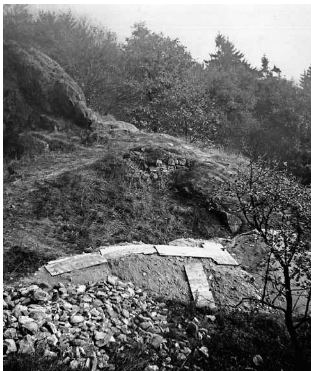
Obr. 8. Přimda, zřícenina hradu. Úprava terénu skládkou materiálu, vytěženého v roce 1971 z výkopu při východní straně donjonu, v poloze směrem na severovýchod od donjonu. V pozadí relikt obvodové hradby. Pohled od jihozápadu. Fotoarchiv Národního památkového ústavu, ú. o. p. v Plzni, foto J. Kočandrle, 1971)
