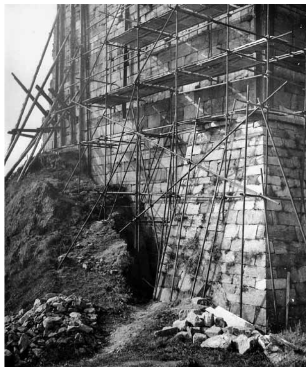
Obr. 7. Přímdu, zřícenina hradu. Výkop při východní straně donjonu. Pohled od severovýchodu. Ve výkopu je vidět osekání skály pro založení zdiva. (Fotoarchiv Národního památkového ústavu, ú. o. p. v Plzni, foto J. Kočandrle, 1971)
