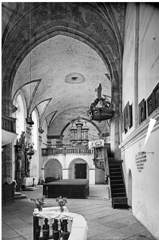
Obr. 11. Horšovský Týn, Na Vršíčku. Kostel sv. Anny. Pohled z chóru do lodi směrem k západní hudební kruchtě. Šipkou vpravo je označen pamětní nápis na stěně, jenž pocházel z doby barokní a udával vysvěcení kostela řeženským pomocným biskupem Petrem Krafftem 5. 4. 1516 (odstraněn v roce 1991). (Fotoarchiv Národního památkového ústavu, generální ředitelství, foto b. a., 1950)
