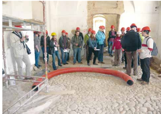
Teplá (okr. Karlovy Vary), klášter premonstrátů. Společná odborná exkurze zaměstnanců územních odborných pracovišť v Plzni a Lokti Národního památkového ústavu. Prohlídka jedné z místností v přízemí jižního křídla kvadratury barokního konventu s nálezem původní dlažby z kamených valounů. (Foto J. Kaigl, 5. 6. 2013)
