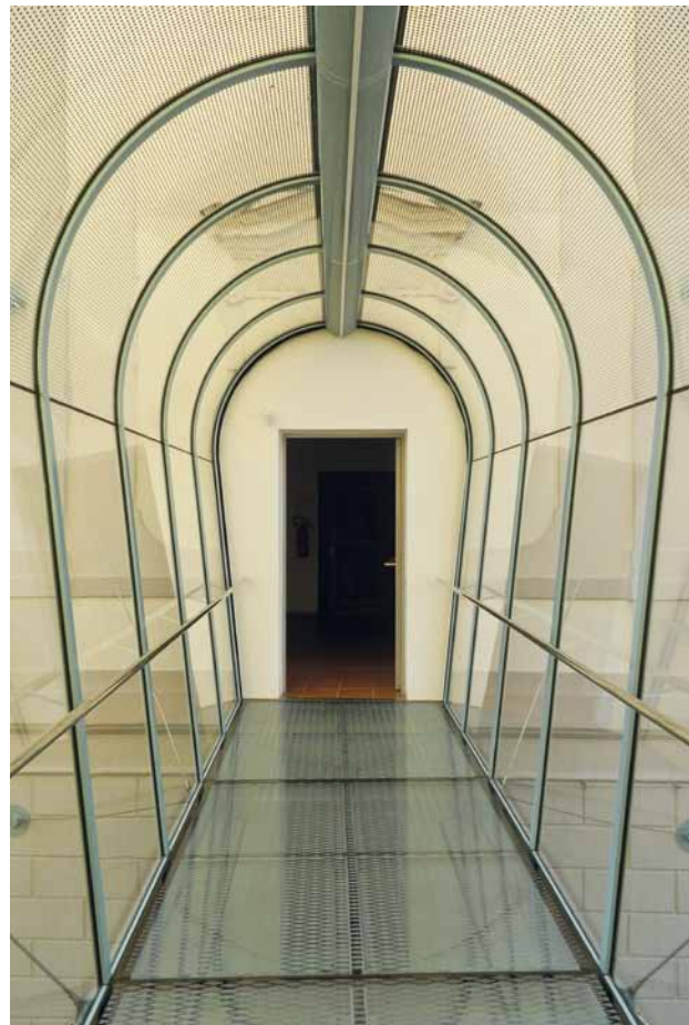
Obr. 4. Klatovy, nový spojovací mostek mezi budovami bývalého jezuitského gymnázia a jezuitské koleje. Interiér. (Foto M. Břízová, 2013)
