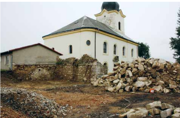
Obr. 3. Tisová, prostor uvolněný demolicí zámečku a podélného polozapuštěného jednopodlažního objektu s valenou klenbou, jenž stál mezi zámečkem a kostelem. Pohled od jihozápadu. (Foto Z. Procházka, 31. 8. 2012)
