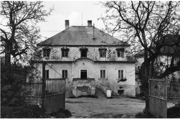
Obr. 1. Tisová (okr. Tachov), zámeček. Pohled od jihu. (Fotoarchiv Národního památkového ústavu, ú. o. p. v Plzni, foto J. Gryc, 1971)
