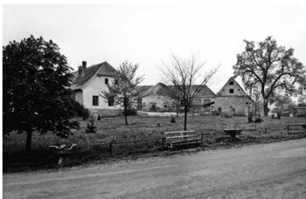
Obr. 9. Nahý Újezdec (okr. Tachov), hospodářský dvůr čp. 10. Celkový pohled z návsi. Zatravněný pozemek v popředí je místem, kde stávala budova zámku odstřeleného v roce 1964. (Fotoarchiv Národního památkového ústavu, ú. o. p. v Plzni, foto J. Gryc, 1978)
