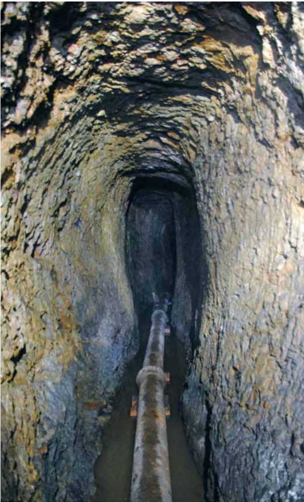
Obr. 13. Plzeň, štolu U Věch svatých, severní úsek. Profil je vytesán ve fylitu. (Foto M. Strejc, 2012)
