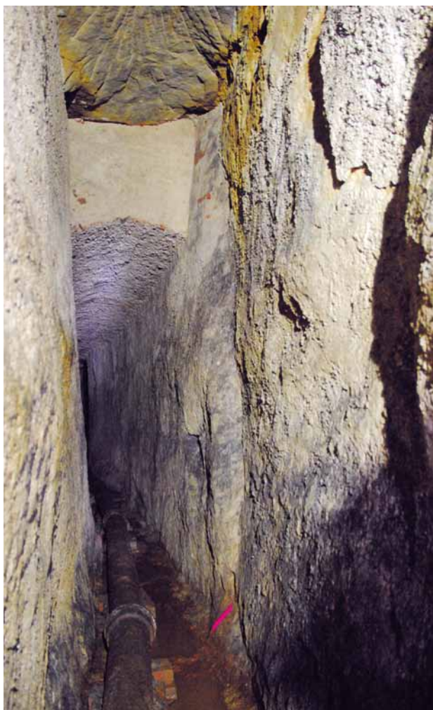
Obr. 11. Plzeň, štola U Věch svatých, střední úsek. Segmentová klenba je provedena z cihel. (Foto M. Strejc, 2012)
