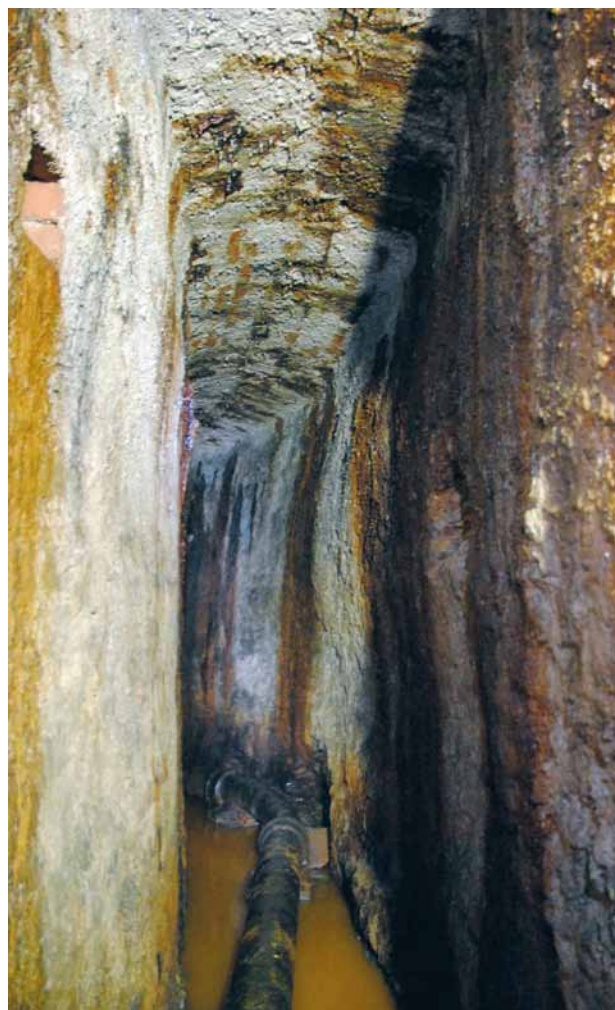
Obr. 12. Plzeň, štola U Věch svatých, střední úsek. Hrubě omítnuté cihlové přízdívky stěn, segmentová klenba. Vlevo nahoře na snímku je vidět malá osvětlovací nika. (Foto M. Strejc, 2012)
