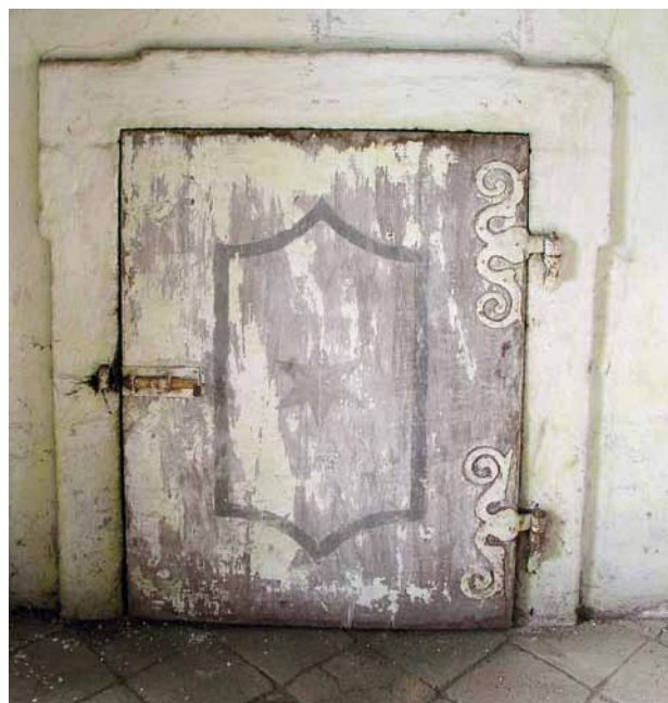
Obr. 17. Žebnice, fara. Původní kamenná dvířka s barokním kováním a viditelným vzorem – malovaný vykrajovaný rám s hvězdou plaského opatství uprostřed. (Foto P. Vlček, 2008)
