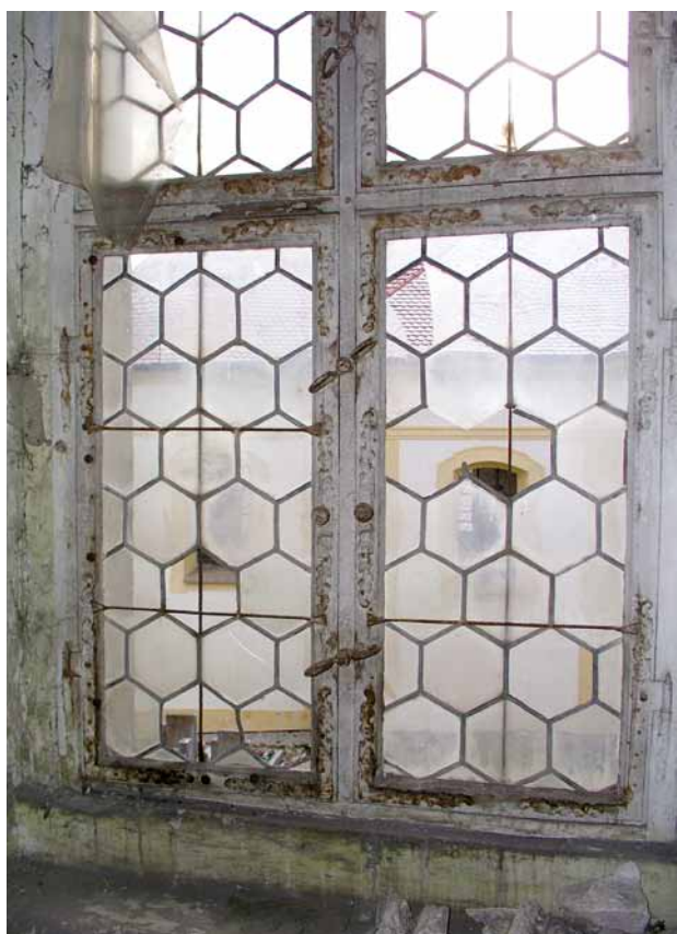
Obr. 10. Žebnice, fara. Jižní fasáda. Původní barokní okno na chodbě v patře, vložené do pevného kříže, se čtyřmi samostatnými křídly s původní výplní z šestibokých terčů fasetovaných do olova. Výplně jsou zpevněny zavětrovacími železnými tyčkami, dvěma vnitřními vodorovnými a jednou vnější svislou. Kování je provedeno výrazně složitěji než na okně na schodišti, jiné jsou průtuhy, shodují se jen motýlky. (Foto P. Vlček, 2008)
