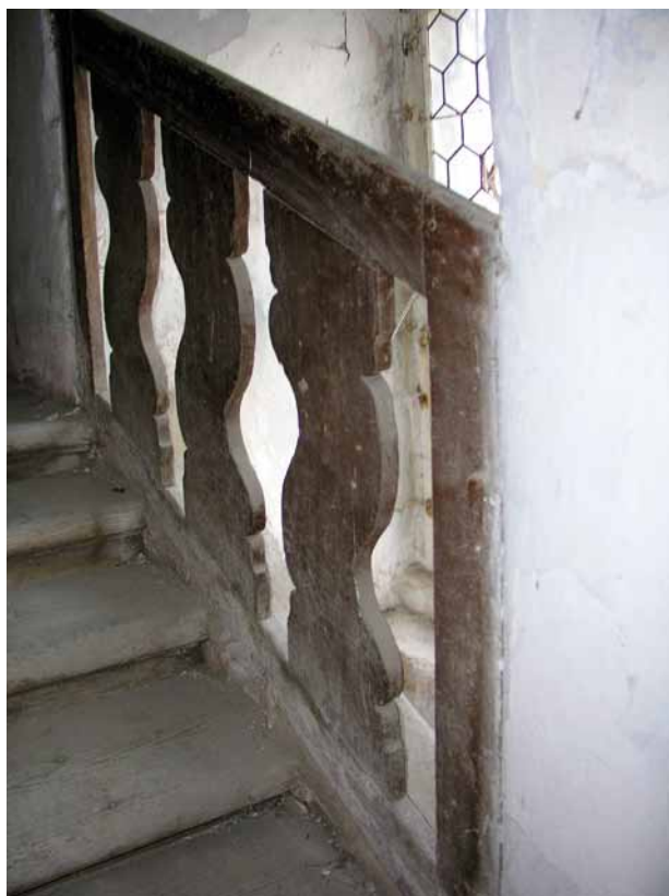
Obr. 13. Žebnice, fara. Barokní dřevěné zábradlí na schodišti do patra. (Foto P. Vlček, 2008)
