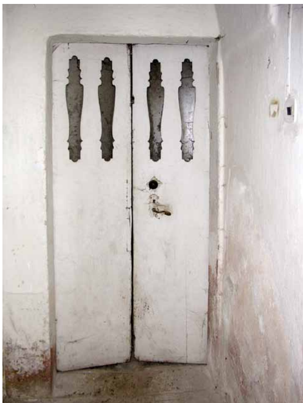
Obr. 12. Žebnice, fara. Původní barokní dvoukřídlé dveře, které uzavírají vchod v přízemí na schodiště do patra. Zachovalo se kompletní kování, včetně závěsů, zámku, klikového štítku kliky a také přítuhy. (Foto P. Vlček, 2008)
