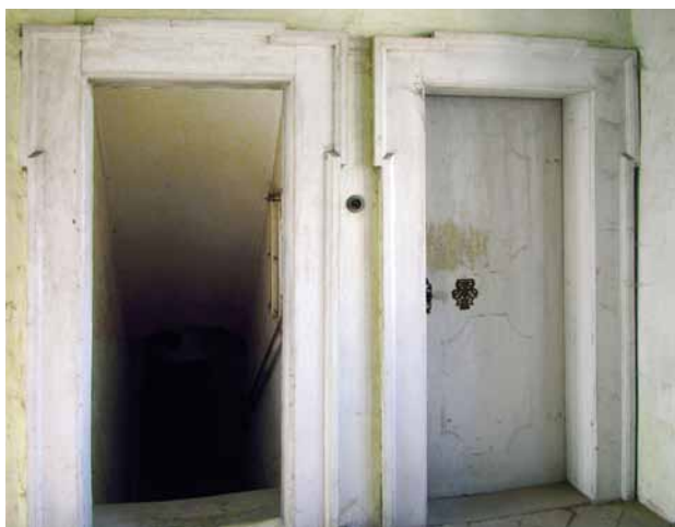
Obr. 16. Žebnice, fara. Dvojice dveří na chodbě v patře – při vyústění schodiště z přízemí (vlevo) a nástupu na schodiště na půdu (upravo). Původní vrcholně barokní kování bylo zcizeno (odkazují na ně obrysy pod novodobým nátěrem, pod nímž je skryt i obrazec na dveřním křídle). Ve výplních lze předpokládat existenci malovaných symbolů plaského opatství (nejspíše hvězdu, ale i růži či lilii). (Foto P. Vlček, 2008)
