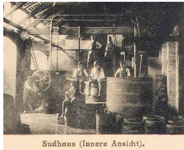
Obr. 17. Ošelín, zámecký pivovar. Vnitřek varny. Vpředu sedí pivovarníci na okraji rmutovací kádě, v pozadí na ochozu pánve s režnou cihlovou obezdívkou stojí patrně sládek spolu s majitelem(?) v rakousko-uherské uniformě, vlevo obsluha ručně poháněné pumpy. Objekt zanikl. (Pohlednice z počátku 20. století; reprofoto Z. Procházka, 2012)
