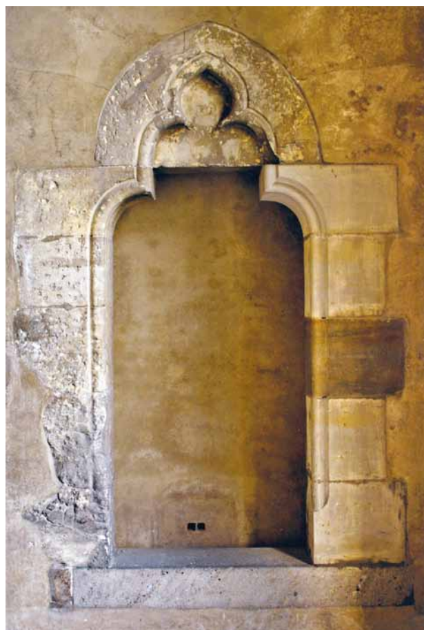
Obr. 6. Praha, Pražský hrad. Starý královský palác, arkádový trakt. Sedlový portál s tympanonem a slepým kružbovým trojlístem ve vrcholu – někdejší vstup do sálu v západním křídle, kde je dnes takzvaná Sloupová síň Václava IV. Přibližně 30.–40. léta 14. století. (Foto J. Gloc, b. r.)
