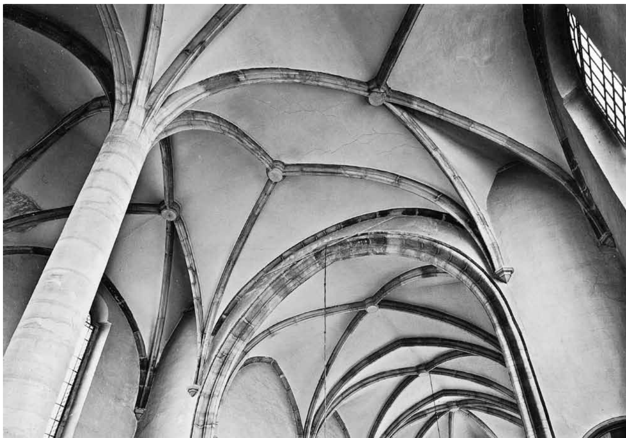
Obr. 13. Větlá (okr. Litoměřice), kostel sv. Jakuba. Pohled v lodi na obkročnou klenbu v místě proti triumfální oblouku. (Fotoarchiv Národního památkového ústavu, generální ředitelství, foto S. Divišová, 1958)
