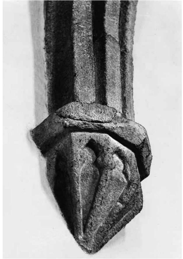
Obr. 15. Loučim, kostel Narození Panny Marie. Typická klenební jehlancová konzola zdobená slepými kružbami, v tomto případě na rozhraní výběhů křížové a paprscité klenby na severní stěně presbyteria. (Fotoarchiv Národního památkového ústavu, ú. o. p. v Plzni, foto J. Gryc, 1967)
