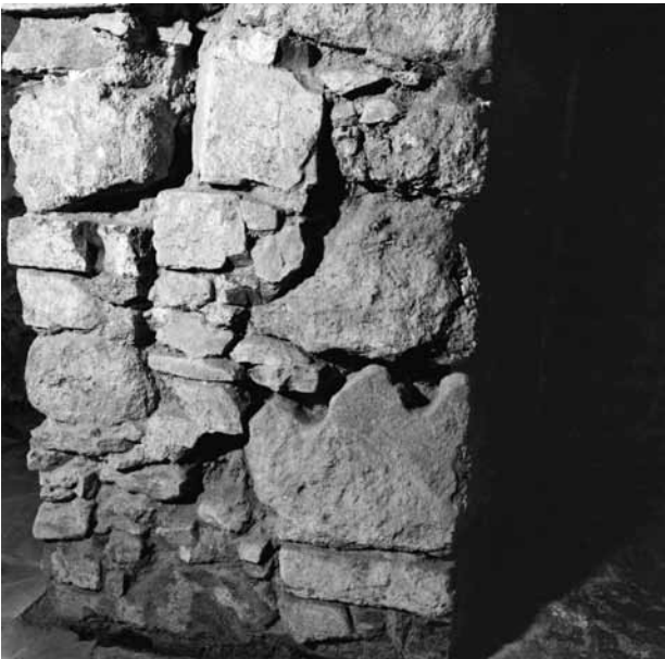
Obr. 16. Loučim, kostel Narození Panny Marie. Špaleta průchodu v přízemí z lodi do věže s nálezem druhotně použitého kamenného profilovaného kusu ostění gotického, nejspíš západního vstupního portálu. (Fotoarchiv Národního památkového ústavu, ú. o. p. v Plzni, foto R. Kodera, 1997)
