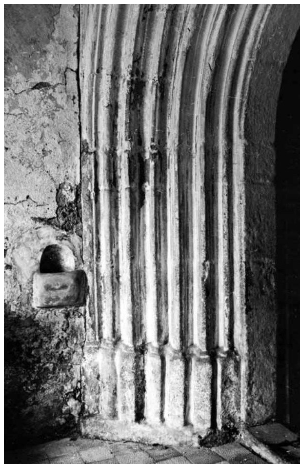
Obr. 8. Mělnice, kostel sv. Jiljí. Hlavní portál – detail profilace ostění a paty portálu. (Fotoarchiv Národního památkového ústavu, ú. o. p. v Plzni, foto R. Kodera, 1997)
