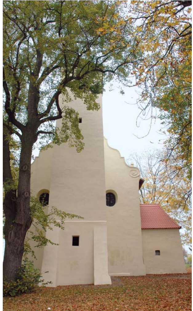
Obr. 6. Bukovec, kostel Nanebevzetí Panny Marie. Pohled od západu. Stav po obnově. (Foto L. Sommer, 2005)
