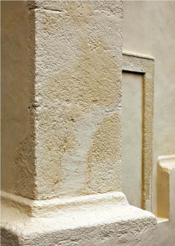
Obr. 5. Bukovec, kostel Nanebevzetí Panny Marie. Detail nové barevnosti fasád presbyteria – omítaných ploch a prvků architektury z tesaného kamene. (Foto L. Sommer, 2005)
