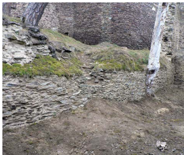
Obr. 15. Okrouhlé Hradiště, zřícenina hradu Gutštejna. Severní zeď jižního paláce po opravě. Ve spodní úrovni zdi je vidět doplnění líce, v horní úrovni (vlevo) zpevnění jádra zdiva bez lícové plochy. Koruna zdiva překryta drnovým pokryvem. Uprostřed upravený přechod přes torzo zdi na horní nádvoří (ponecháním původní průrvy při jejím zmenšení a přizdění ochranných vrstev); modelací terénu naznačen směr přístupu. Ve zdivu ponechána i spodní část kmenu uschlé borovice. (Foto L. Havlovic, 2011)
