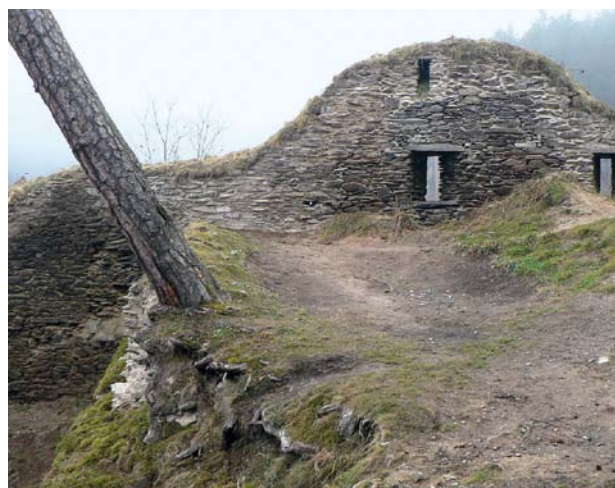
Obr. 10. Okrouhlé Hradiště, zřícenina hradu Gutštejna. Západní zeď horního nádvoří, pohled od východu. Stav po opravě (dozdění, spárování, dřevový pokryv koruny). Vpředu je vidět přechod přes torzo severní zdi jižního paláce na horní nádvoří. (Foto L. Havlovic, 2011)
