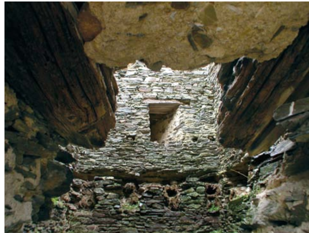
Obr. 26. Okrouhlé Hradiště, zřícenina hradu Gutštejna. Věž, pohled z dodatečně proraženého vstupního otvoru na západní straně. Zbytky trámového roštu z 20. let 15. století a okénko s dřevěným překladem z 80. let 15. století. (Foto P. Sokol, 2010)
