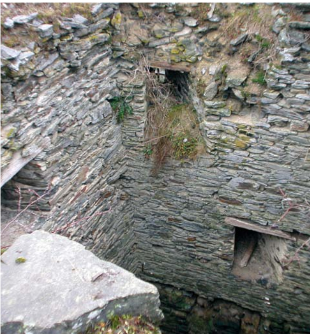
Obr. 13. Okrouhlé Hradiště, zřícenina hradu Gutštejna. Věž, pohled na severní a východní stěnu. Stav vnitřní strany koruny zdiva před opravou. Střílny v horních patrech s dřevěnými překladky. V úrovni parapetu spodního okénka probíhá lešeňový nosník; pod tímto okénkem jsou ve zdivu patrné zbytky části trámového roštu. (Foto P. Sokol, 2010)
