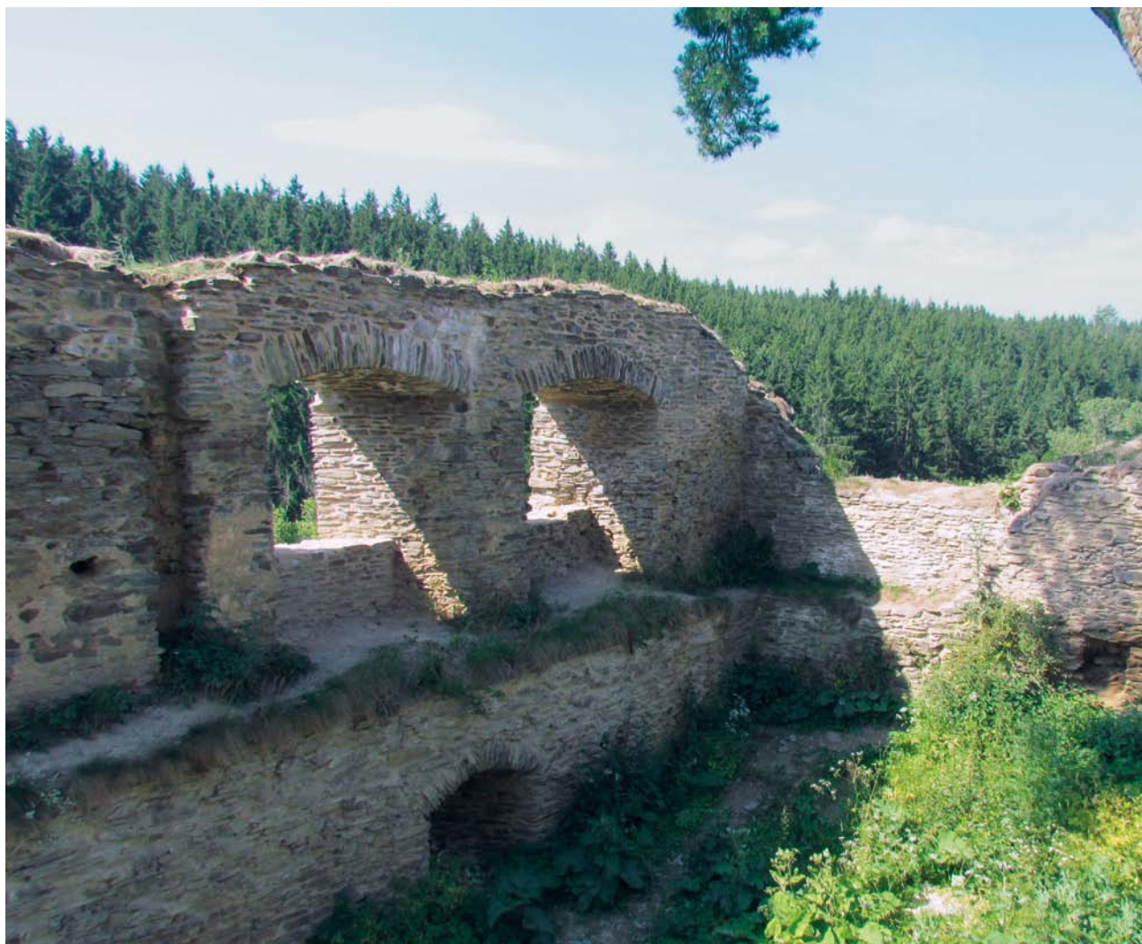
Obr. 4. Okrouhlé Hradiště, zřícenina hradu Gutštejna. Západní část jižního paláce, pohled od severovýchodu. Stav po opravě z roku 2009, včetně spárování v dolní části zdí a překrytí koruny zdiva drnovým povlakem, které byly provedeny dodatečně v roce 2011. (Foto P. Sokol, 2012)
