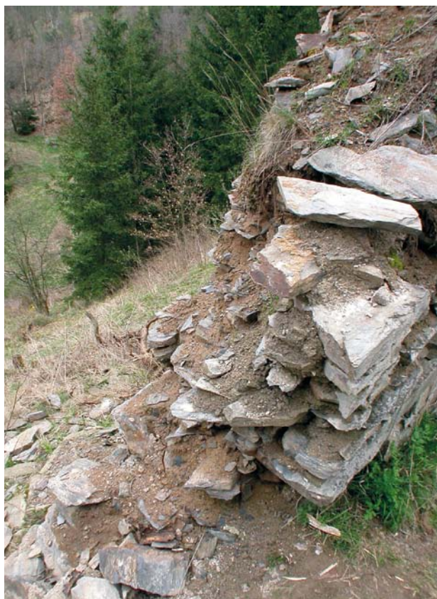
Obr. 24. Okrouhlé Hradiště, zřícenina hradu Gutštejna. Severní hradba východní části hradního jádra, pohled od jihozápadu. Detail zdiva v proluce před opravou. (Foto P. Sokol, 2006)
