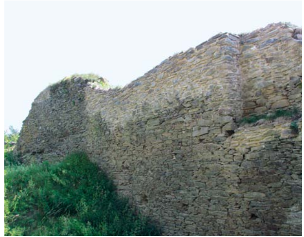
Obr. 21. Okrouhlé Hradiště, zřícenina hradu Gutštejna. Jižní hradba východní části hradu, pohled od západu. Stav po opravě. Rozsah přezdění a spárování je patrný světlým zbarvením zdi. (Foto P. Sokol, 2012)
