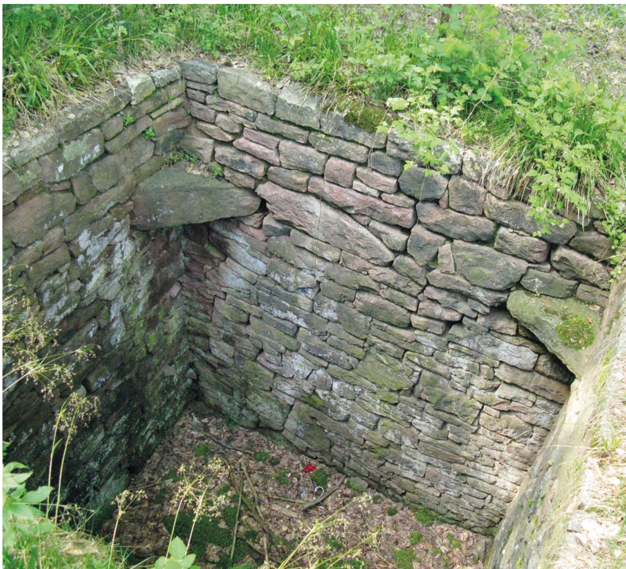
Obr. 9. Hohenwart (Německo, Bavorsko), zděná vlčí jáma. (Foto C. Ableiter, 2009, dostupné z www: <http://en.wikipedia.org/wiki/File:Wolfgrube.JPG> )
