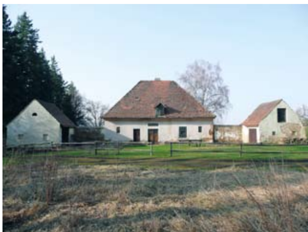
Obr. 7. Miřenice (okr. Klatovy), hájovna. Současný stav objektu. (Foto V. Zelinková, 2011)
