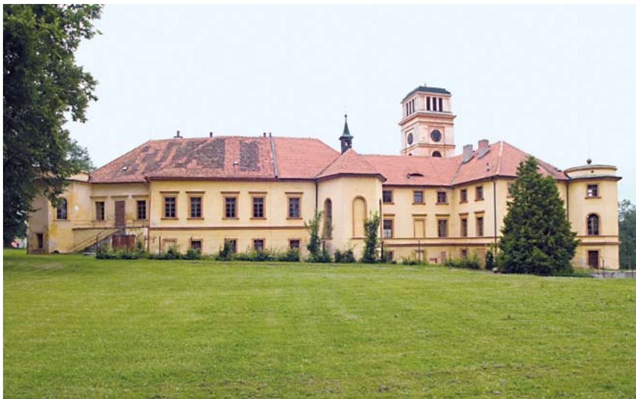
Obr. 14. Nalžovské Hory, zámek. Boční průčelí s kaplí. (Foto R. Kodera, 2011)
