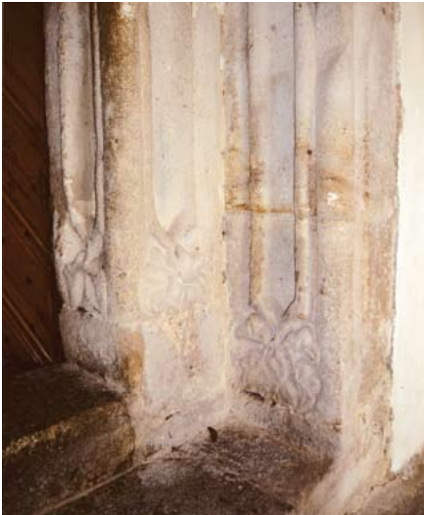
Obr. 7. Srbsice, kostel sv. Víta. Kamenická práce na ostění při patě jižního ustupního portálu. (Foto J. Kaigl, 2008)
