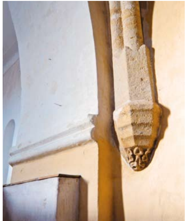
Obr. 8. Srbsice, kostel sv. Víta. Severní pata s římsou triumfálního oblouku a klenební konzola v severozápadním koutu chóru. (Foto J. Kaigl, 2008)
