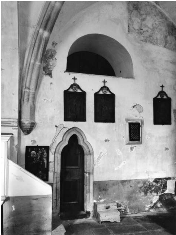
Obr. 9. Srbsice, kostel sv. Víta. Pohled na část severní stěny chóru s portálem do sakristie a klenutým otvorem na průhled z oratoře do prostoru chóru. (Fotoarchiv Národního památkového ústavu – ústředního pracoviště, foto Č. Šíla, 1975)
