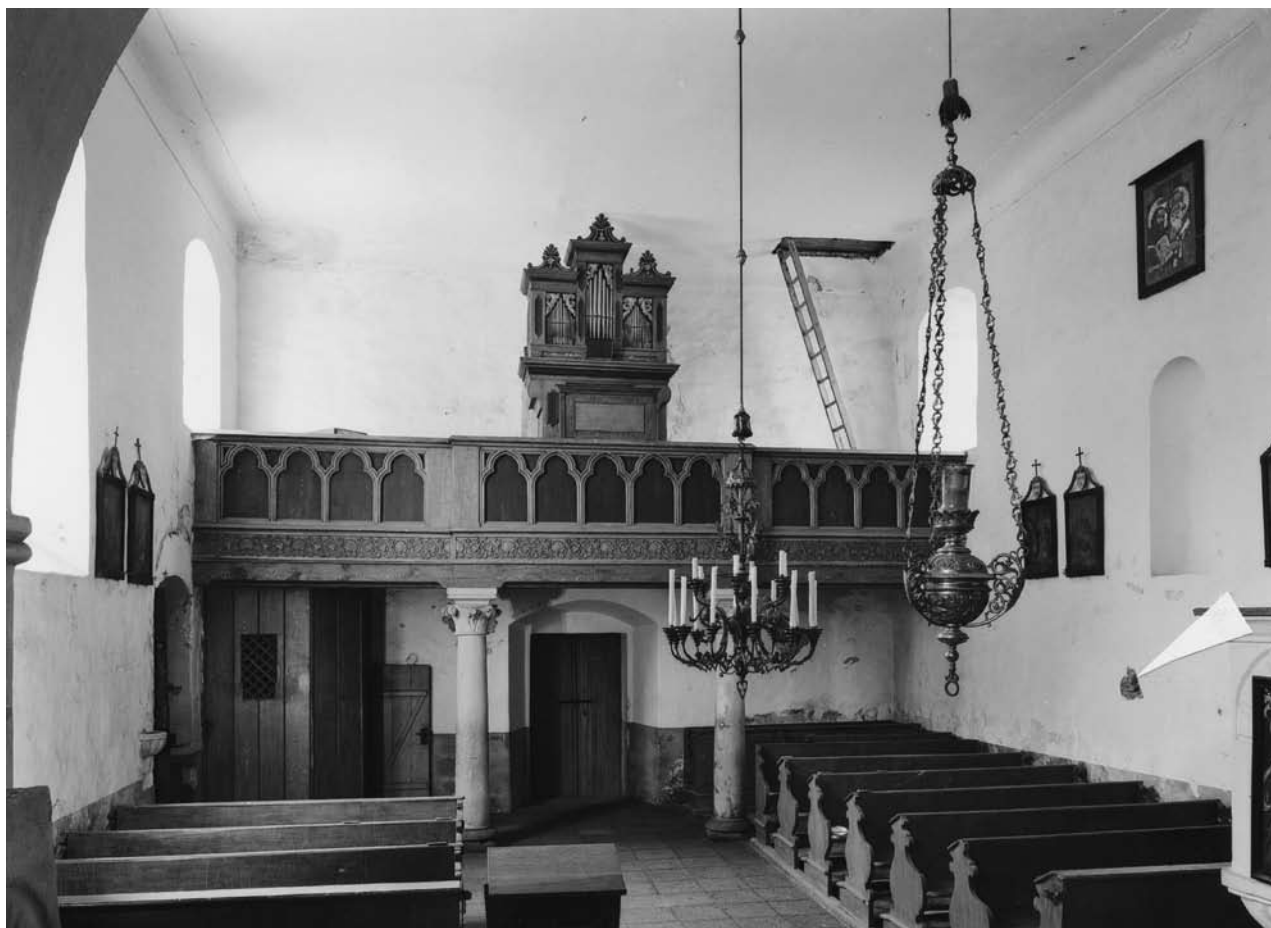
Obr. 4. Srbsice, kostel sv. Víta. Pohled do lodi. Šipkou vpravo je označeno místo s nálezem překladu gotického portálku na schodiště v tloušťce zesíleného úseku severní obvodové zdi lodi. (Fotoarchiv Národního památkového ústavu – ústředního pracoviště, foto Č. Šíla, 1975)
