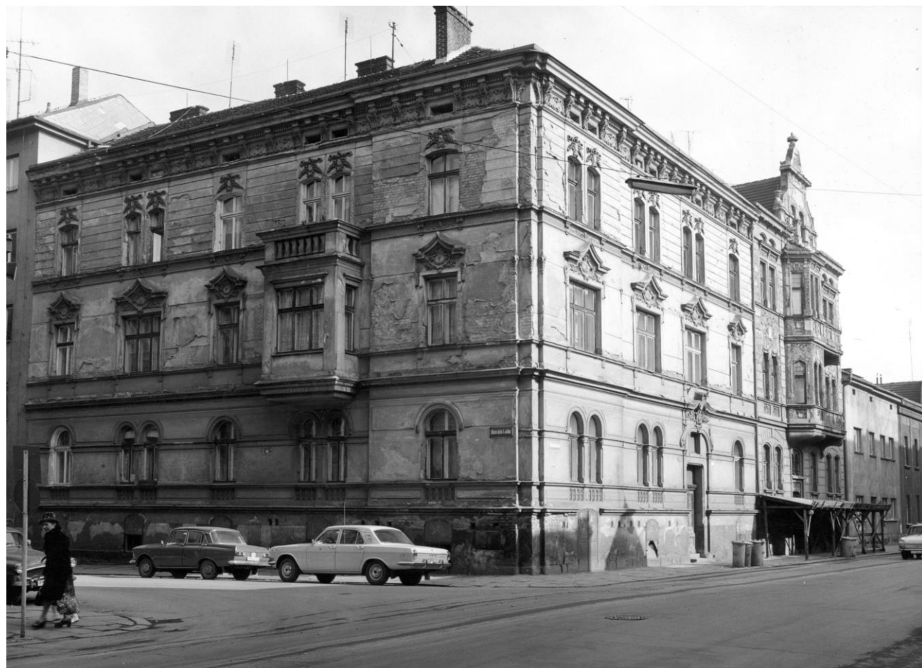
Bendova 10, dům s bytem rodiny Krausových, pohled na dům od jihozápadu. Jako u většiny Loosových plzeňských realizací i zde vznikl nový byt v interiéru staršího domu. Součástí úprav bylo i zvětšení některých oken a vytvoření nového arkýře, přičemž byl respektován historizující vzhled domu. (foto J. Gryc, 1980)
