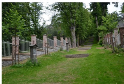
obnova křížové cesty včetně schodiště (r. 2020)
