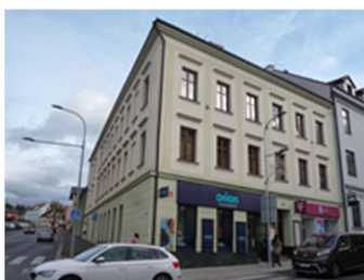
Pražská ul. č. p. 187
