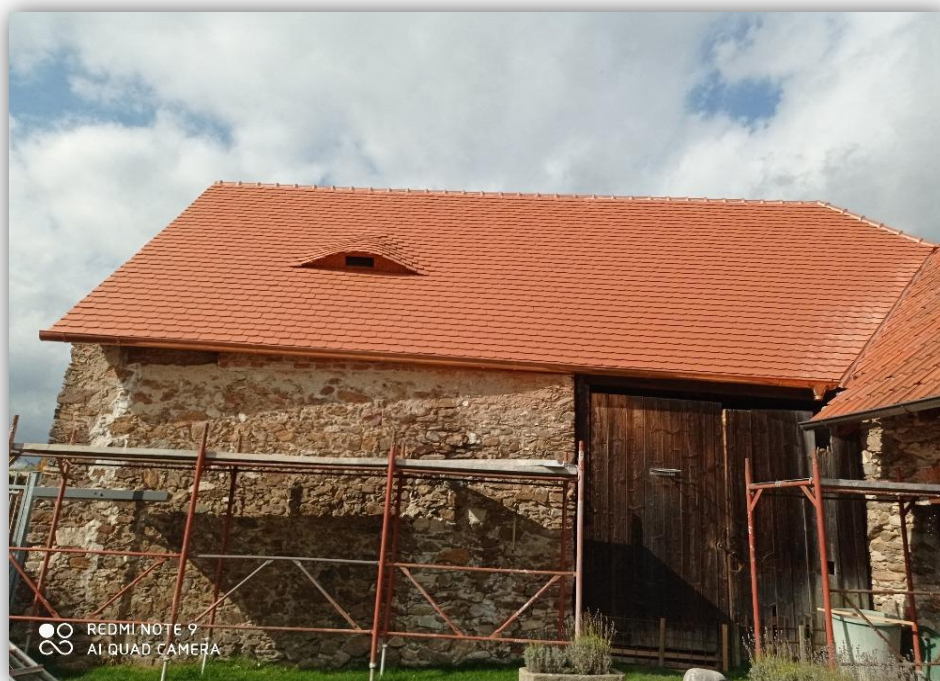
Stodola, p. č. st. 76, u č. p. 57, Podbranská ulice, Horažďovice, rejtr. č. 27215/4-2939 ÚSKP – Obnova střešní krytiny, obloukového vikýře a osazení klempířských prvků – 3. etapa
