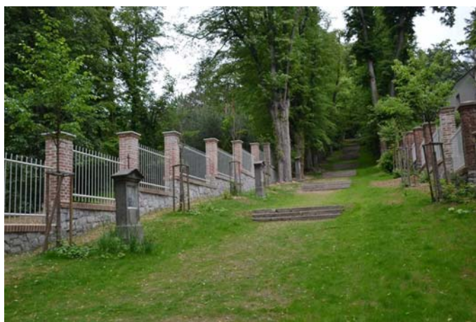
obnova křížové cesty včetně schodiště (r. 2020)
