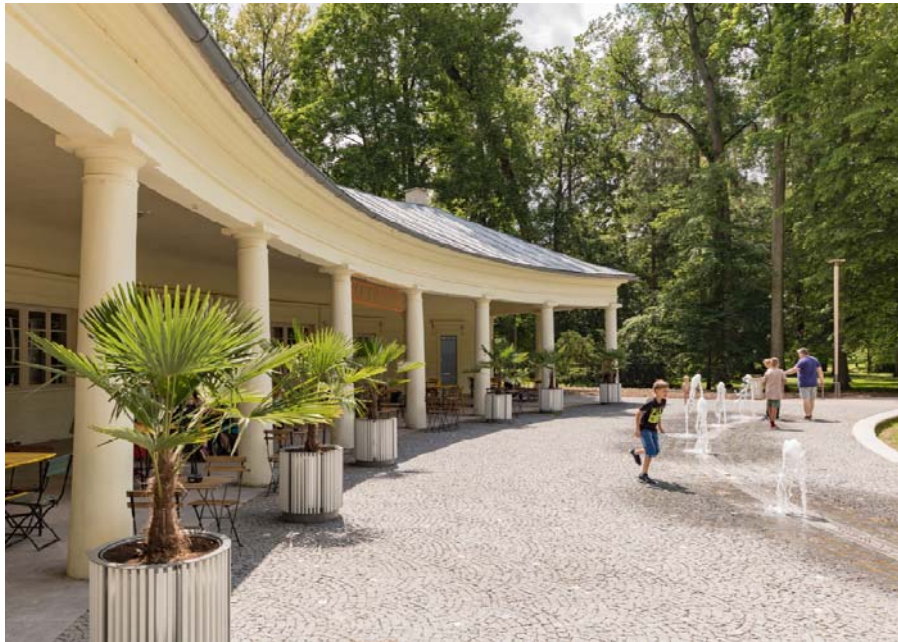
Realizace veřejného WC
