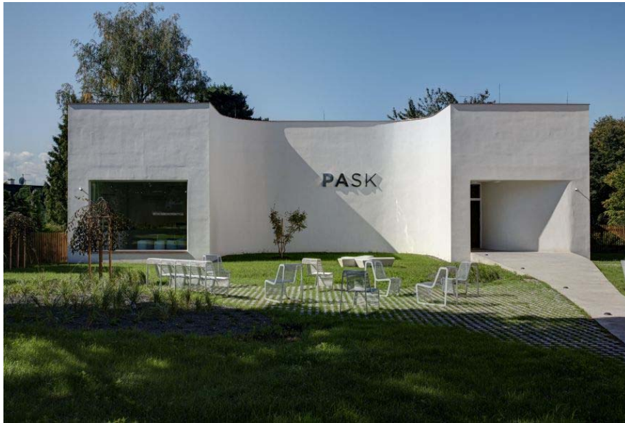
Rekonstrukce Pavilonu skla včetně zahrady (r. 2014)
