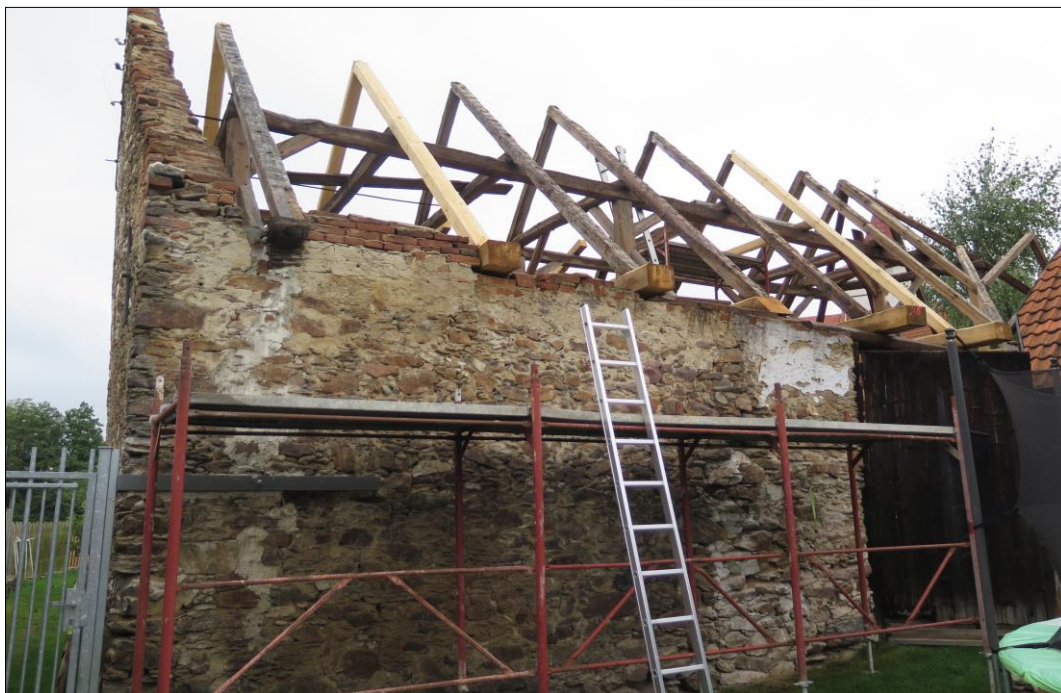
Stodola, p. č. st. 76, u č. p. 57, Podbranská ulice, Horažďovice, rej. č. 27215/4-2939 ÚSKP – Obnova krovu stodoly, oprava volného zdiva a stažení štítového rohu táhly – 1. etapa
