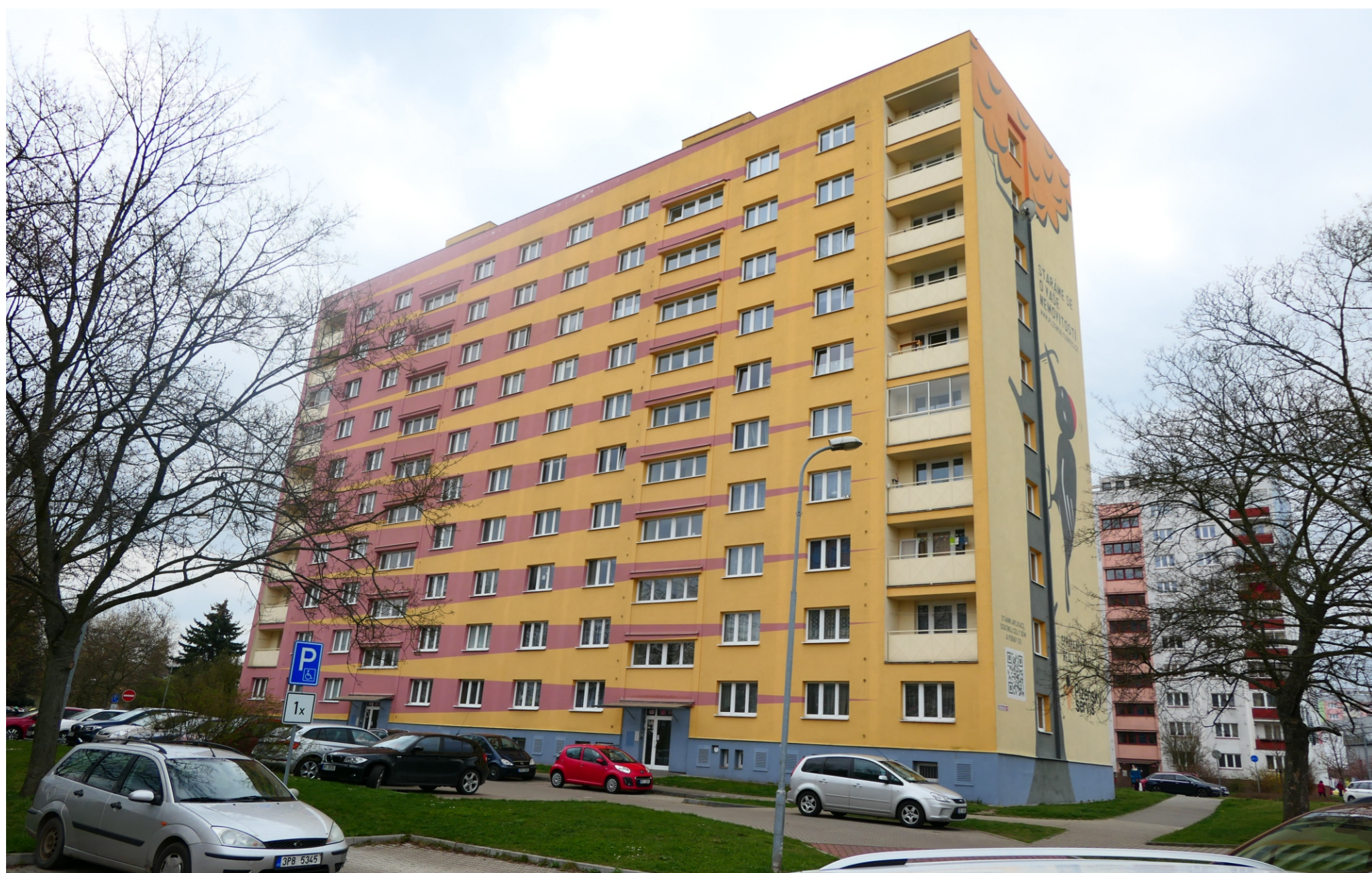
Slovany IV, Částkova čp. 2096/47 a 2292/49, pohled od severozápadu. (Foto Lenka Lišková, 2021)
