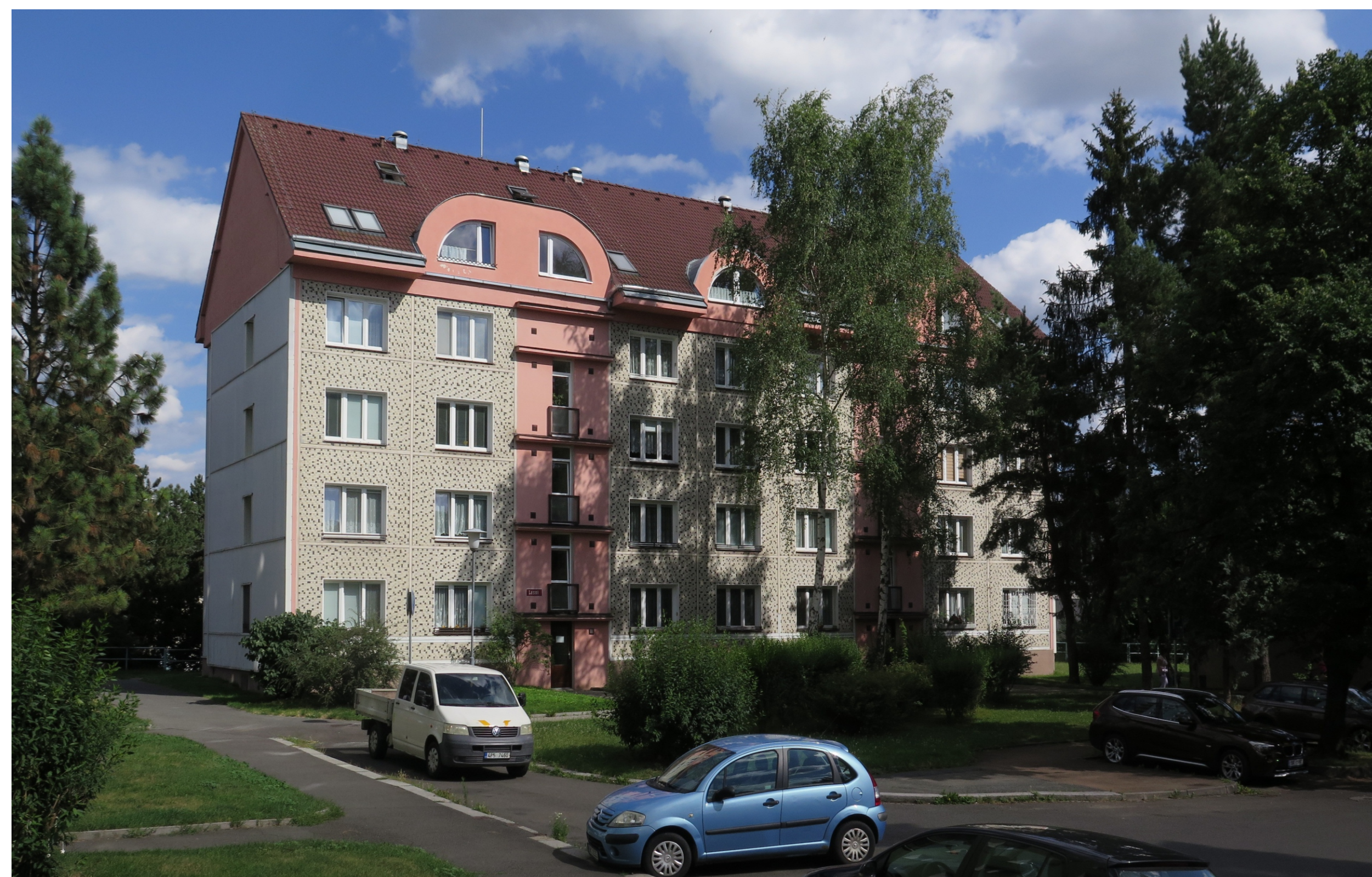
Doubravka, obytný soubor F, Lesní čp. 1291/1 a 1292/3, přístavba sedlové střechy na panelový dům, pohled od severozápadu, příklad snahy o popření původního vzhledu a hmoty. (Foto David Tuma, 2022)
