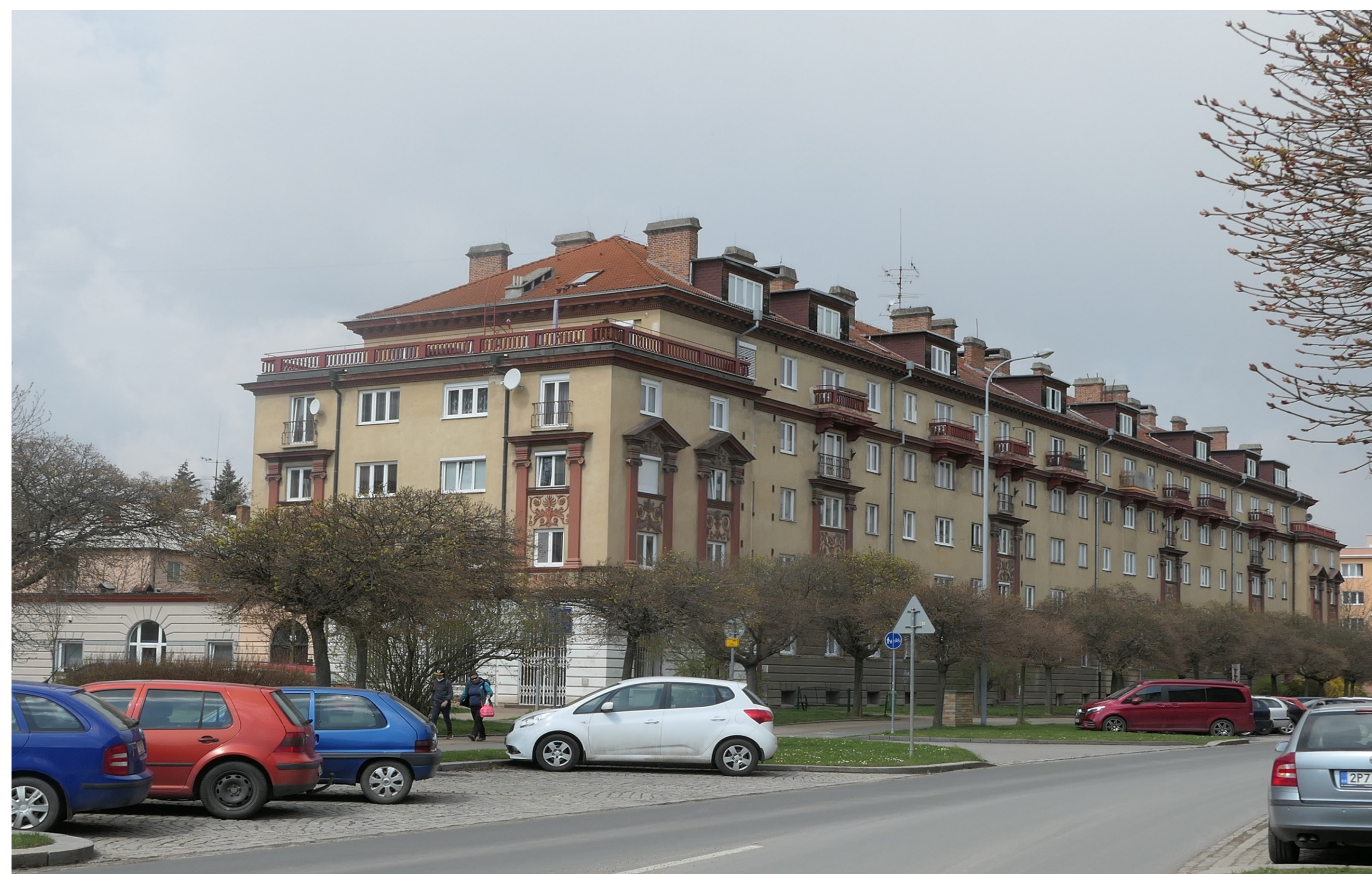
Slovany I, Francouzská třída čp. 1862/16 – 1865/22, pohled od jihovýchodu, příklad autenticky dochované fasády. (Foto Lenka Lišková, 2021)
