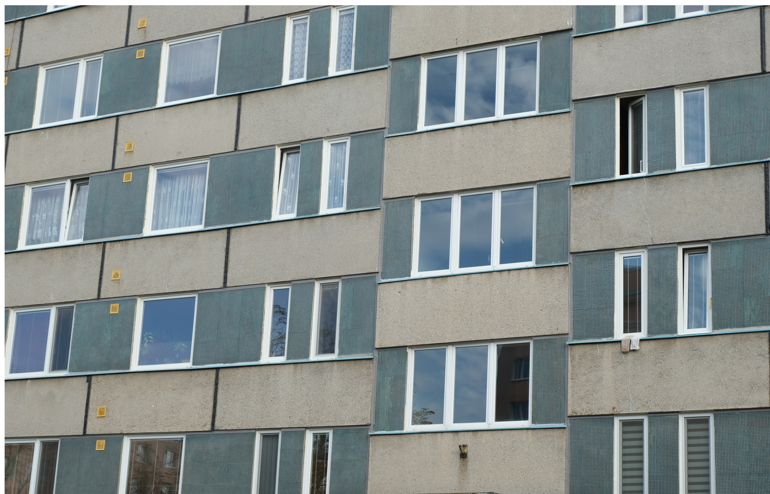
Jižní Předměstí, Bory, Heyrovského čp. 482/42, 483/44 a 482/1, detail provedení fasád, pohled od západu, příklad autenticky dochovaného atypického řešení meziokenních vložek. (Foto David Tuma, 2022)
