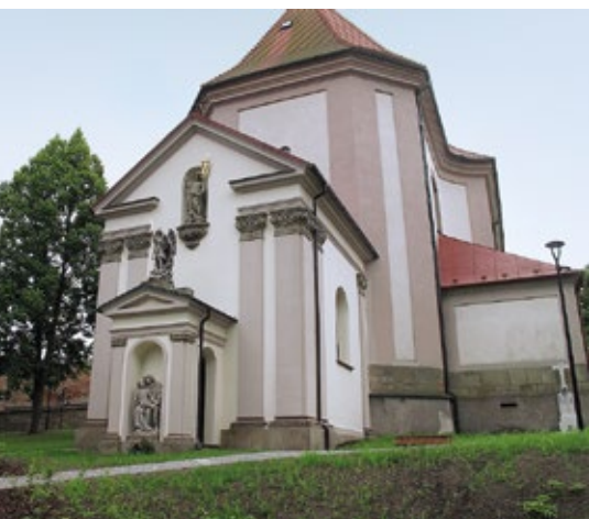
Ústí nad Orlicí, Útěchová kaple po restaurování, 2018, foto V. Paukr.
