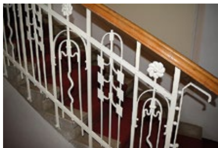
Obr. 15 – Pavlovická ulice čp. 93 – detail litinového zábradlí se secesním dekorem na hlavním schodišti, foto – J. Krpálková.
