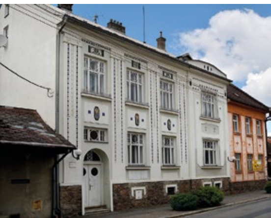
Obr. 14 – Pavlovická ulice čp. 93 – pohled na průčelí domu z ulice, foto – J. Krpálková.
