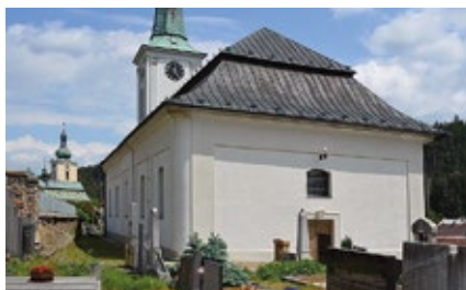
Obr. 24 – Evangelický kostel – pohled na kostel z jihozápadní strany, foto – J. Krpálková.
