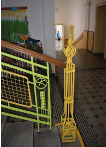
Obr. 19 – Ulice Padělek čp. 133 – detail zábradlí u hlavního schodiště, foto – J. Krpálková.
