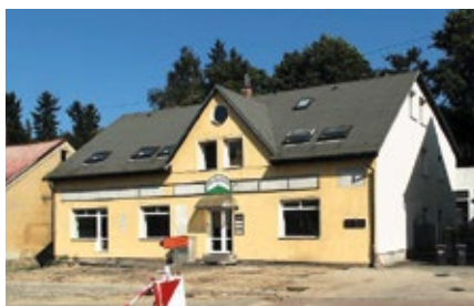
Rodný dům Ferdinanda Porscheho před rekonstrukcí. Zdroj: https://stavbaweb.dumabyt.cz/35/architectobjectfile/04/60/66/2.jpg [cit. 1.10.2018]
