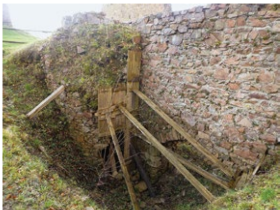
Zdivo paláce před obnovou, foto Z. Stránská.
