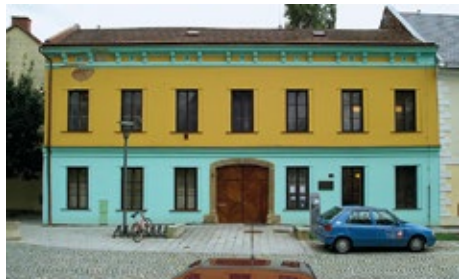
Lanškroun, dům č. p. 142, stav před obnovou, foto Z. Stránská.
