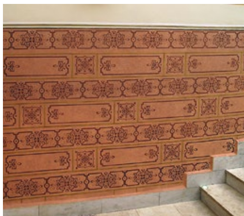
Brandýs nad Orlicí, radnice, malby po restaurování, 2017, foto V. Paukr.
