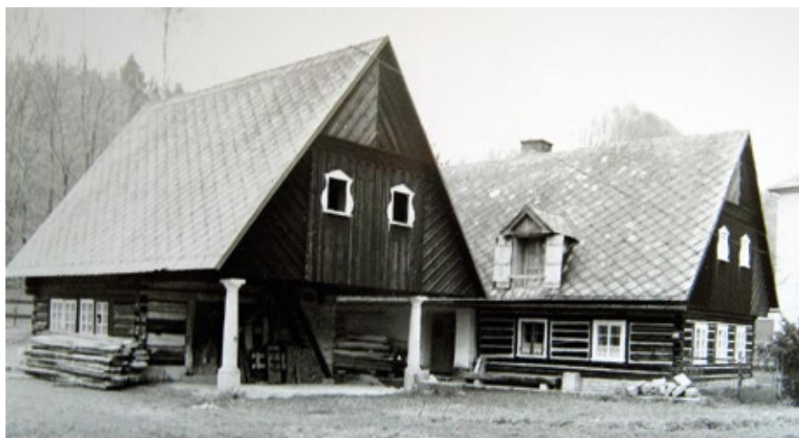
Obr. č. 7: Nízká Srbská roubená kovárna č. p. 47 z roku 1799. Za stavením uvnitř svahu má původní kamenný sklípek na zásoby, foto A. Skalický st., 1996.
