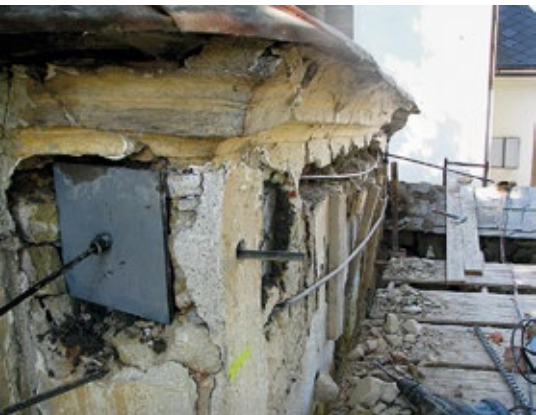
Statické zajištění zdiva, foto Z. Stránská.
