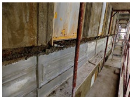
Fasáda v průběhu prací, foto Z. Stránská.
