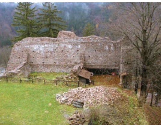
Zdivo paláce před obnovou, foto Z. Stránská.
