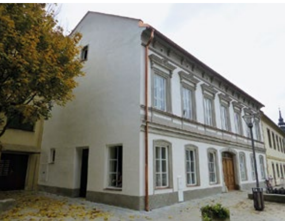
Stav po obnově, foto Z. Stránská.
