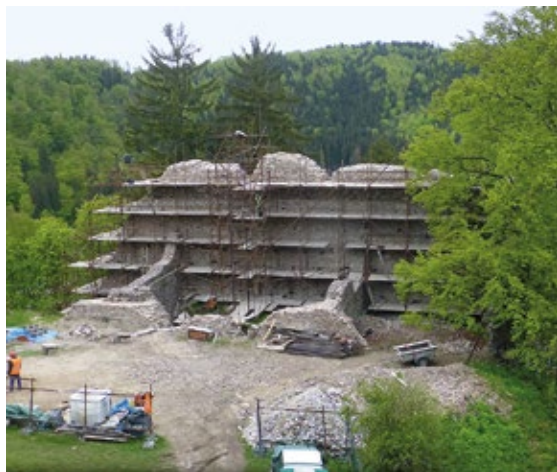
Průběh prací, foto Z. Stránská..
