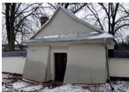
Stav po obnově, foto Z. Stránská.
