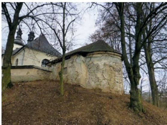
Stav po statickém zajištění, foto Z. Stránská.
