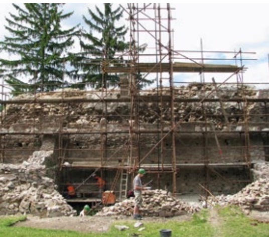
Průběh prací, foto Z. Stránská.
