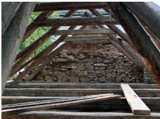
Pohled do krovu v průběhu prací, foto Z. Stránská.
