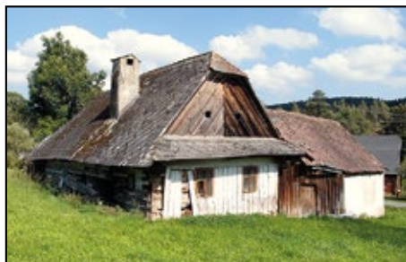
Venkovská usedlost čp. 24 v Telecích před obnovou, foto: J. Švec
