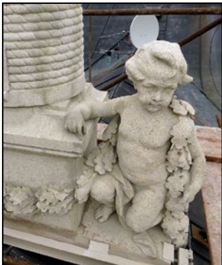
Budova čp. 364 během obnovy – detail, foto: Z. Vařeková
