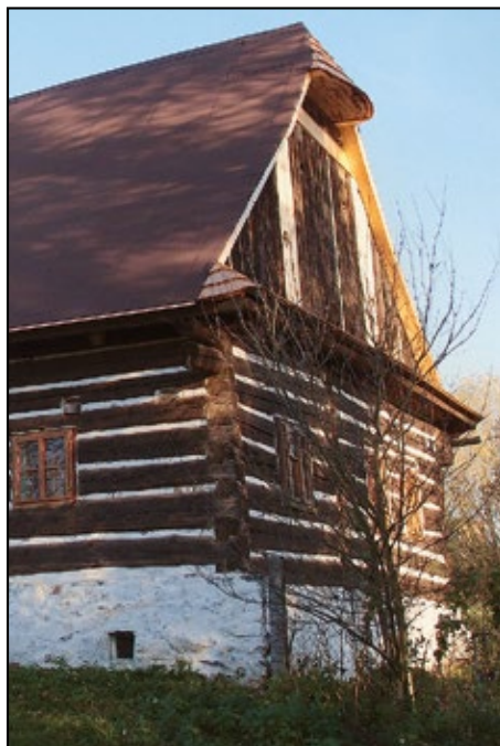
Korouhev čp. 163, detail obnoveného štítu s kabřincem, foto: J. Švec
