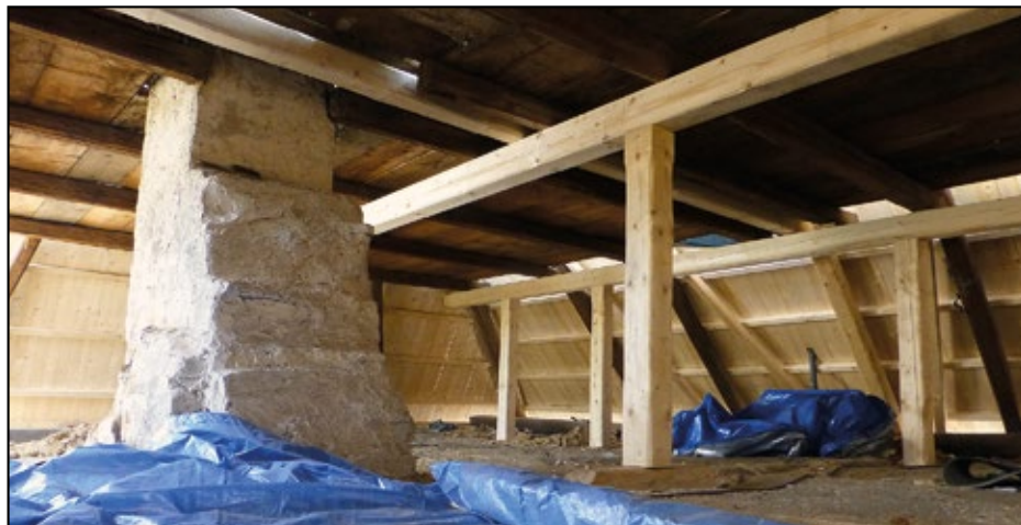
Dům čp. 281, obnova střechy, foto: Z. Vařeková
