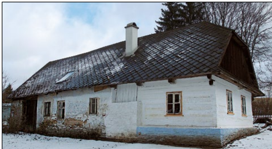
Možděnice čp. 37, stav po obnově světnice, foto: J. Švec
