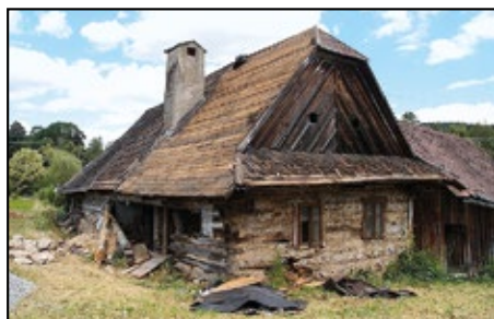
Telecí čp. 24, stav po sejmutí krytiny a obložení, foto: J. Švec
