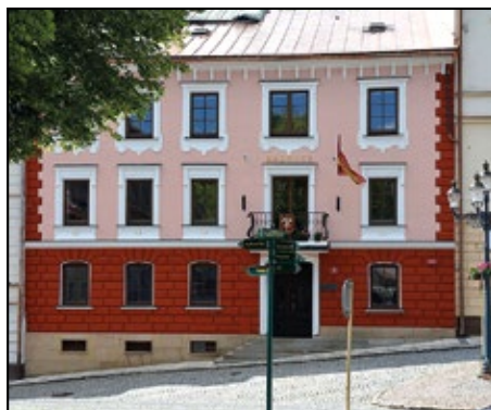
Budova radnice čp. 5 po obnově, foto: MÚ Králíky
