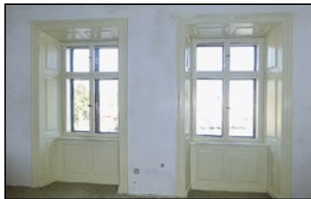
Městský dům čp. 63 – okna po obnově, foto: Z. Vařeková
