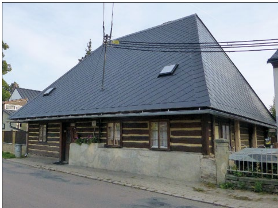
Dům čp. 281, obnova střechy, foto: Z. Vařeková
