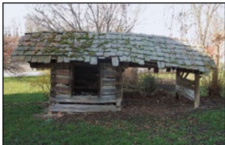
Sušárna u čp. 12 v Zálší, stav před obnovou, foto: J. Švec
