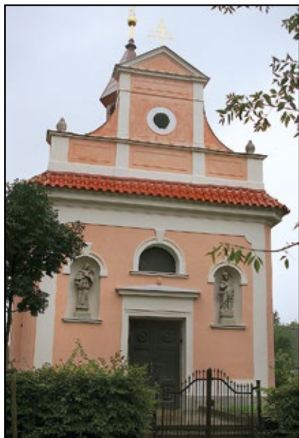
Hrušová, kostel Nejsvětější Trojice, pohled na vstupní průčelí po obnově, foto: V. Cinková
