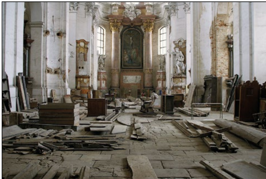
Kostel Nalezení sv. Kříže v Litomyšli během obnovy, foto: V. Cinková
