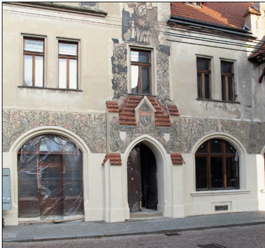
Restaurování sgrafit na fasádě u domu na Střelnici čp. 1, foto: V. Paukr
