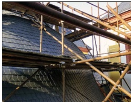
Kostel sv. Mikuláše, střecha během obnovy, foto: Z. Vařeková
