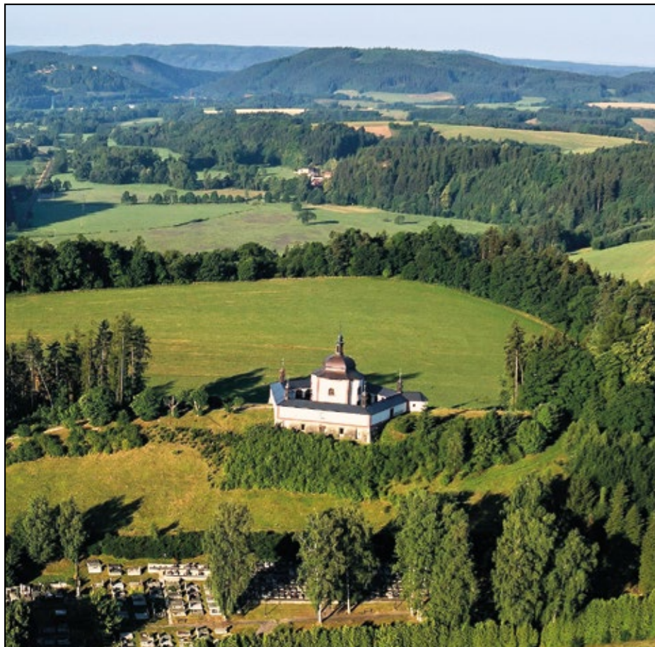
Kaple sv. Jana Nepomuckého – nové střechy, foto: Městský úřad Letohrad
