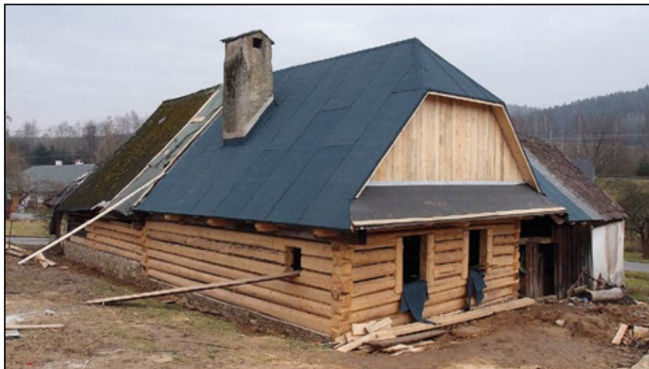
Telecí čp. 24, hrubá stavba celkově rekonstruované obytné části, foto: J. Švec
