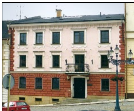
Budova radnice čp. 5 před obnovou, foto: Z. Vařeková
