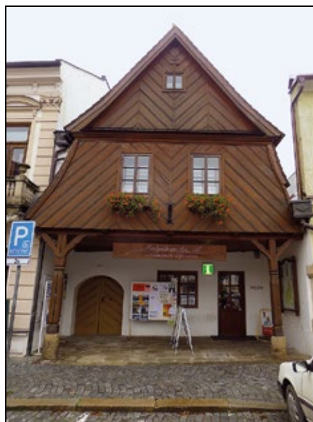
Dům čp. 30 – průčelí, foto: Z. Vařeková
