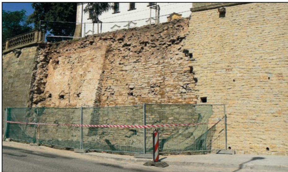
Obnova ohradních a opěrných zdí, foto: Z. Vařeková
