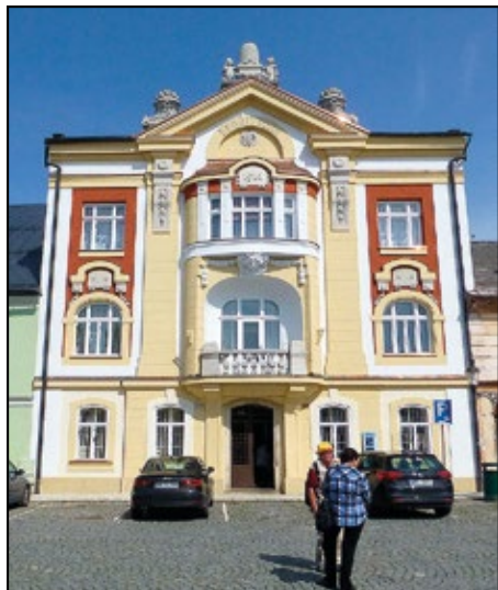
Budova čp. 364 po obnově, foto: Z. Vařeková
