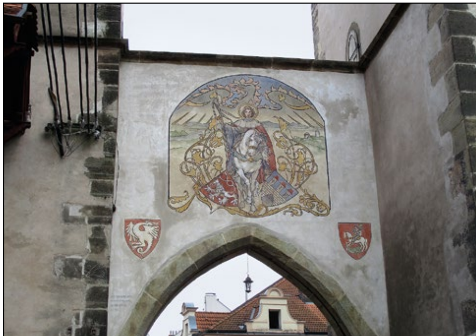
Pražská brána během restaurování, foto: V. Paukrt
