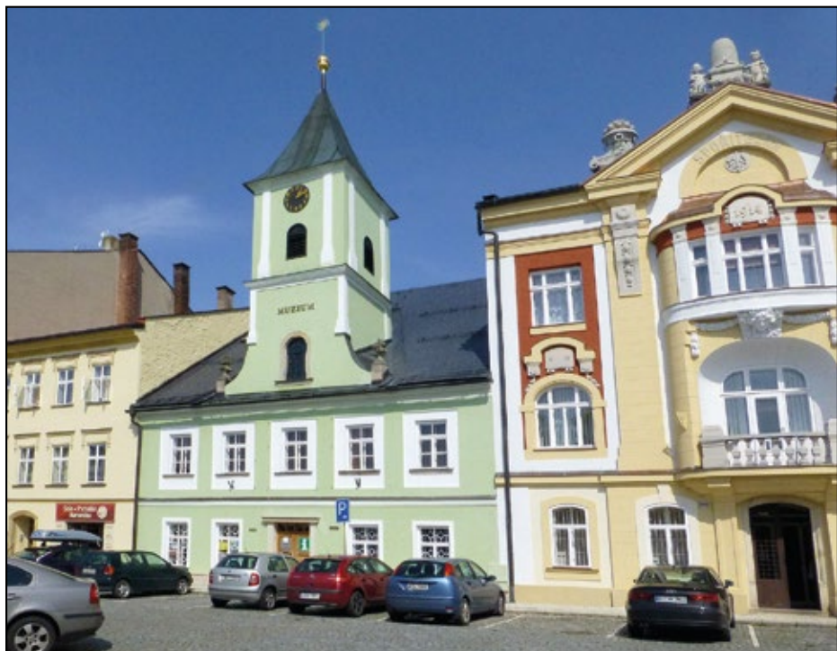
Budova čp. 365 po obnově, foto: Z. Vařeková
