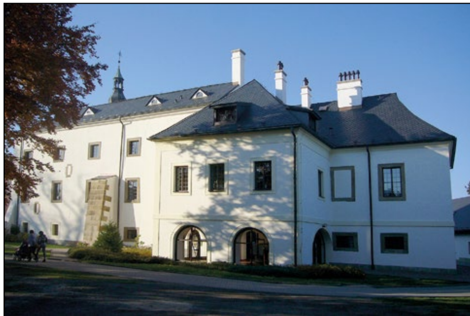
Zámek – obnova střechy, foto: Z. Vařeková
