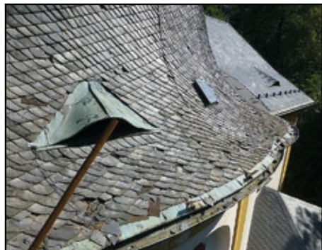
Kostel sv. Mikuláše, střecha před obnovou, foto: Z. Vařeková
