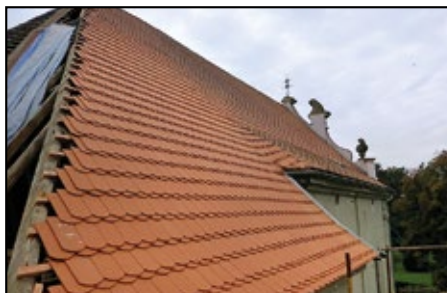
Výměna střešní krytiny, foto: Z. Vařeková
