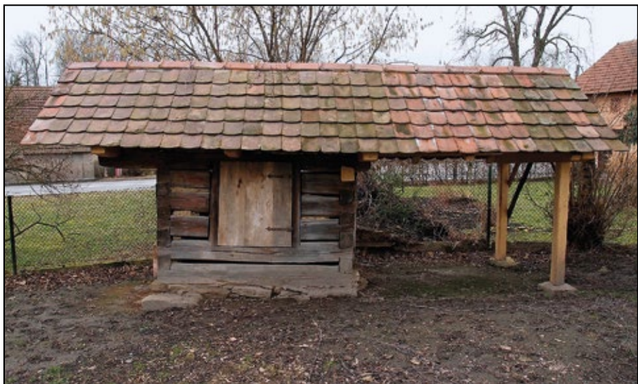
Sušárna u čp. 12 v Zálší, stav po obnově, foto: J. Švec
