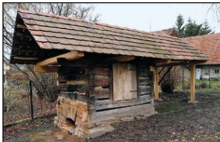
Sušárna čp. 12 v Zálší, stav po obnově objektu, foto: J. Švec
