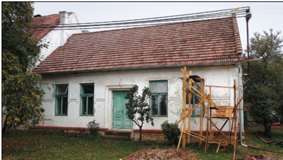
Vysoká čp.1, střecha po zpevnění krovu a přeložení krytiny, foto: J. Švec
