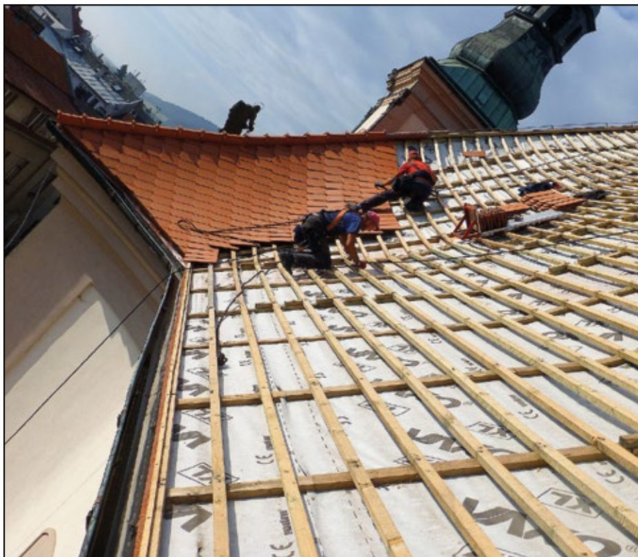
Kostel Nanebevzetí Panny Marie – obnova střechy, foto: Z. Vařeková
