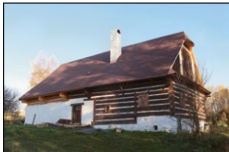
Korouhev čp. 163, stav po obnově krytiny, foto: J. Švec
