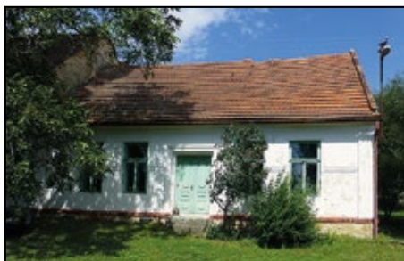
Vysoká čp.1, sál bývalého hostince před obnovou krovu a krytiny, foto: J. Švec
