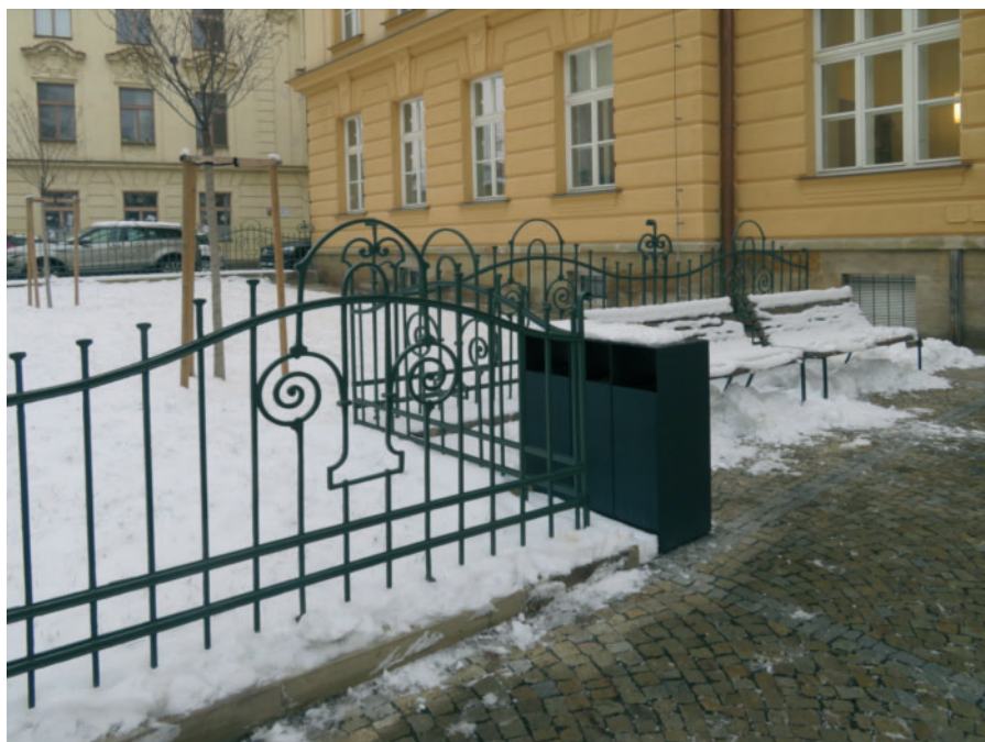
③ Olomouc, Na Hradě, č. o. 5, pohled na nově zřízené posezení u vstupní části, 2019. Foto Jan Kubeš.
