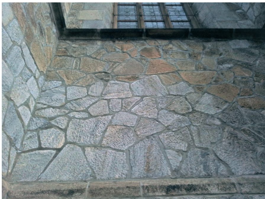
11 Travná, kostel Neposkvrněného Početí Panny Marie, detail kamenné stěny po opravě, 2019. Foto Eva Pulkrtová.
