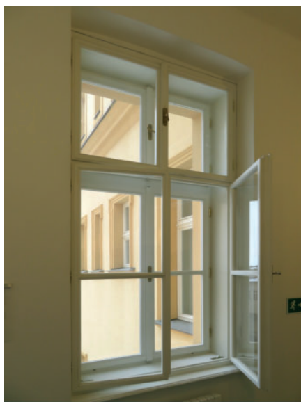
10 Olomouc, Na Hradě, č. o. 5, pohled na typické nově provedené fasádní okno, 2019. Foto Jan Kubeš.
