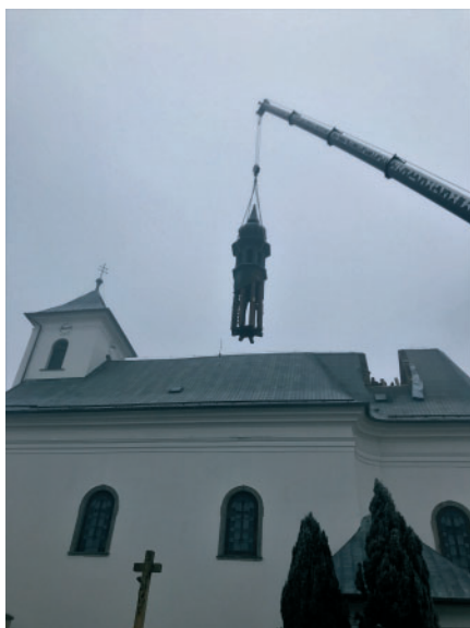
7 Horka nad Moravou, kostel sv. Mikuláše, celkový pohled na objekt, demontáž sanktusníkové věže, 2018. Foto Roofs. cz Group, a. s.
