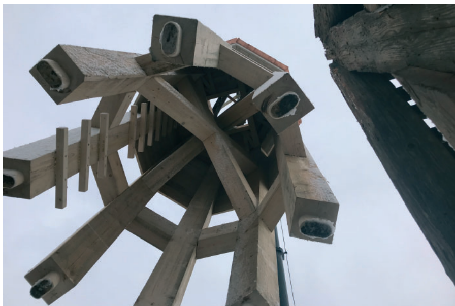
⑩ Horka nad Moravou, kostel sv. Mikuláše, osazování spodní části nové sanktusníkové věže, 2018. Foto Roofs. cz Group, a. s.
