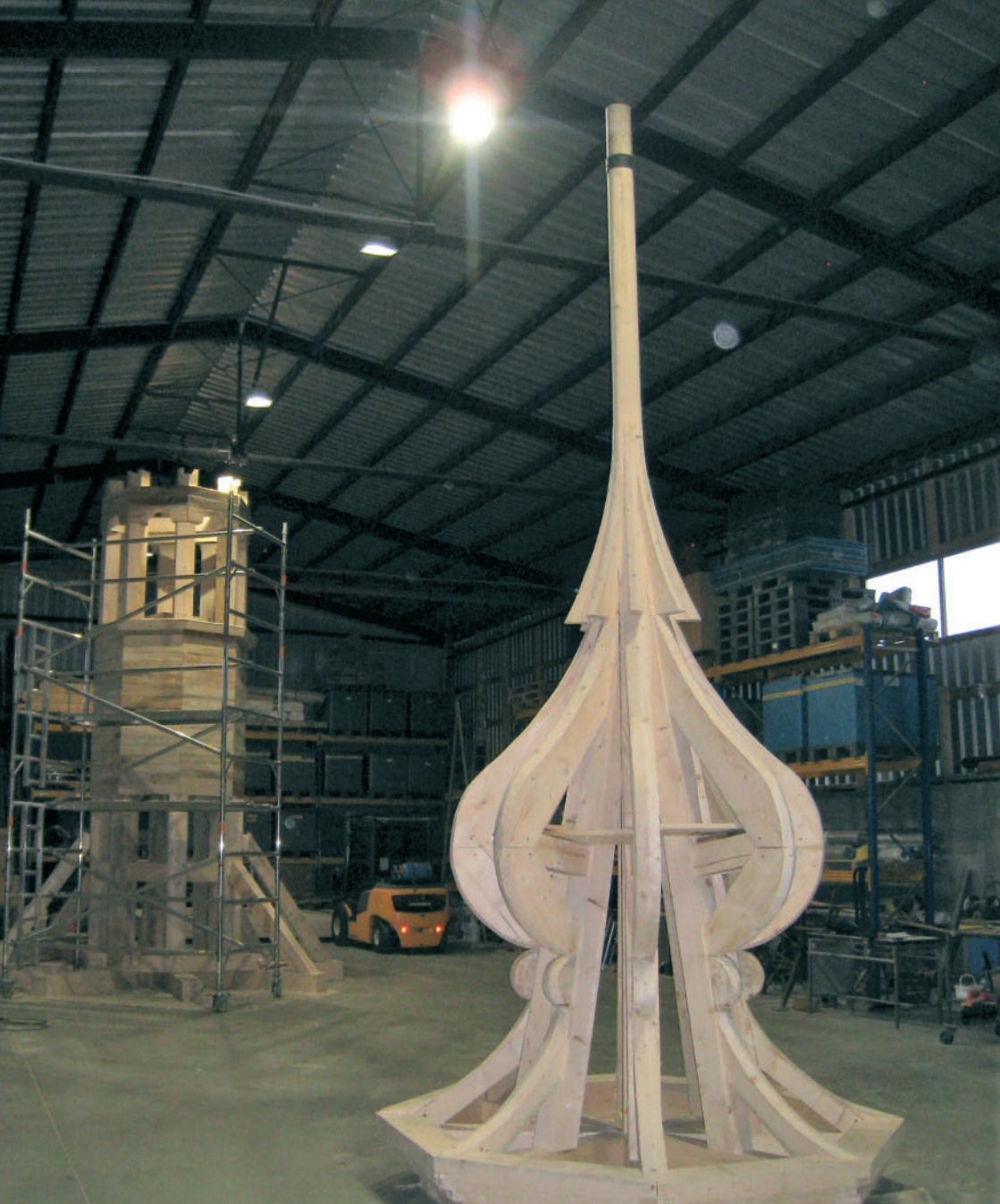
① Horka nad Moravou, kostel sv. Mikuláše, dřevěná konstrukce věže v průběhu prací v hale, 2018. Foto Dobroslava Neckářová.
