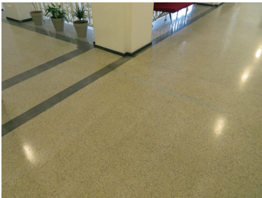
9 Olomouc, Na Hradě, č. o. 5, pohled na terasovou podlahu chodby po rekonstrukci, 2019. Foto Jan Kubeš.
