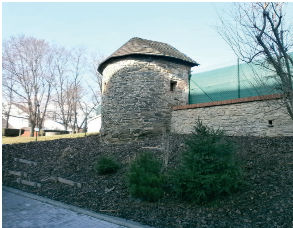
12 Mohelnice, městské hradby, úsek při Okružní ulici s baštou, pohled od jihu, stav po opravě, 2019. Foto Jitka Štáblová.
