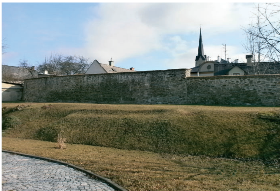
⑧ Mohelnice, městské hradby, úsek na Okružní ulici, pohled z jihu, stav po opravě, 2019. Foto Jitka Štáblová.
