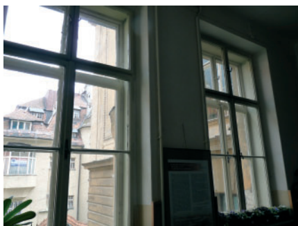
22 Olomouc, Na Hradě, č. o. 5, pohled na typické okenní výplně před rekonstrukcí, 2019. Foto Jan Kubeš.
