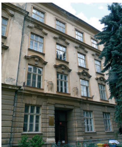
16 Olomouc, Na Hradě, č. o. 5, pohled na čelní fasádu před rekonstrukcí, 2019. Foto Jan Kubeš.
