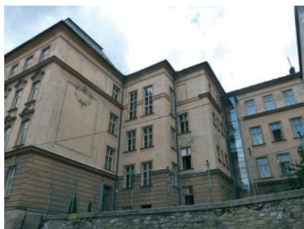
17 Olomouc, Na Hradě, č. o. 5, pohled na dvorní fasádu s výtahem před rekonstrukcí, 2019. Foto Jan Kubeš.
