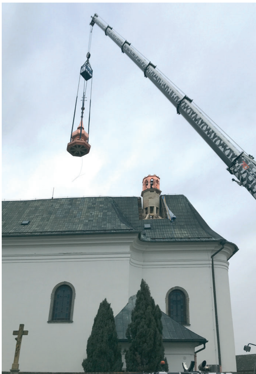
12 Horka nad Moravou, kostel sv. Mikuláše, celkový pohled na objekt, osazování nové sanktusníkové věže, 2018. Foto Roofs. cz Group, a. s.
