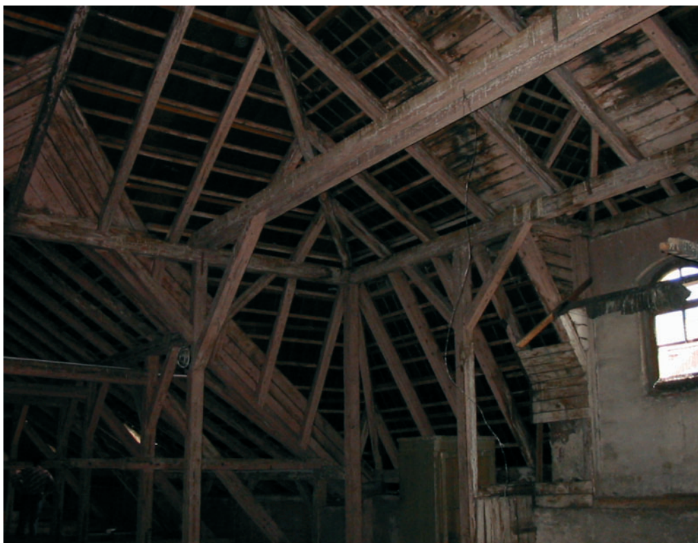
23 Olomouc, Na Hradě, č. o. 5, pohled do podkroví objektu s původním krovem před rekonstrukcí, 2019. Foto Jan Kubeš.
