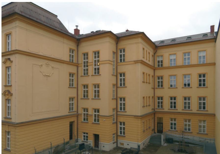
14 Olomouc, Na Hradě, č. o. 5, pohled na dvorní fasádu s odstraněným výtahem (pravý vnitřní roh) a doplněnou štukovou výzdobou po rekonstrukci, 2019. Foto Jan Kubeš.
