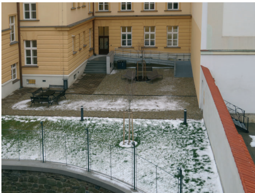
15 Olomouc, Na Hradě, č. o. 5, pohled na dvorní plochu po rekonstrukci (nová rampa pro imobilní osoby, nové kamenné dláždění, nová výsadba, nový mobiliář), 2019. Foto Jan Kubeš.
