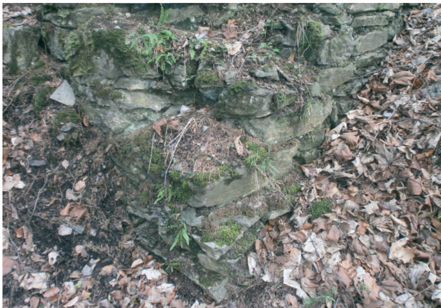
⑥ Hrad Pleče, obec Jindřichov, okr. Šumperk. Hradní jádro, zdivo východní části hradby, detail nároží, 2018. Foto Jitka Štáblová.
