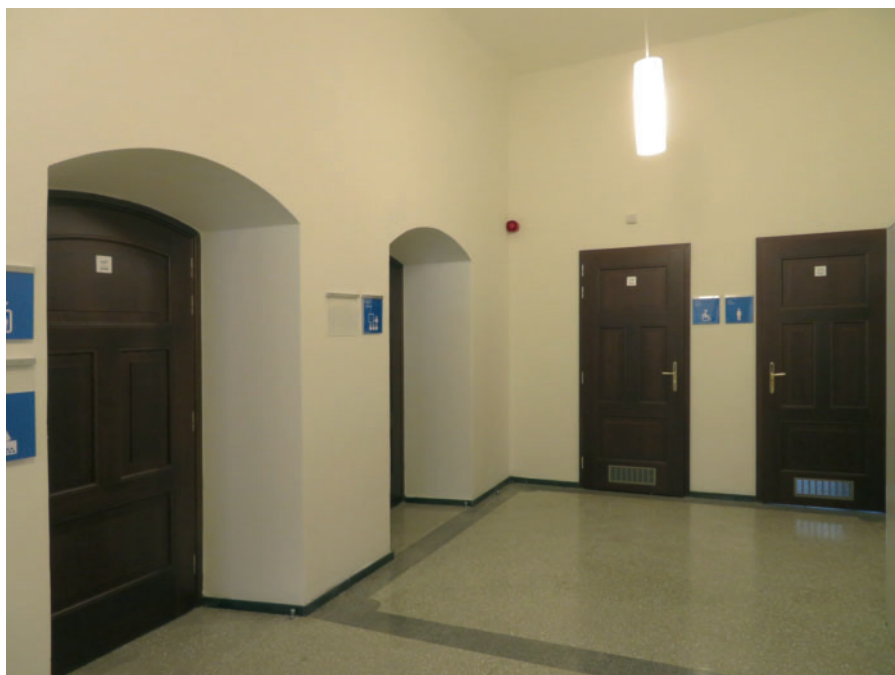
8 Olomouc, Na Hradě, č. o. 5, pohled na typický úsek chodby s novými dveřmi po rekonstrukci, 2019. Foto Jan Kuběš.
