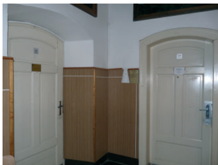
20 Olomouc, Na Hradě, č. o. 5, pohled na typický úsek chodby s dveřmi před rekonstrukcí, 2019. Foto Jan Kubeš.
