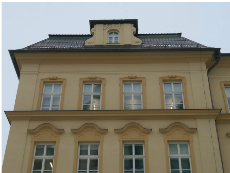
② Olomouc, Na Hradě, č. o. 5, pohled na levý rizalit čelní fasády po rekonstrukci, 2019. Foto Jan Kubeš.
