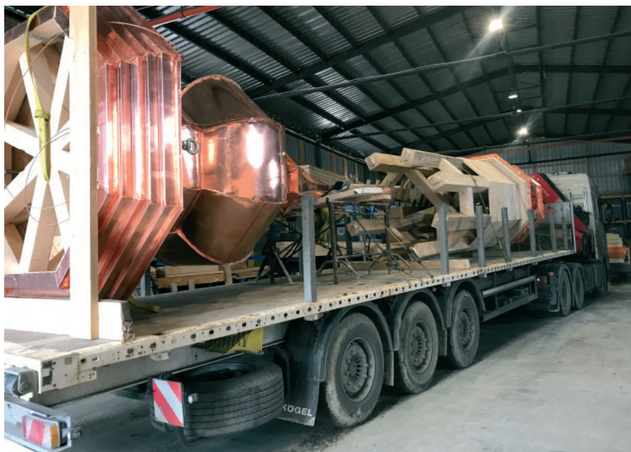
⑨ Horka nad Moravou, kostel sv. Mikuláše, oplechované části nové sanktusníkové věže připravené na převoz, 2018. Foto Roofs. cz Group, a. s.
