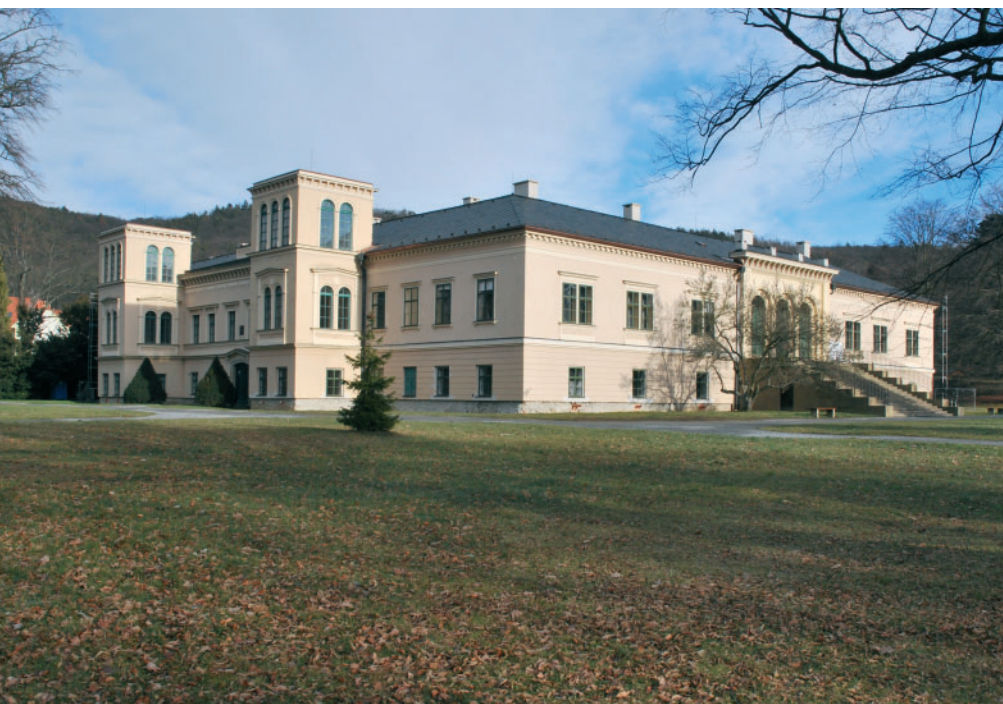
④ Čechy pod Kosířem, zámek. Pohled na zámek s obnovenou krytinou (od jihozápadu). Foto Ondřej Belšík.
