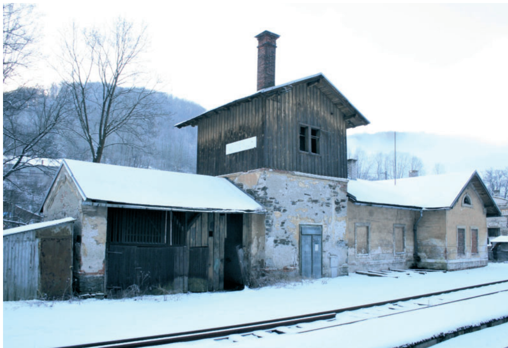
6 Hrubá Voda – vodárna. Foto Jan Kubeš.
