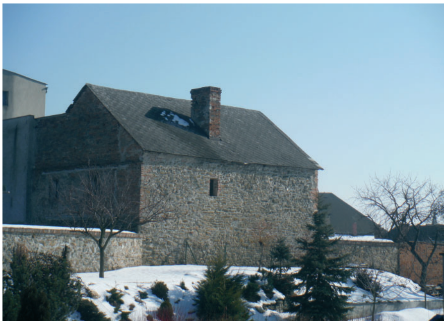
⑨ Mohelnice, městské hradby, Okružní ulice, tzv. Brusův dům, pohled z jihu, stav po opravě, 2016. Foto Jitka Štáblová.
