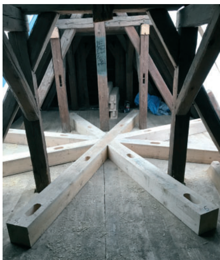
13 Horka nad Moravou, kostel sv. Mikuláše, interiér krovu, nová konstrukce pro osazení sanktusníkové věže, 2018. Foto Roofs. cz Group, a. s.
