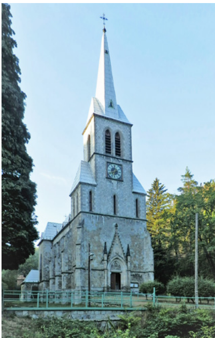
3 Travná, kostel Neposkvrněného Početí Panny Marie, čelní pohled, 2015. Foto Eva Pulkrťová.
