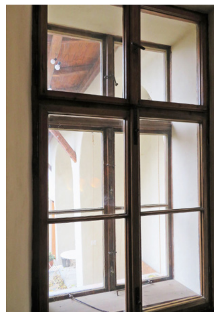
9 Olomouc, Denisova č. o. 33, repasovaná historická okna v přízemí do dvora po rekonstrukci, 2017. Foto Jan Kubeš.
