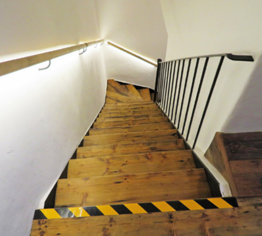
19 Olomouc, Denisova č. o. 33, schody do podkroví z třetího patra po rekonstrukci, 2017. Foto Jan Kubeš.
