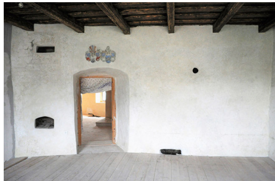
7 Podolí, renesanční tvrz Kobylků z Kobylího. Část tzv. veselého pokoje v patře s restaurovanou malbou, novým trémovým stropem a dřevěnou podlahou, 2017. Foto Dušan Rohlík.
