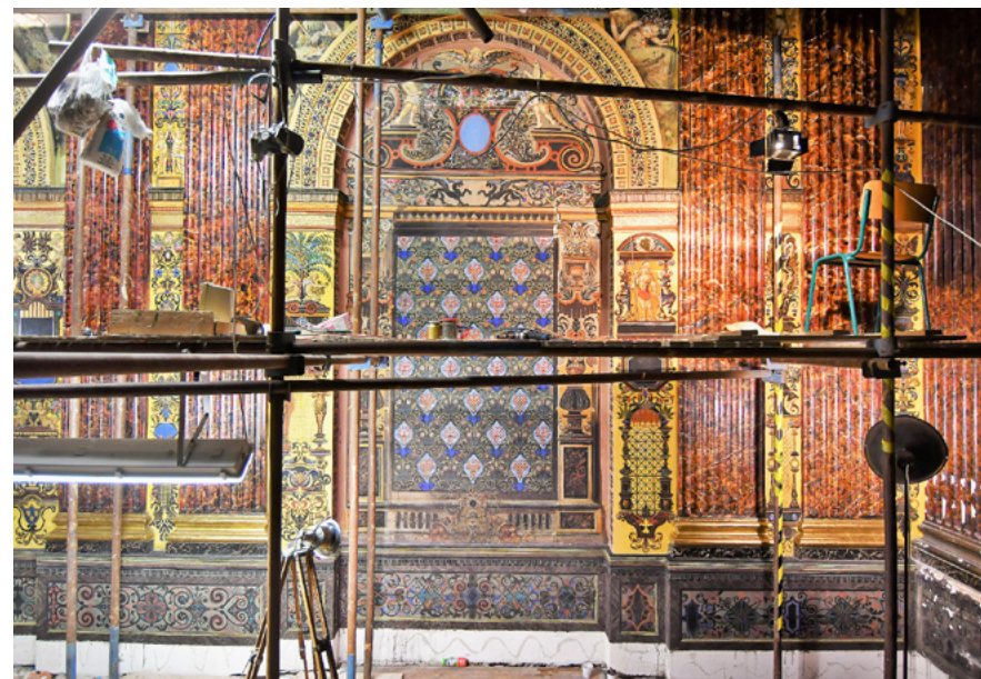
④ Olomouc, FZŠ Komenium, pohled na stěnu sálu po dokončení retuší, 2017. Foto Radomír Surma.
