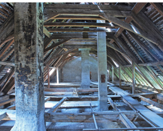
5 Plumlov, zámek, průhled podkrovím severního křídla předzámčí, 2012. Foto Ondřej Belšík.
