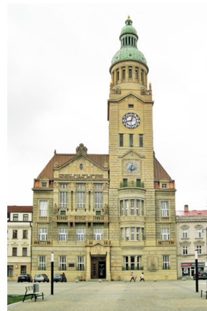
② Prostějovská Nová radnice po obnově. Foto Archiv NPÚ, ÚOP v Olomouci.
