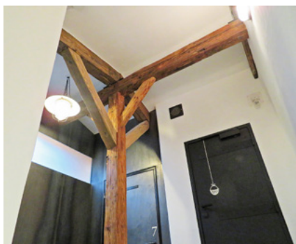
20 Olomouc, Denisova č. o. 33, pohled do chodby v podkroví po rekonstrukci, 2017. Foto Jan Kubeš.
