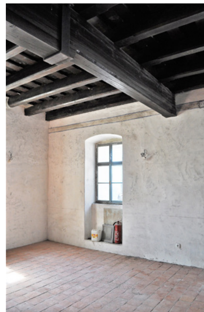
④ Podolí, renesanční tvrz Kobylků z Kobylího. Sál v přízemí s opravených trámovým stropem a novou cihelnou podlahou, 2017. Foto Dušan Rohlík.
