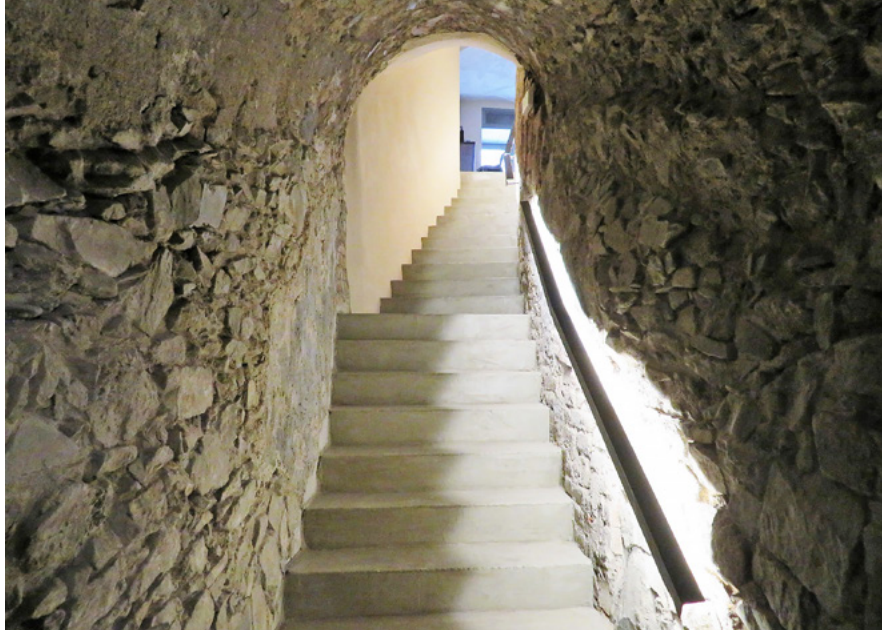
10 Olomouc, Denisova č. o. 33, schody ze suterénu do přízemí po rekonstrukci, 2017. Foto Jan Kubeš.
