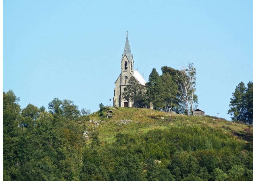
6 Žulová, poutní kostel na Boží hoře, čelní pohled, 2016. Foto Eva Pulkrťová.
