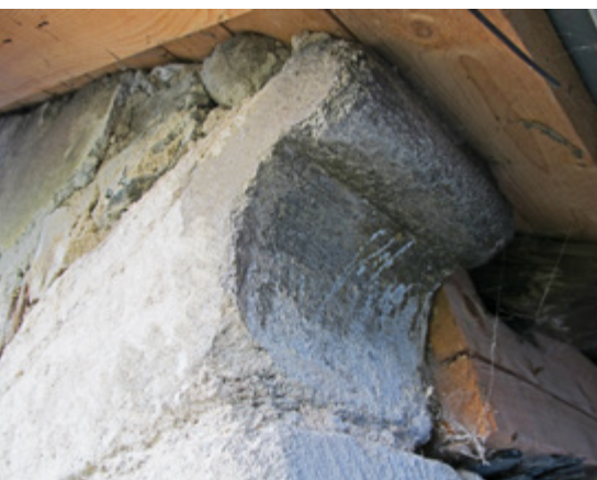
14 Javorník, kostel sv. Kříže, východní nároží kněžiště, ukončující římsový prvek armatury, 2013. Foto Eva Pulkrtová.
