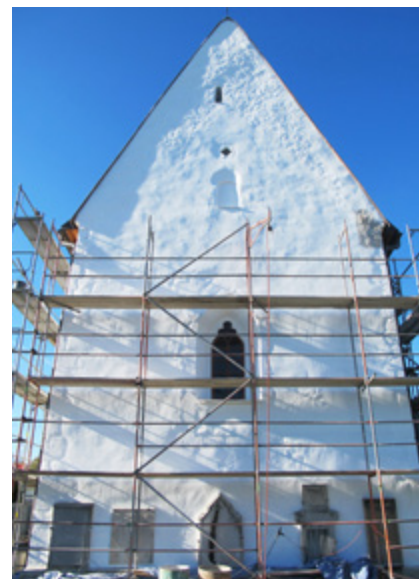
5 Javorník, kostel sv. Kříže, východní štít, dopadající světlo zvýrazňuje původní tvar střechy, ve štítu okénka starších vývojových fází, při ukončení SV nároží (vpravo) pozůstatek červené linky, 2013. Foto Eva Pulkrtová.
