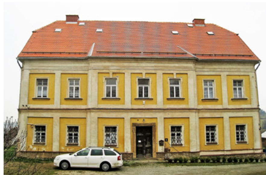
⑤ Fara po opravě střechy a krovu, 2016. Foto Dobroslava Neckařová.
