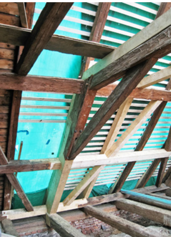
② Detail opravované konstrukce krovu, 2016. Foto Dobroslava Neckařová.
