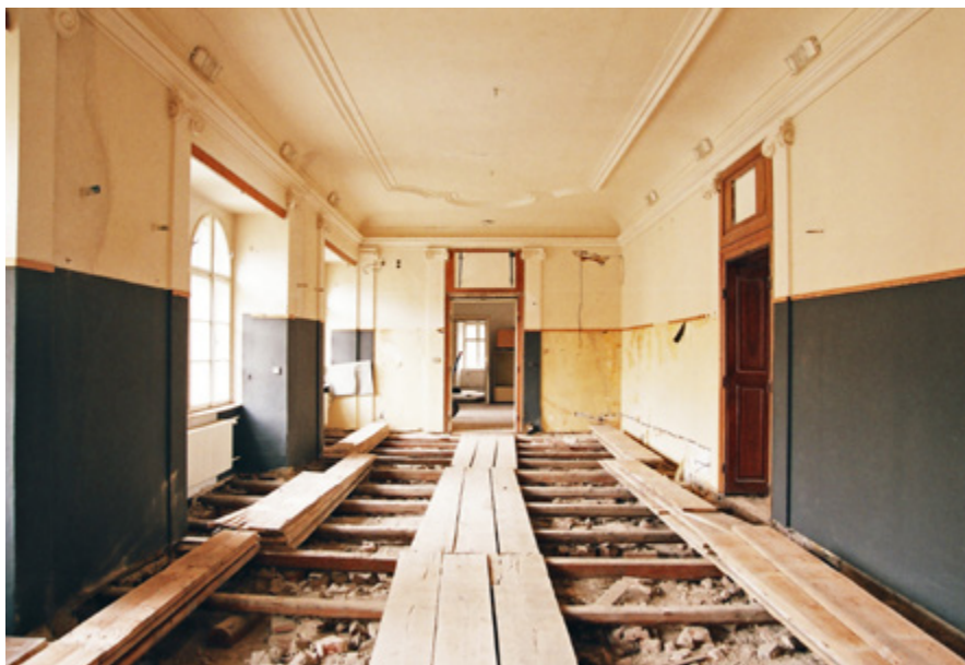
5 Rodová galerie před rekonstrukcí. Foto Jaromír Král.
