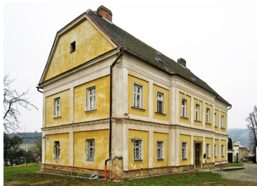
④ Fara před opravou střechy a krovu, 2014. Foto Dobroslava Neckařová.
