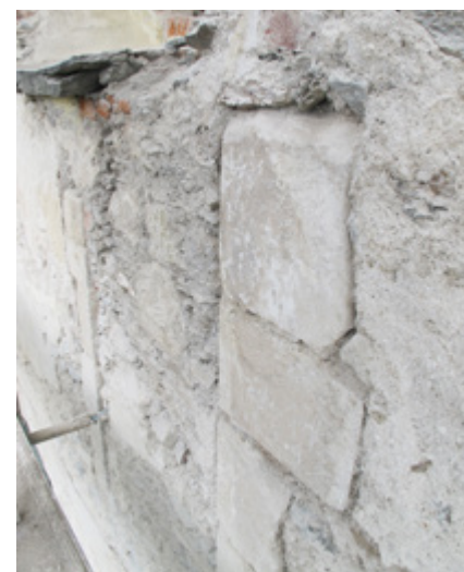
3 Javorník, kostel sv. Kříže, jižní strana kněžiště se zazděným gotickým oknem, 2013. Foto Eva Pulkrťová.
