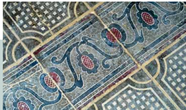
Detail der Fliesen im Hausflur
