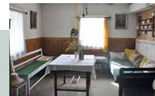
Interieur der Wohnstube vor Beginn der Sanierungsarbeiten im Jahr 2015
