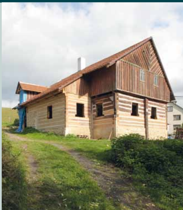
Blick von Südwesten, Herbst 2017
