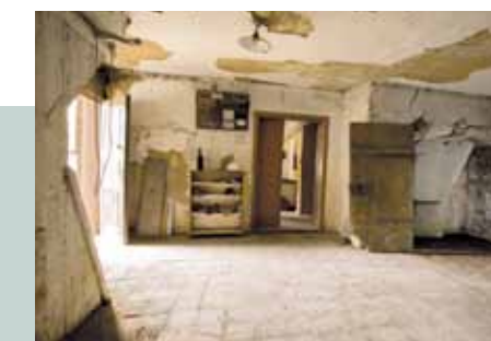
Interieur des Hausflurs mit der Nische der schwarzen Küche
