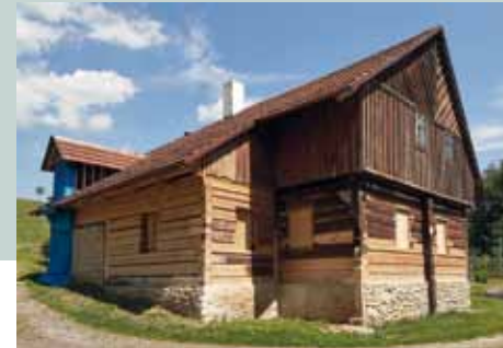
Stand der Sanierung des Hauses zum Juni 2017
