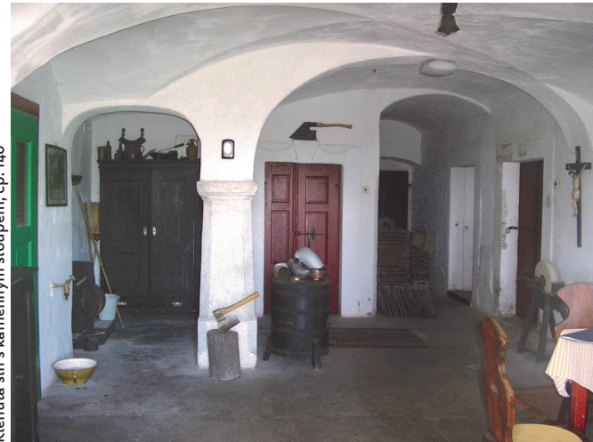
Klenutá síň s kamenným sloupem, čp. 140
