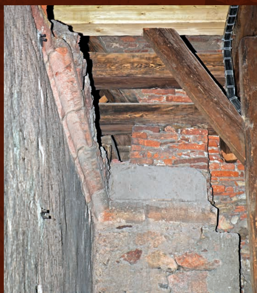
Přízvední klenební oblouky na půdě presbytáře (vlevo); detaily zbytků původní korunní římsy presbytáře na půdě (uprostřed) a v exteriéru (vpravo)
