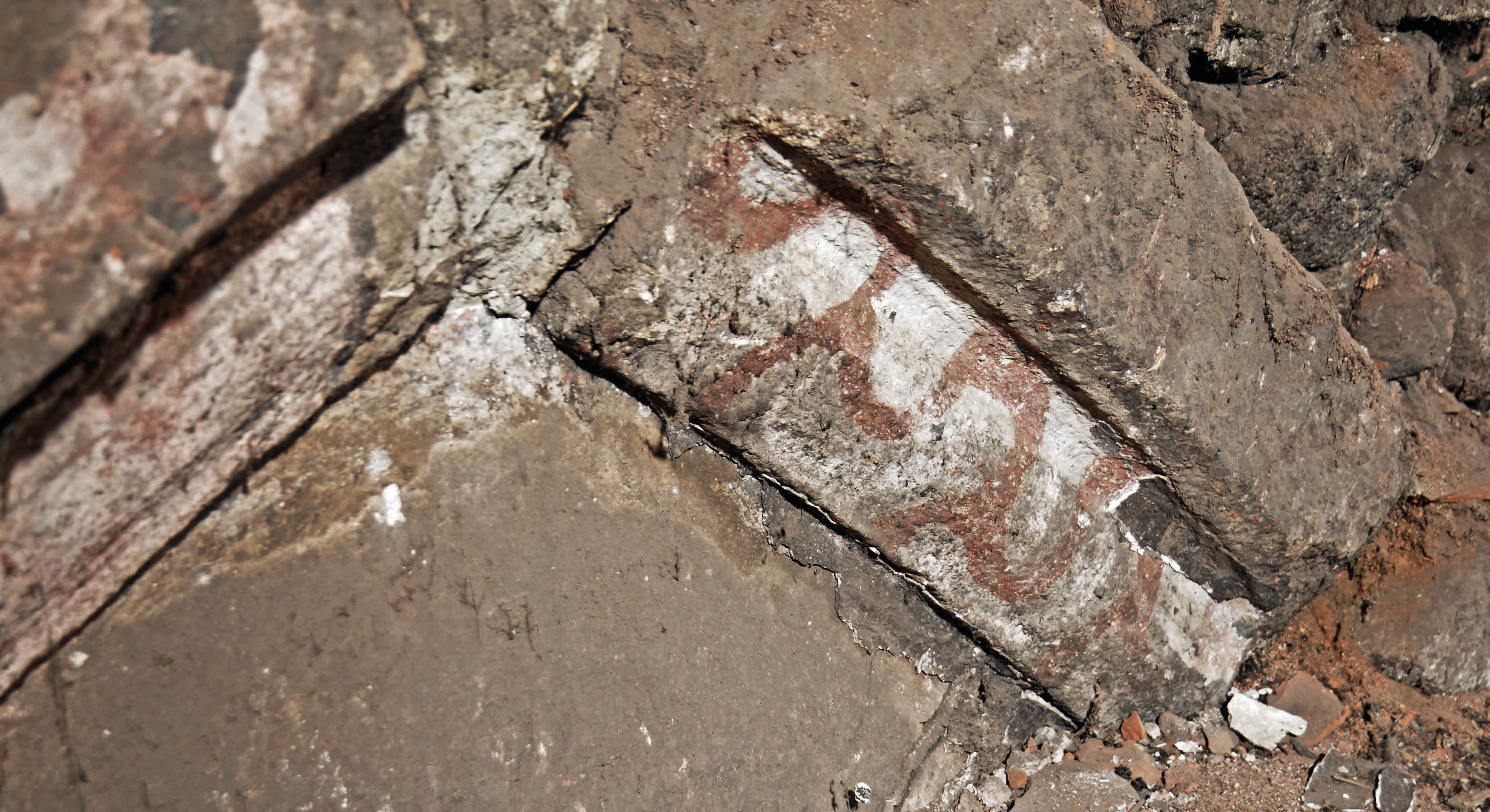
Detail polychromie přízvedních klenebních oblouků na půdě presbytáře
