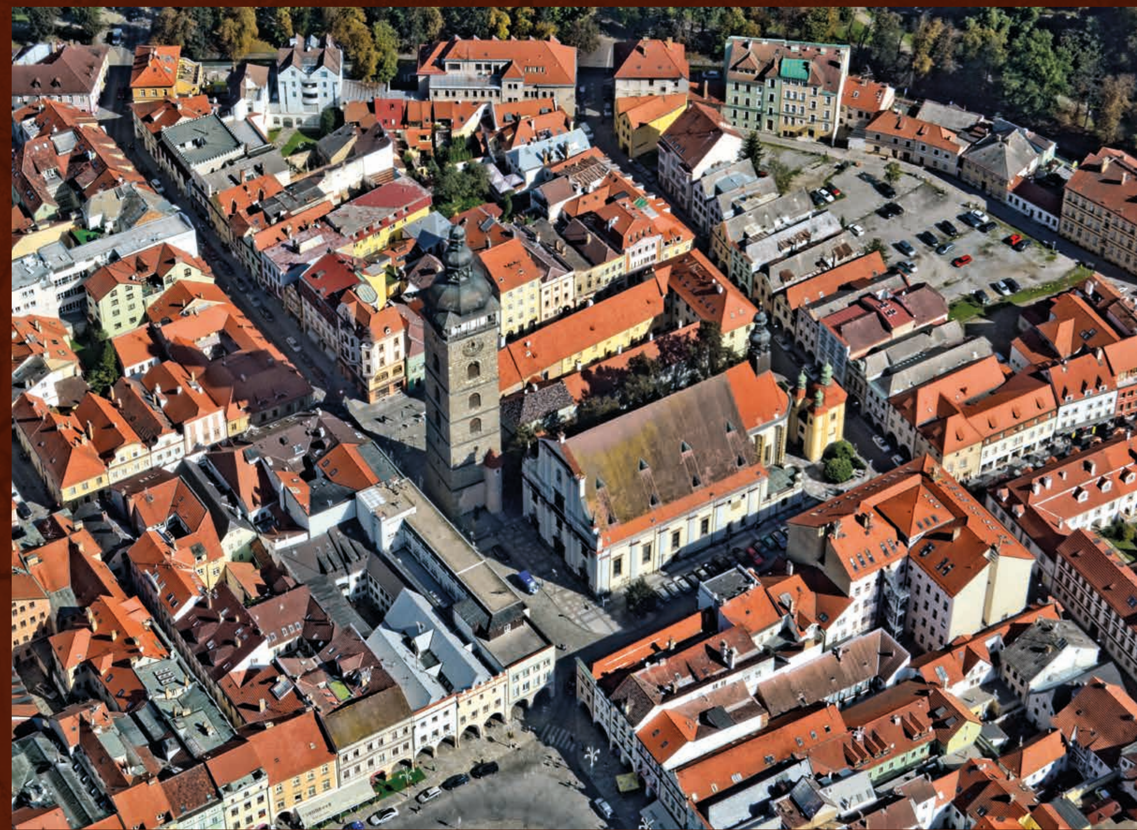
Kostel sv. Mikuláše a přilehlé centrum města z leteckého pohledu, 2014
