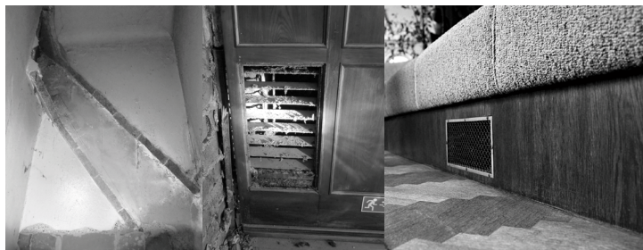
Obr. 8 Kalorifer ve vile Löw-Ber v Brně (foto Jan Čevonák), pilinový filtr a skrápěcí sprcha ve vile Tugendhat (foto Petr Svoboda)
