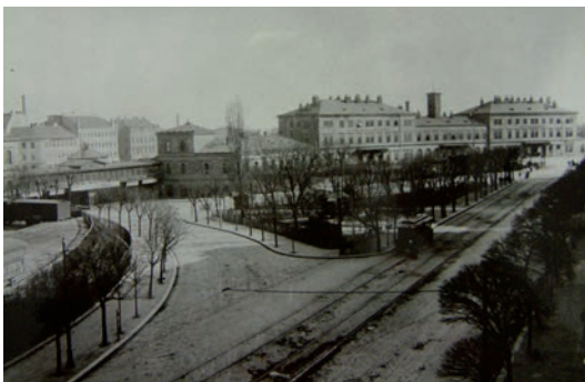
Prostor před hlavní budovou nádraží, 1902. Foto Archiv města Brna.
