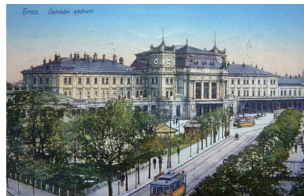
Prostor před hlavní budovou nádraží, 1915. Foto Archiv města Brna.
