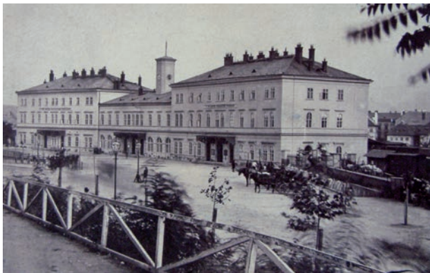
Prostor před hlavní budovou nádraží, 1867. Foto Archiv města Brna.
