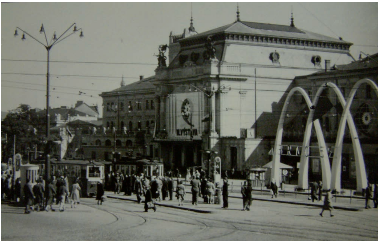
Prostor před hlavní budovou nádraží, 1959. Foto Archiv města Brna.
