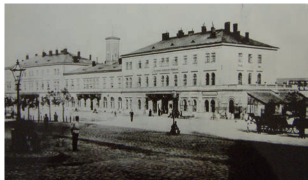
Prostor před hlavní budovou nádraží, 1897. Foto Archiv města Brna.
