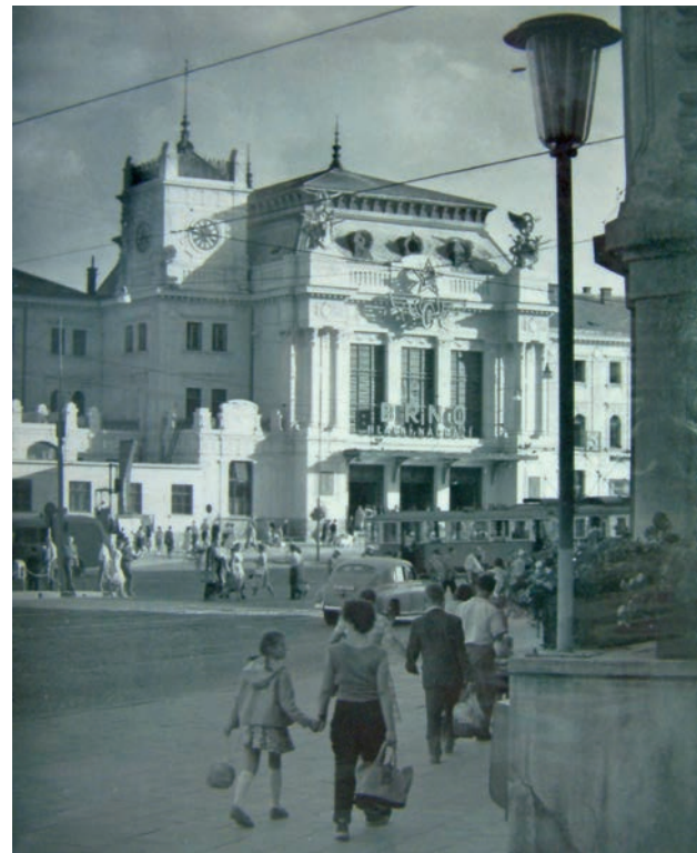
Prostor před hlavní budovou nádraží, 1962. Foto Archiv města Brna.
