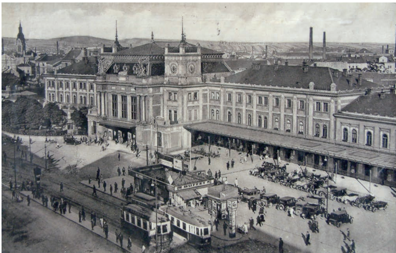
Prostor před hlavní budovou nádraží, 1931. Foto Archiv města Brna.
