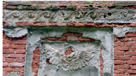
Detail štukové výzdoby severní fasády hrobky. Foto červen 2005.
