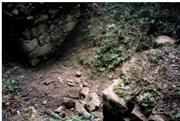
Obr. 9 Veveří. Zdiva s průchodem vně hradby na opyši odkrytá výzkumem L. Konečného v roce 1987. Pohled od severu.
