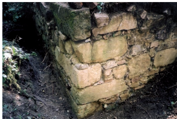
Obr. 10 Veveří. Jihozápadní část zdiva odkrytého výzkumem L. Konečného v roce 1987. Pohled od severu.
