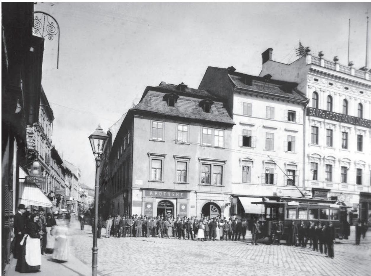
Brno-město – nám. Svobody 1. Dům U zlatého orla čp. 95. Dům čp. 95 s lékárnou C. Sontaga před úpravou průčelí a střechy (asi 1898–1900) na anonymní fotografii (J. Kunzfeld ?). Archiv města Brna.
