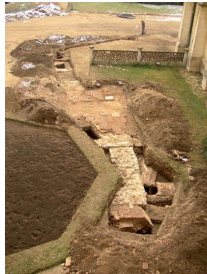
Obr. 45 Lednice – zámek. Relikty zdív kostela sv. Jakuba Většího a barokní kanalizace v poloze č. 1. Celkový pohled od severovýchodu.
