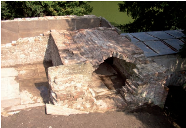
Obr. 38 Lednice – zámecký park. Akvadukt a pekle. Zaklenutá část nádrže akvaduktu na temeni umělé jeskyně. Pohled od západu.
