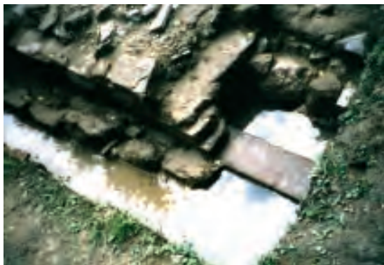
Sonda č. 3 – detailní pohled na prostý nezdobený průchod západní stěnou do podvěží (?) od severovýchodu.
