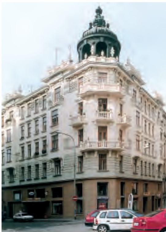
Nároží domu Veselá 2 – Zámečnická 8, stav po opravě r. 2001.
