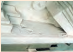
Details des sekundären Einsetzens des Grabsteins über dem Portal der Kirche St. Michael in Brno.
