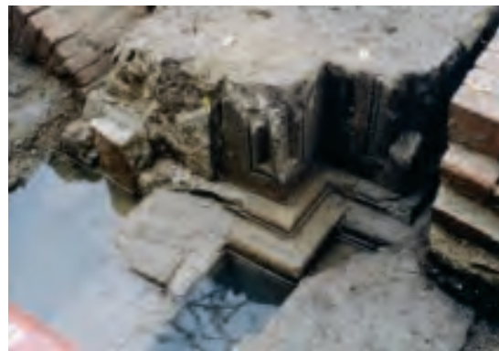
Sonda č. 1 – detailní pohled na dochovanou pravou stranu románského vstupního portálu od severovýchodu.
