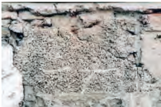
Detail struktury rustiky.
