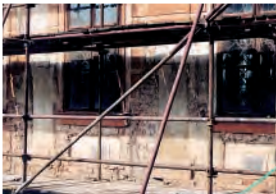
Přizemí jihozápadního křídla v průběhu prací v roce 2002 s odhalenými kamennými pilíři arkády.
