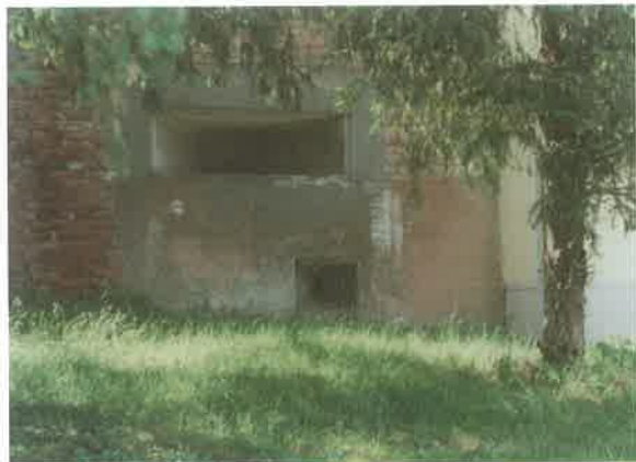
Pohled na levou stěnu objektu LO vz. 37 A-160, zvláštní úprava. Stavební úsek 6-Mikulov, objekt č. 46, severně od Hlohovce. Objekt je zabudován do nájezdové rampy Hraničního zámku.
