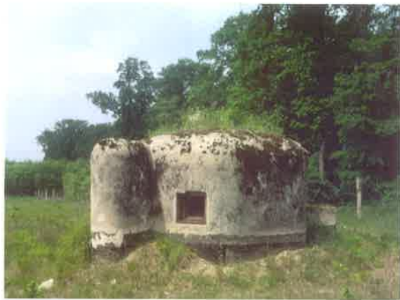
Pohled na levou střílnu, ochranné křídlo, tylovou stěnu, s dobře patrnou vrstvou izolačního nátěru a vstupní šachtou objektu LO vz. 37 A-12N. Stavební úsek 8-Břeclav, část 8b-Pohansko, objekt č. 18*, západně od loveckého zámečku na Pohansku.
