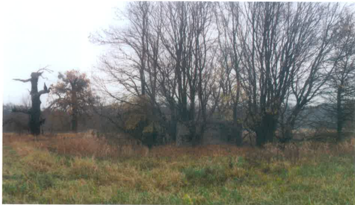
Čelní pohled na dvoustřílnový objekt LO vz. 36, umístěný ve volném terénu. Stavební úsek Břeclav, objekt č. 172, louky na břehu Dyje jižně od Černého jezera.
