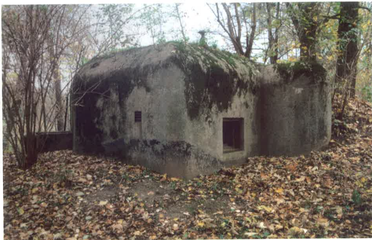
Pohled na pravou stěnu, ochranné křídlo (prodloužená čelní zeď) a tylovou část se vstupní šachtou objektu LO vz. 37 A-120 N. Stavební úsek 8-Břeclav, část 8b-Pohansko, objekt č. 16*, jižně od archeologické lokality Pohansko.
