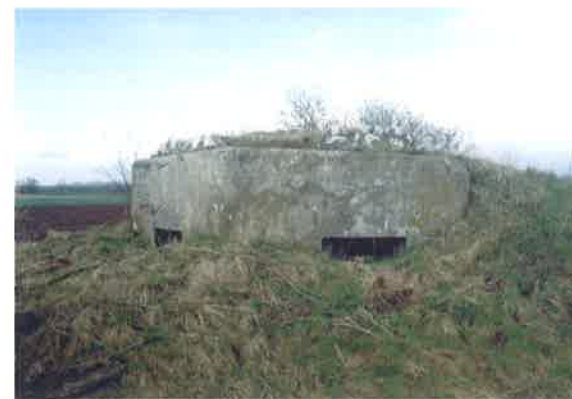
Pohled na levou a střední stěnu třístřílnového objektu LO vz. 36 s patrnými pozdějšími zastracími úpravami (oka pro uchycení maskovacích sítí, na střeše přibetonované kameny). Stavební úsek Břeclav, objekt č. 152, severovýchodně od Charvátské Nové Vsi.
