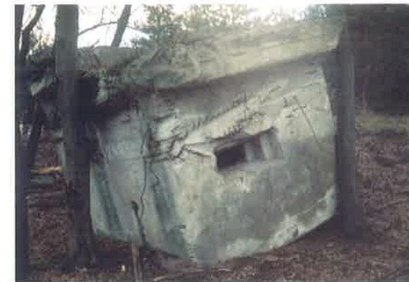
Pohled na pravou stěnu, čelní stěnu a základovou desku převráceného dvoustřílnového objektu LO vz. 36. Stavební úsek Břeclav, objekt č. 155, východně od Charvátské Nové Vsi.
