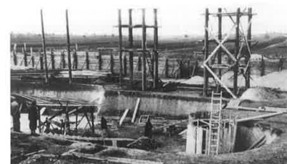
Výkopová jáma pro objekt těžkého opevnění u Chvalovic na Znojemsku. Ilustrační fotografie. (Dobová pohlednice z roku 1938, foto označeno K. Mather, Znaím, 230: Grossbunker bei Kallendorf im Baum)
