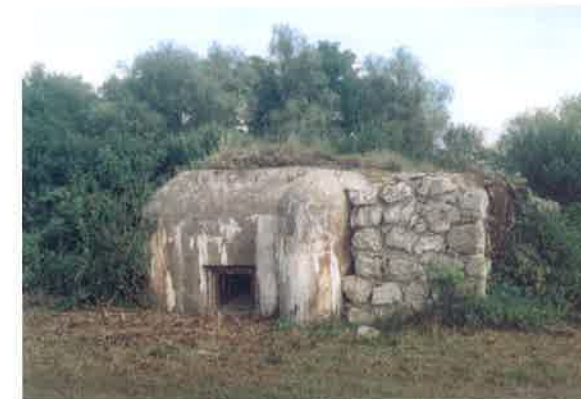
Pohled na pravou stěnu objektu LO vz. 37 A-160 Z s výraznou pozdější maskovací úpravou (kamenná zeď místo záhozu). Stavební úsek 6-Mikulov, objekt č. 44, u Rybárny na severním břehu vodní nádrže Nesyt.
