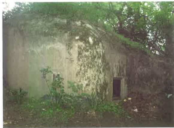
Pohled na pravou (sníženou) část lomeného objektu LO vz. 37 A-140 N zabudovaného do valu staroslovanského hradiště. Stavební úsek 8-Břeclav, část 8b-Pohansko, objekt č. 15*, Pohansko.
