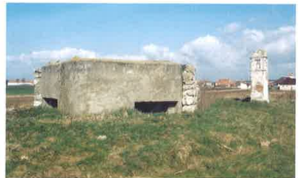
Čelní pohled na dvoustřílnový objekt LO vz. 36 s patrnými pozdějšími zastíra- cími úpravami (kamenná obezdívka bočních stěn). Stavební úsek Břeclav, ob- jekt č. 153, před západním okrajem Charvátské Nové Vsi.
