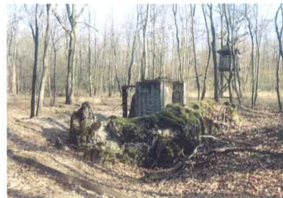
Pozůstatky objektu LO vz. 37 A-140 N rozvaleného explozí uvnitř umístěné nálože. Stavební úsek 8-Břeclav, část 8a-Poštorná, objekt č. 29. Boří les, západně od Charvátské Nové Vsi.
