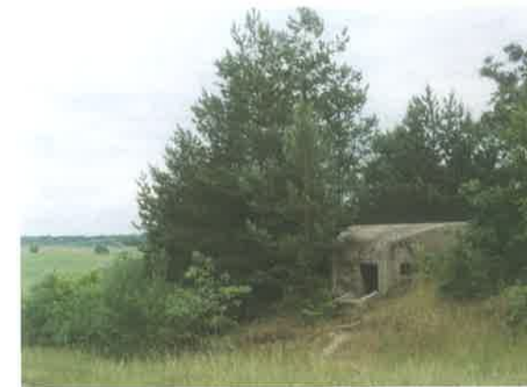
Pohled z týlu na vchod do dvoustřílnového objektu LO vz. 36 opatřený vstupní šachtou. Stavební úsek Břeclav, objekt č. 169, Hraniční louky jižně Poštorné.
