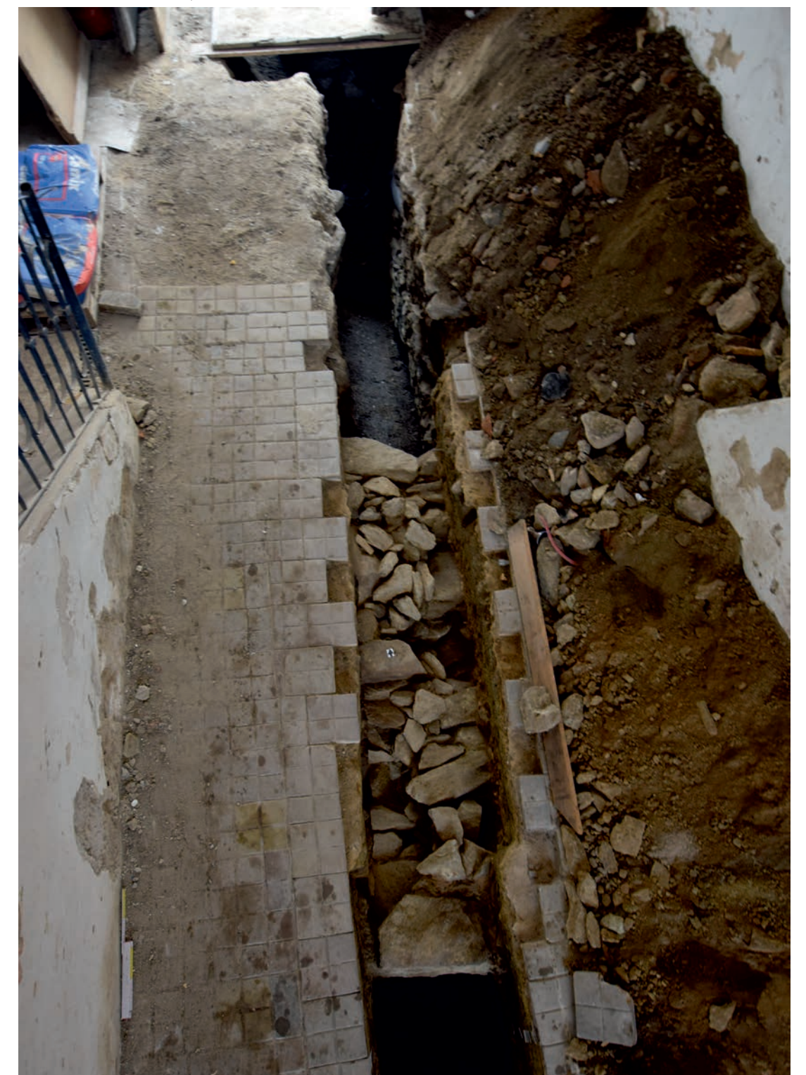
Začištěná koruna jižní stěny zasypaného zděného sklepa
