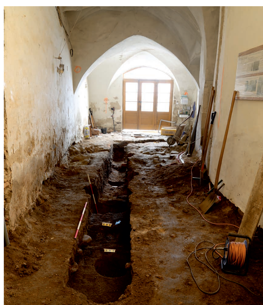
Dokumentovaný výkop kanalizace a snížené úrovně průjezdu v pohledu do dvora.
