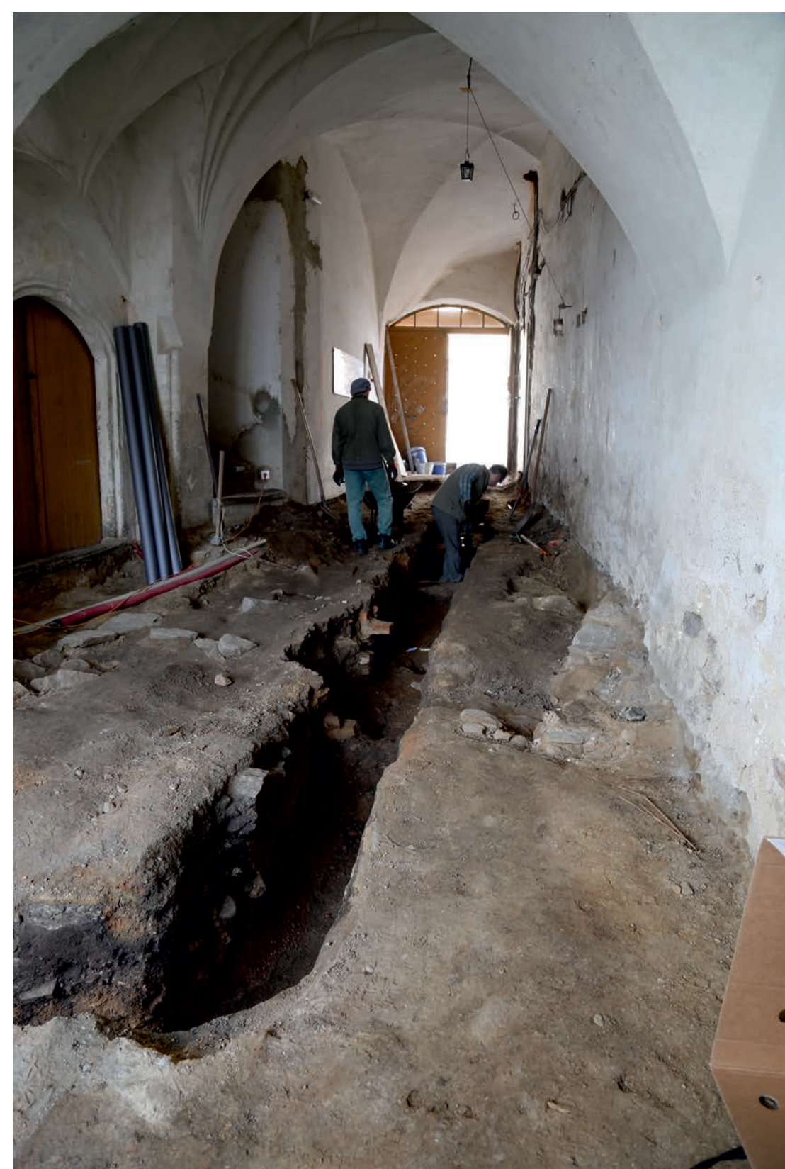
Dokumentovaný výkop kanalizace a snížené úrovně průjezdu v pohledu do ulice.
