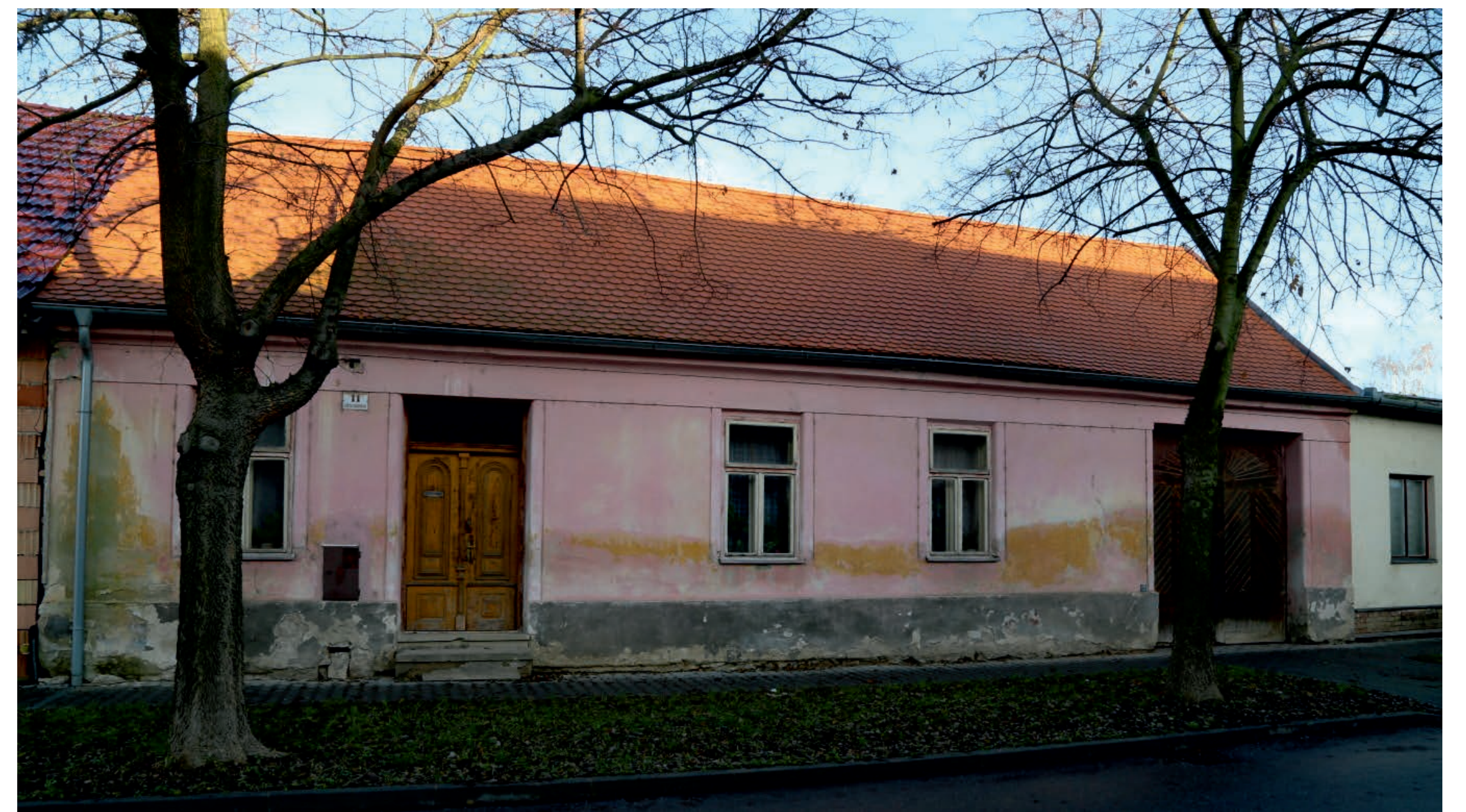
Podoba usedlosti před započatím rekonstrukce.
