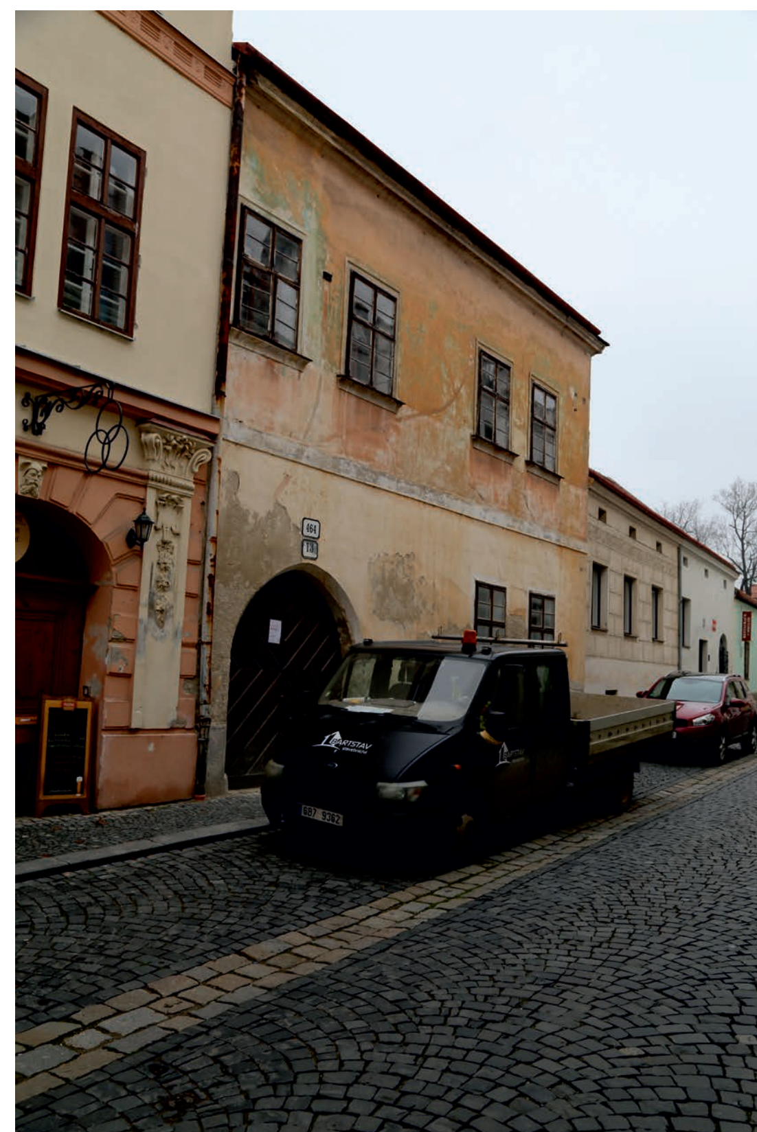
Pohled na dům Velká Mikulášská 13 v průběhu rekonstrukce.
