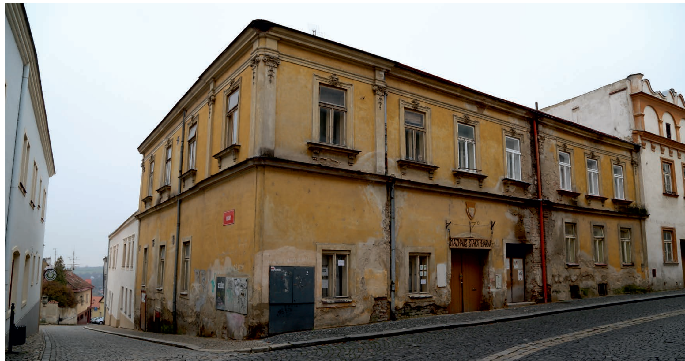
Pohled na dům Velká Mikulášská 3 v průběhu rekonstrukce.
