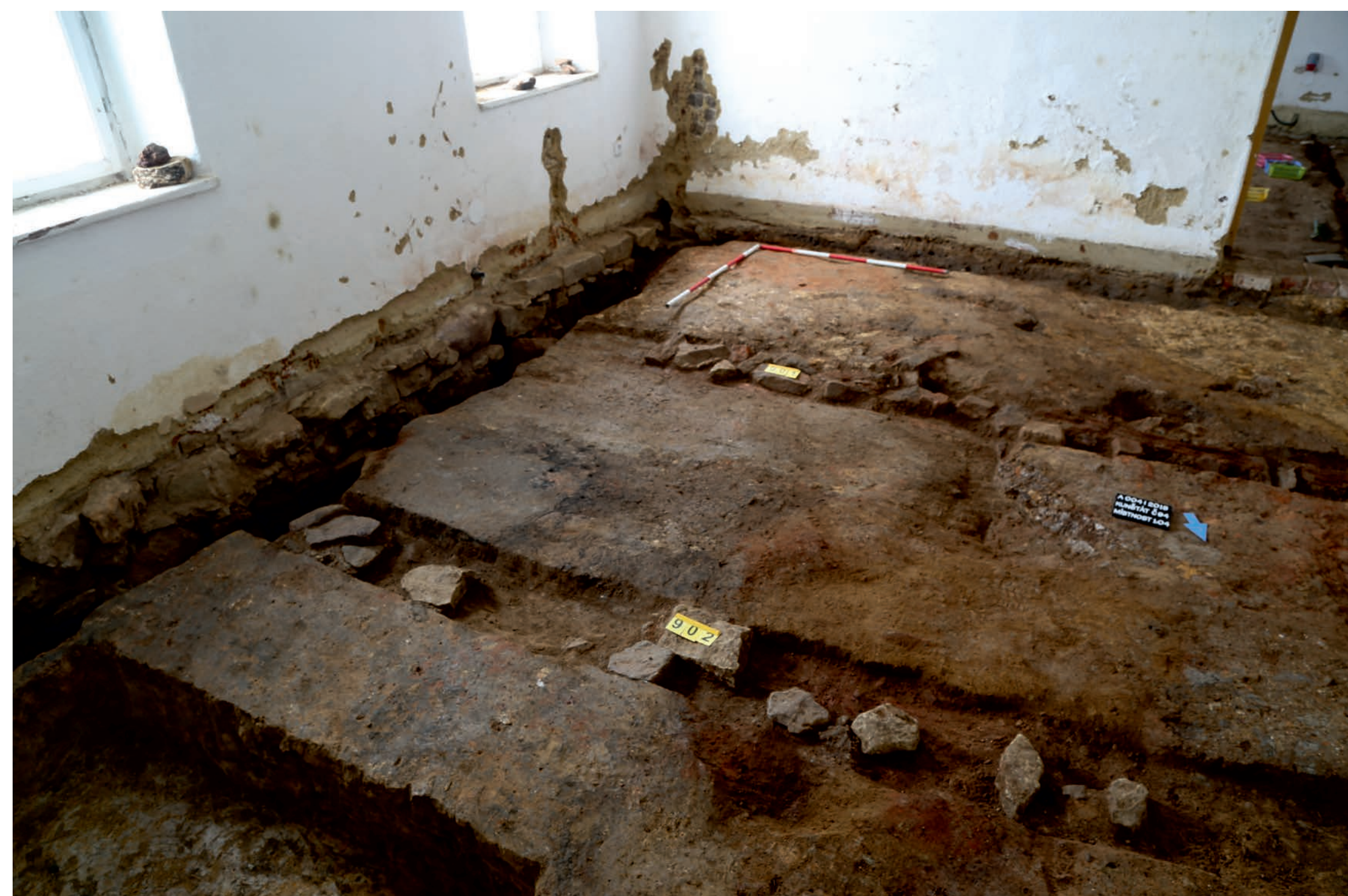
Historické podlahy byly založeny na dřevěných roštích, které byly proti vlhkosti chráněny podložením kameny.
