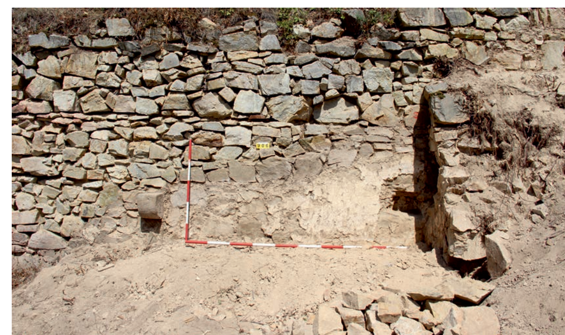
Objev konzoly původního ochozu na vnitřním líci hrabdy hradního jádra. Situace byla po dokumentaci zajištěna a znovu zasypána.
