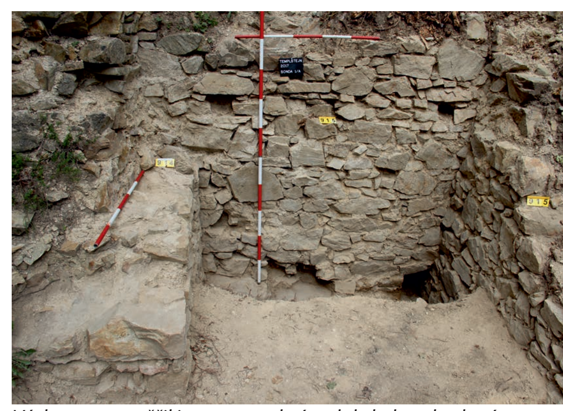
Výzkum se zaměřil i na prostor brány, kde bylo vybudováno nové schodiště. Na snímku čelo brány s patrnými kapsami, nejspíše po vstupní rampě.
