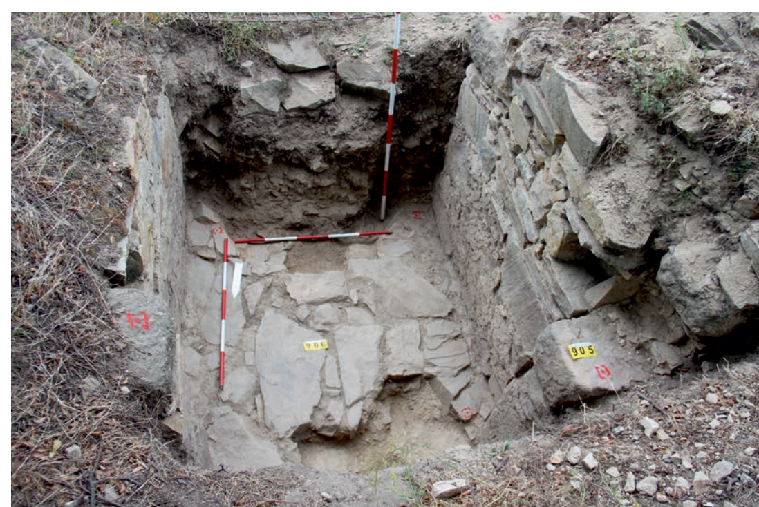
V rámci revize byla znovu začistěna branka severního vstupu do hradního jádra. Dobře patrné byly kapsy po závoře a další stavební detaily. Po zdokumentování byla celá situace zajištěna a zasypána.
