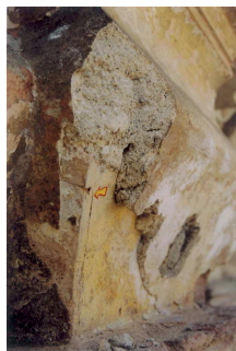
Detail omítkových vrstev – profílce korunní římsy na nároží jižního křídla předzámčí. Na fotografii je patrná primární omítková vrstva překrytá vrstvou omítek z 20. století.
