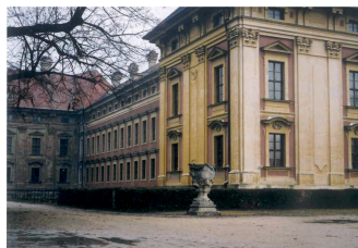
Severní křídlo zámku před opravou v roce 2003. Ve vnitřním rohu severní fasády severního křídla zámku a západní fasády severního rizalitu, kde nebyla dokončena oprava fasády prováděná ve 20. století, byly odebrány vzorky omítkových vrstev.
