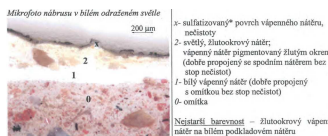
Mikrofoto nábrusu – zkoumané vzorky odebrané ve vnitřním rohu severní fasády severního křídla zámku a západní fasády severního rizalitu, tedy v místě, kde nebyla dokončena oprava fasády prováděná ve 20. století
