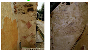
Obr. 4 – Diamantování kolem oken a na nárožích vnějších fasád jihovýchodního a jihozápadního křídla, 20. léta 16. století
