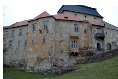
Obr. 1 – Prvky původního řešení obytné věže – šterbinová okénka s hlazenými paspartami, nárožní armování, 14. století
