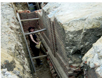
10) Pohled na odkryté opěrné zdi barokních teras
