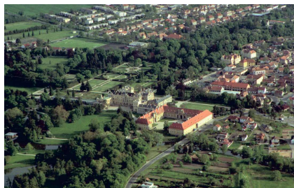
1) Státní zámek Lednice – letecký pohled (foto M. Bálek)
