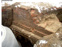
11) Detail opěrné zdi barokní terasy
