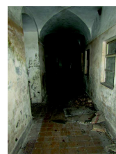
Chodba v přízemí hlavní budovy, současný stav (2013)
