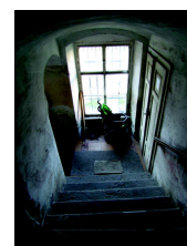
Schodiště do patra hlavní budovy, pohled do přízemí, současný stav (2013)
