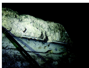
Korunní římsa barokní fáze hlavního křídla, pohled z půdy bočního křídla, současný stav (2014)
