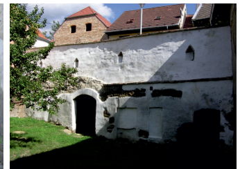
Dvorní pohled, stav po opravě.
