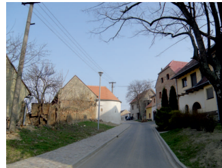
Hradební úsek před opravou – uliční pohled.
