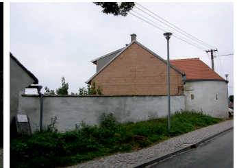
Hradební úsek po opravě.
