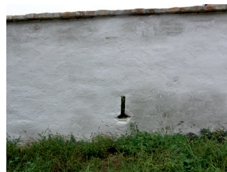
Detail zdiva a klíčové střížny po opravě.
