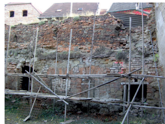
Dvorní pohled – detail zdiva, stav před opravou.
